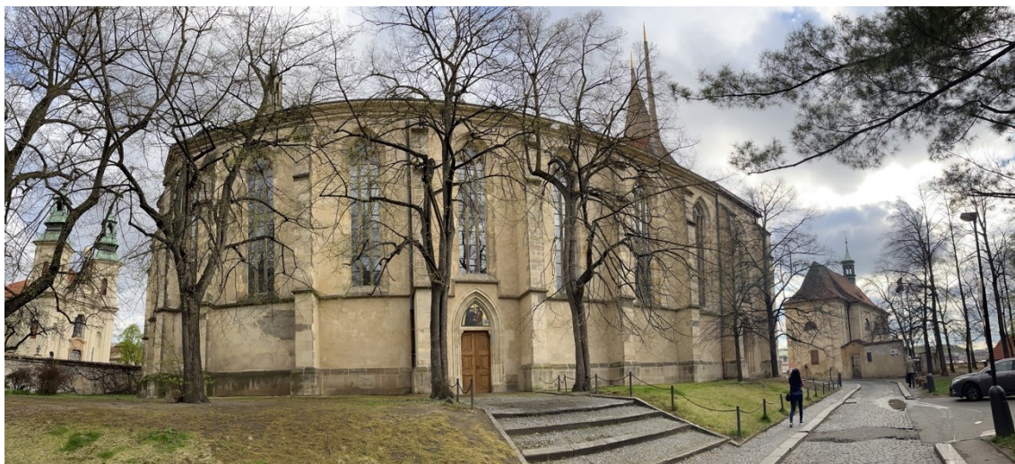
Příloha č. 9: Pohled ze strany na kostel Panny Marie, sv. Jeronýma, sv. Vojtěcha, Prokopa a Cyrila s Metodějem v Emauzích (foto; zdroj: autor)
