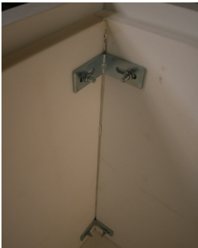
38. Sarkofág Tomáše kardinála Špidlíka , 2010, ukázka spojovacích úchytů, Velehrad, bazilika Nanebevzetí Panny Marie a svatých Cyrila a Metoděje, presbytář
