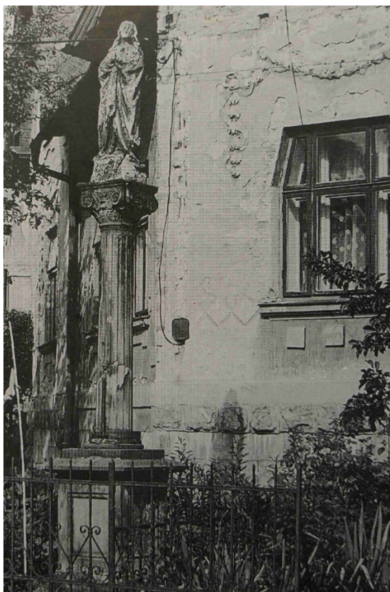
Obrázek 39: Původní umístění Panny Marie zazděné ve zdi v ulici Nádražní
