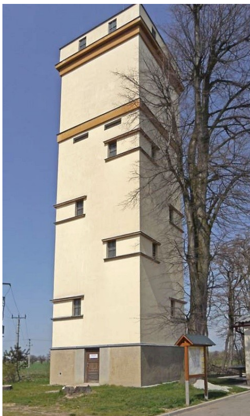
87. Horní Cetno , věžový vodojem (1925–1930), stav k roku 2010
