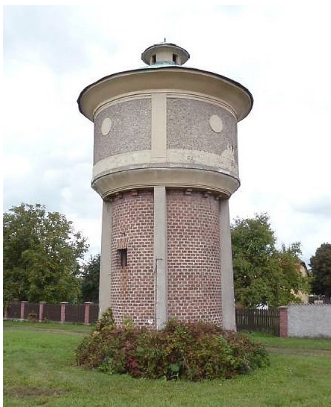
48. Spikaly, věžový vodojem (kolem 1914), stav k roku 2017
