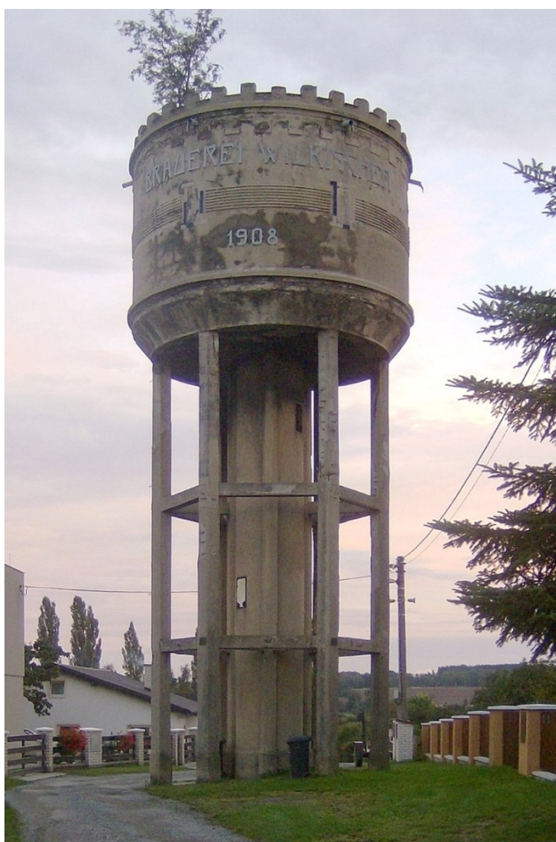
134. Heřmanova Huť , věžový vodojem (1908), stav k roku 2007
