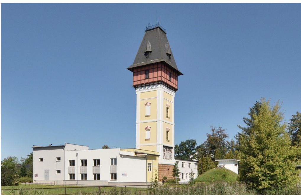
18. České Budějovice , věžový vodojem (založen 1721–1724, přestavba 1882), stav k roku 2020
