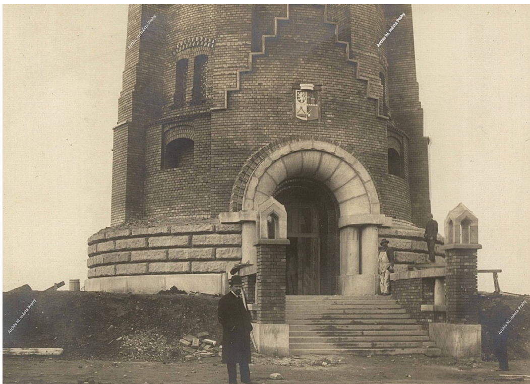
61. Praha-Michle , věžový vodojem (1906–1907), stav k roku 1907, detail vstupu
