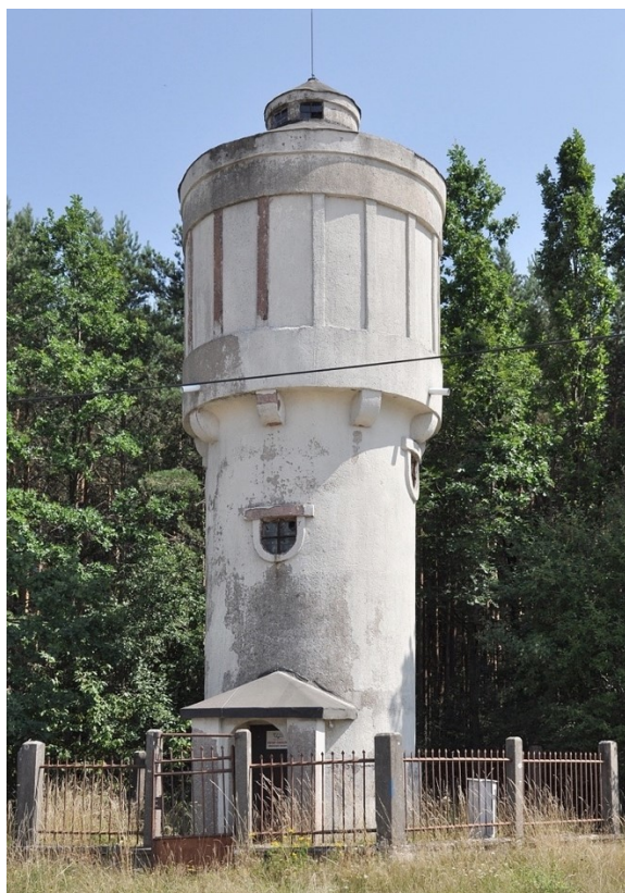
88. Hoříčky , věžový vodojem (asi 1928), stav k roku 2018
