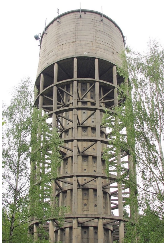
30. Kladno-Rozděllov , věžový vodojem zv. Lesní (1957–1963), stav k roku 2007
