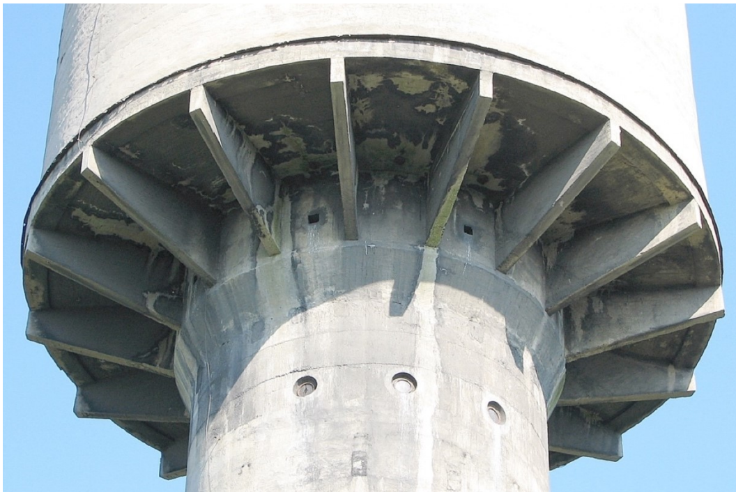
32. Bohumín-Starý Bohumín , věžový vodojem (1963), stav k roku 2009, detail nádrže
