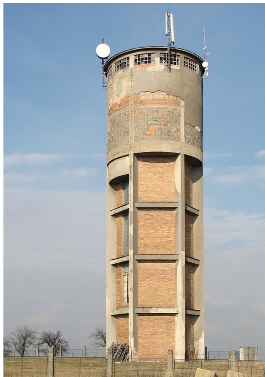
28. Tuřany , věžový vodojem (1957), stav k roku 2007
