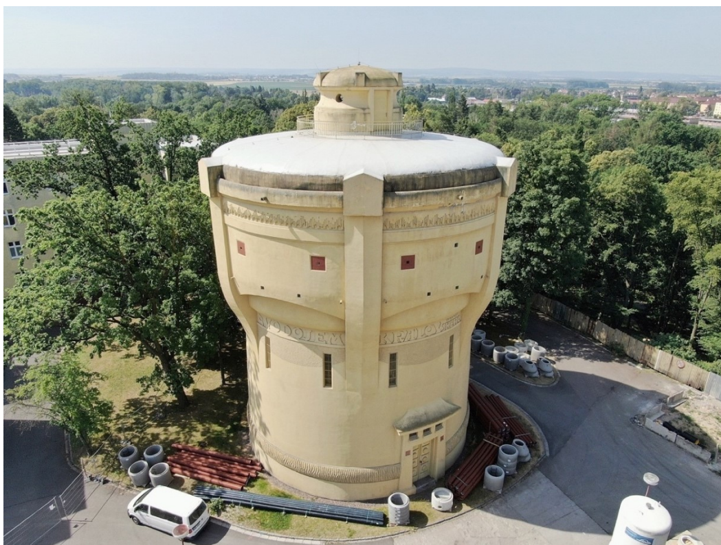
56. Pardubice-Pardubičky, věžový vodojem (1906–1907), stav k roku 2019
