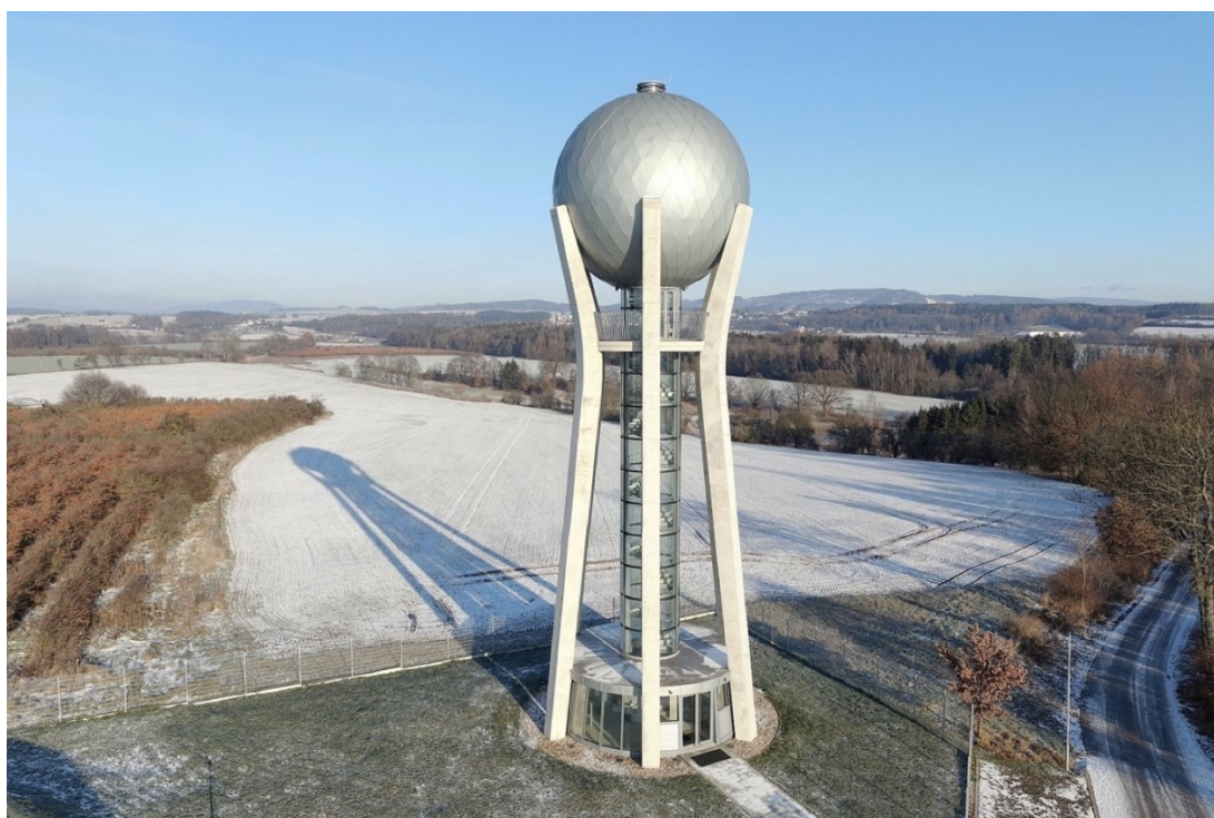
40. Ohrazenice, věžový vodojem (2019), stav k roku 2021
