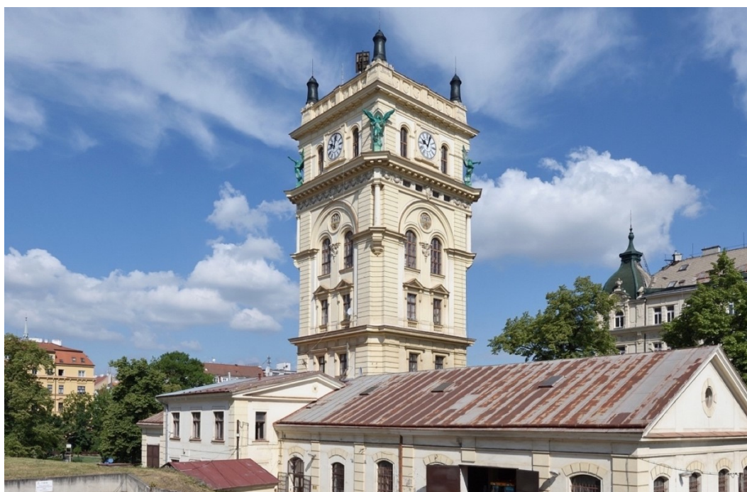
22. Praha-Vinohrady , věžový vodojem (1891), stav k roku 2018
