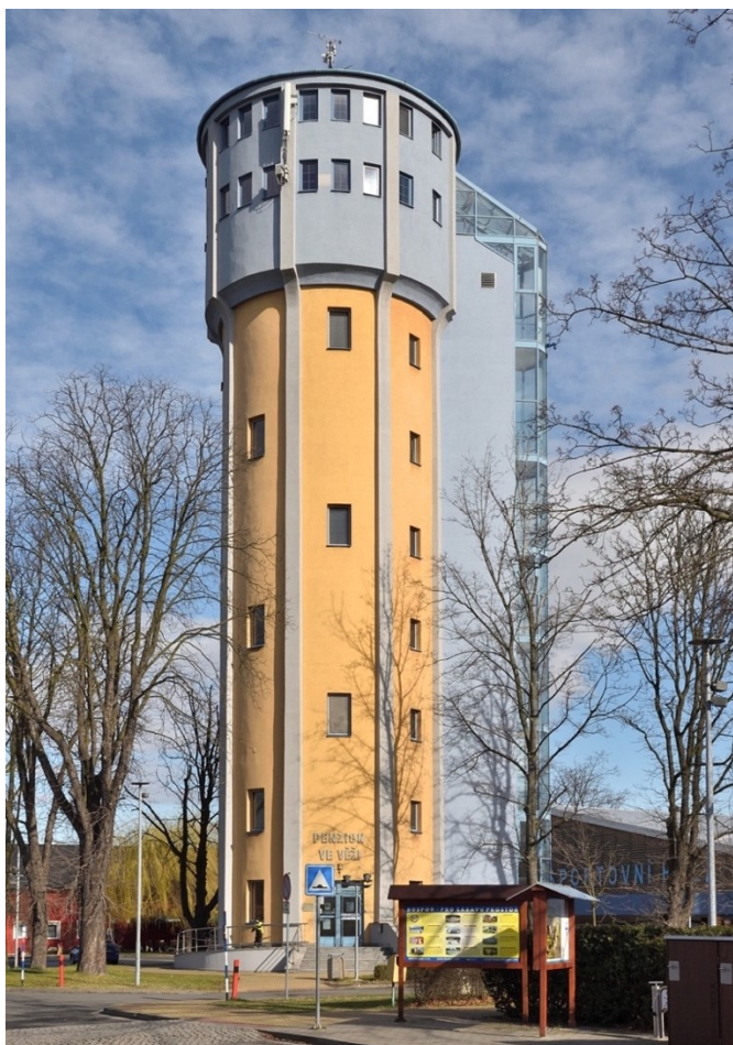
159. Bohumín , konverze věžového vodojemu v Penzion ve věži (1935), 2020
