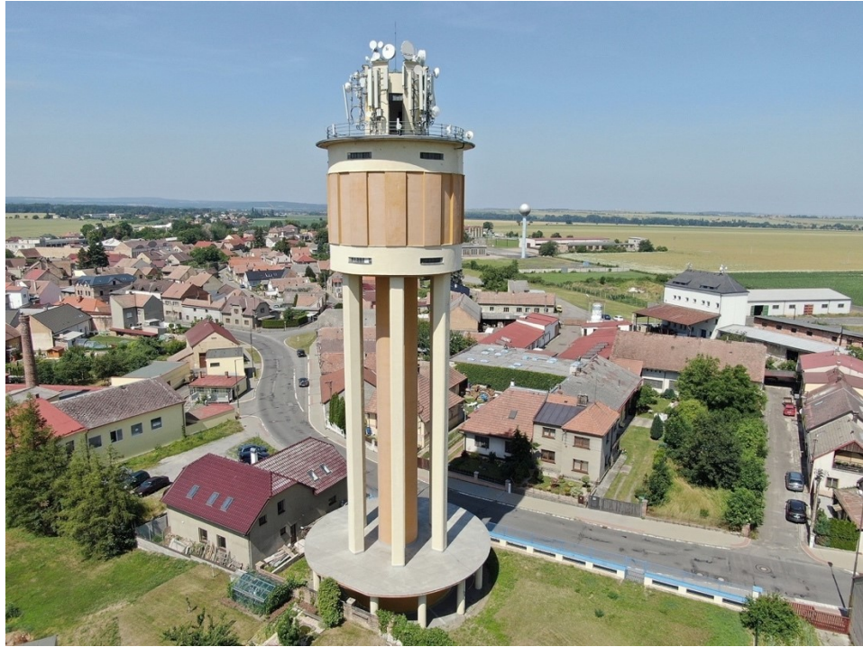
97. Chrast , funkcionalistický věžový vodojem (1929), stav k roku 2019
