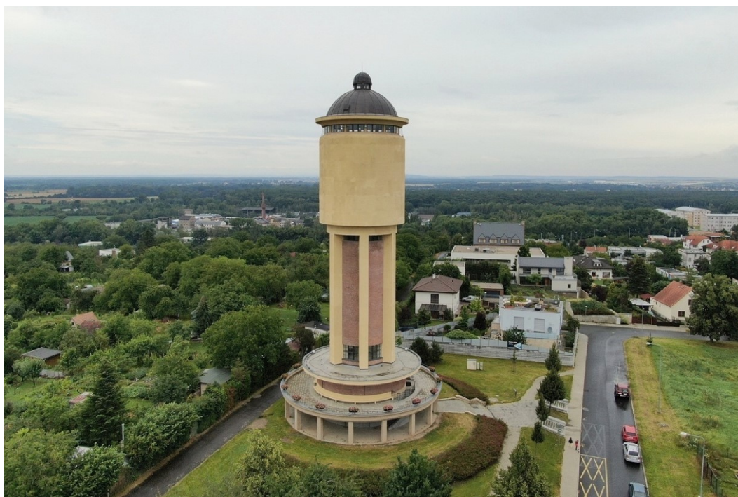
133. Kolín , věžový vodojem (1929–1930), stav k roku 2021, vztah k městu
