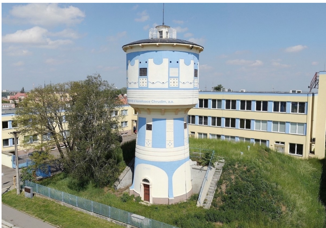
58. Chrudim, secesní věžový vodojem (1910–1913), stav k roku 2019
