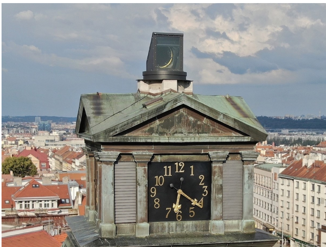
150. Praha-Bubeneč , periskop umístěný v rámci konverze vodojemu (1888), stav k roku 2021
