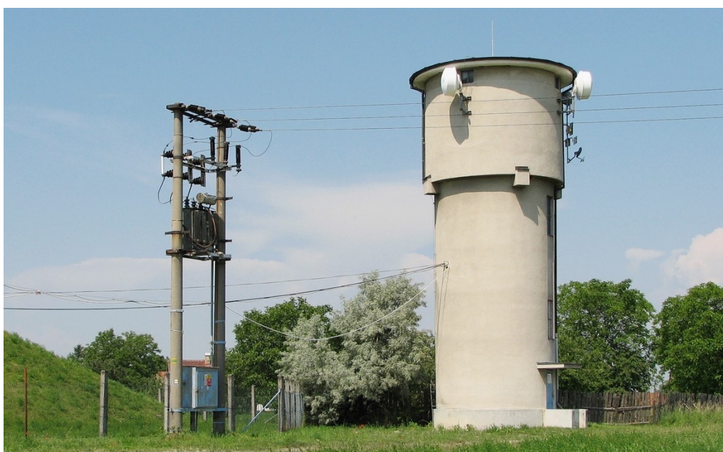
100. Hostín , věžový vodojem (po 1930), stav k roku 2007
