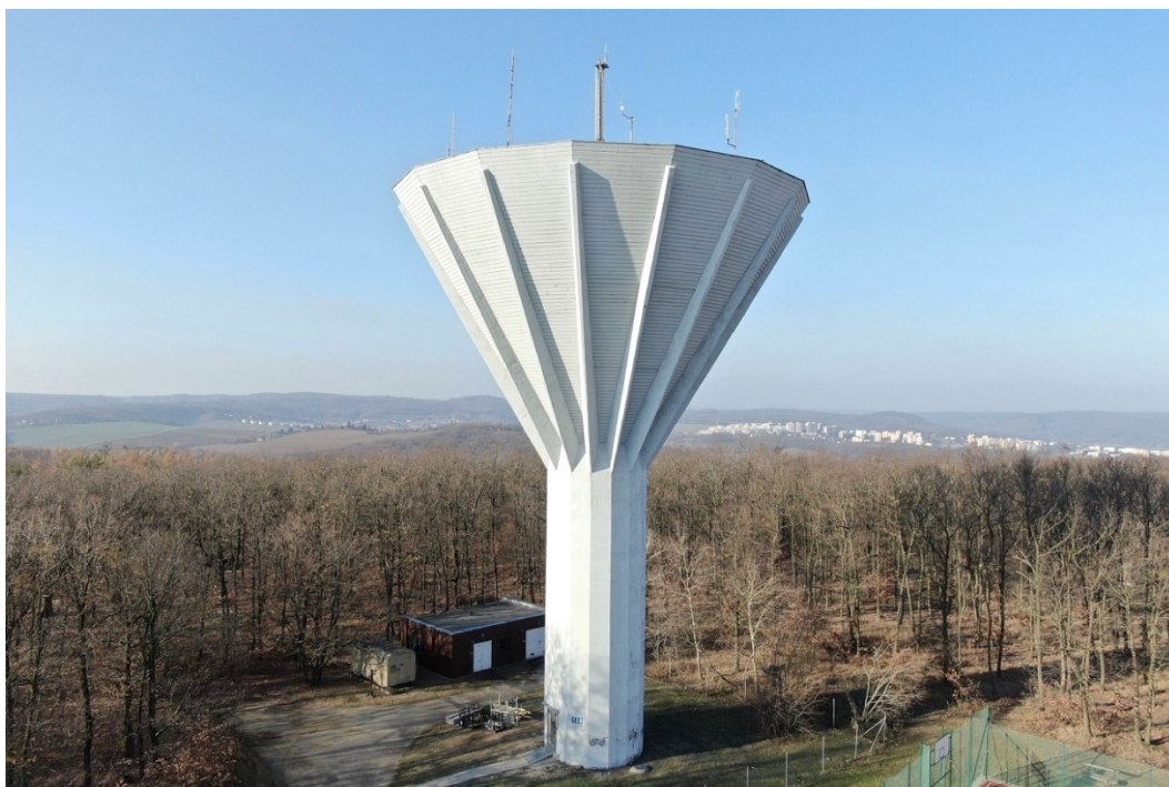
33. Brno-Kohoutovice , věžový vodojem (1973), stav k roku 2018
