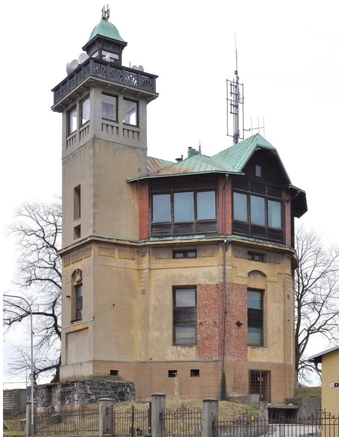
57. Ostrava-Slezská Ostrava, věžový vodojem (1909), stav k roku 2018
