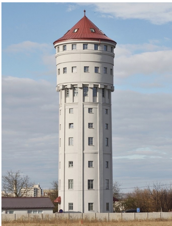
95. Karviná , věžový vodojem (1929), stav k roku 2020
