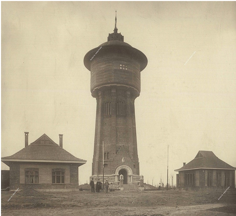
59. Praha-Michle, věžový vodojem (1906–1907), stav k roku 1907
