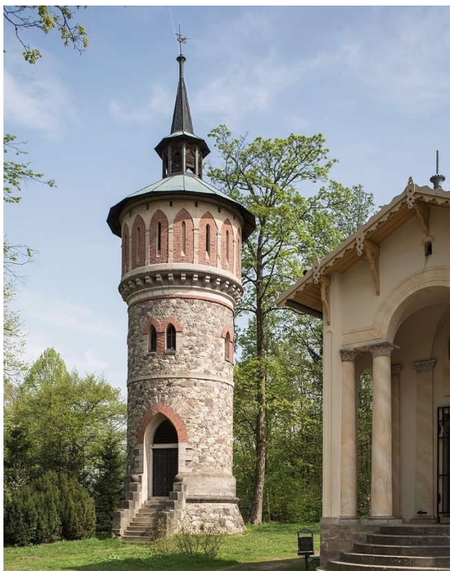
19. Sychrov , věžový vodojem (1891), stav k roku 2018
