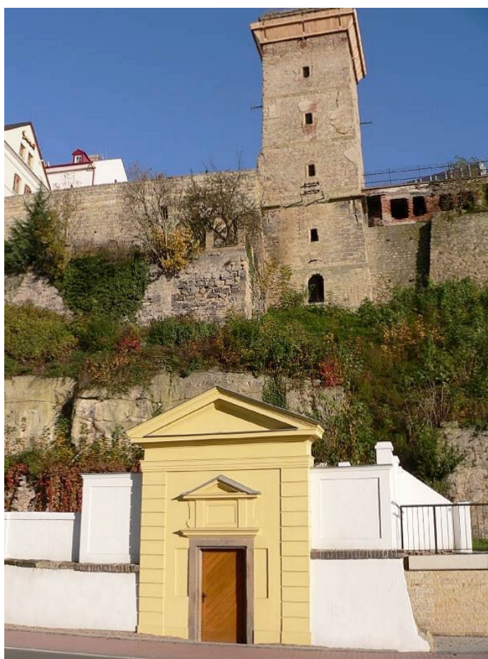
14. Mladá Boleslav , barokní vodárenská věž (založena 1494–1496), stav k roku 2013
