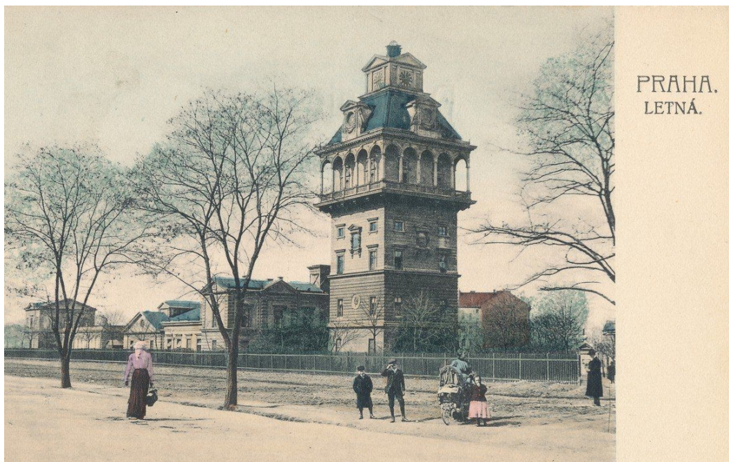
21. Praha-Bubeneč , věžový vodojem (1888), nedatováno
