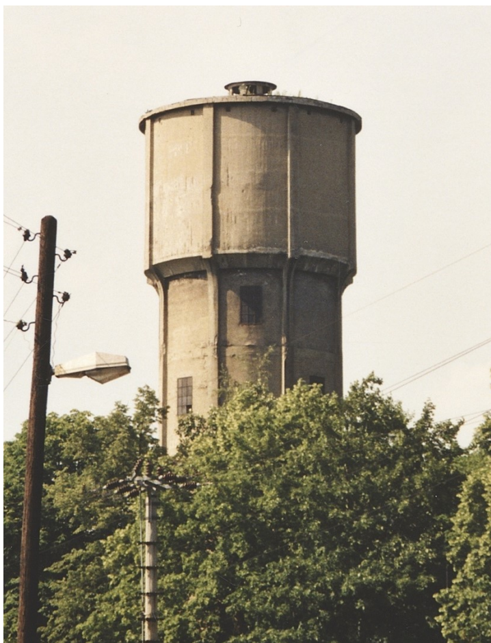
158. Bohumín , věžový vodojem před konverzí (1935), stav k roku 2003
