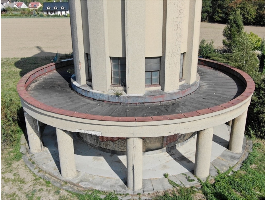
75. Jaroměř , věžový vodojem (1928), stav k roku 2018, detail ochozu
