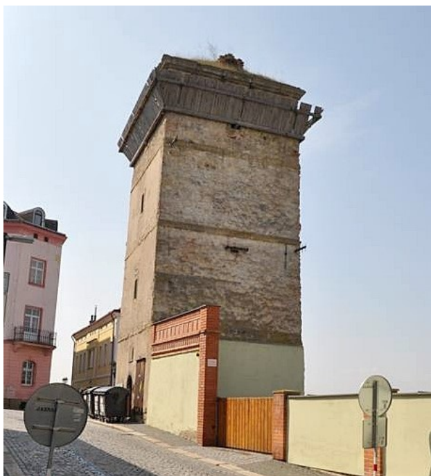
15. Mladá Boleslav , barokní vodárenská věž (založena 1494–1496), stav k roku 2021
