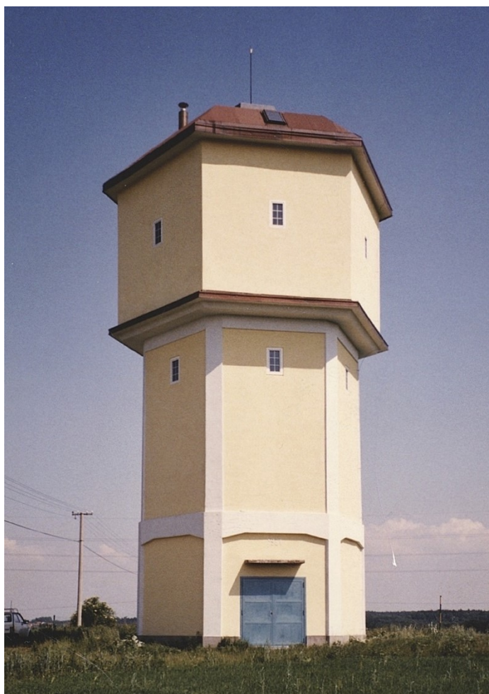
164. Vratimov , věžový vodojem (1931), stav k roku 2003
