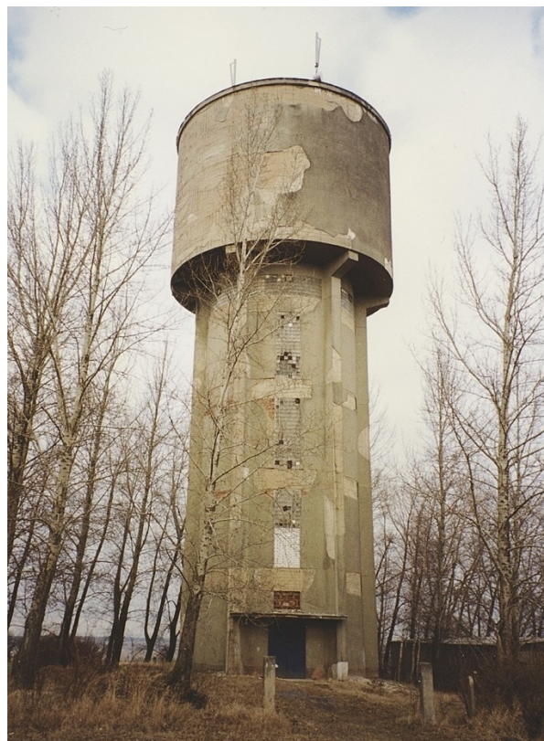
104. Stochov , věžový vodojem (1950), stav k roku 1998
