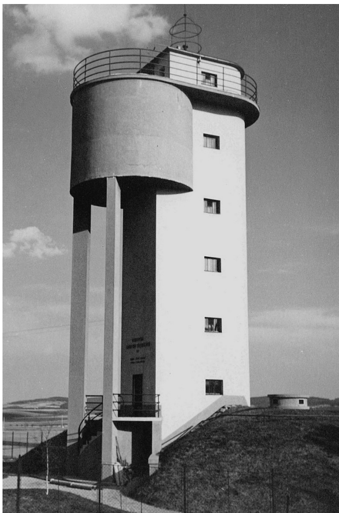
119. Třebíč , věžový vodojem (1936–1938), nedatováno
