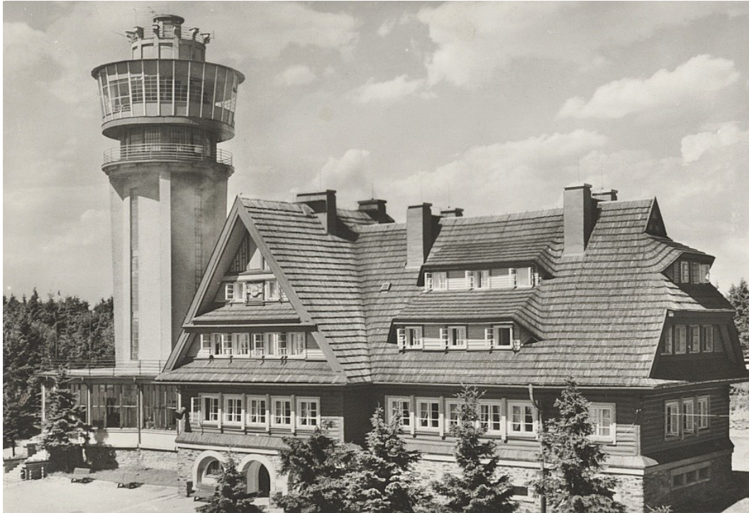
111. Suchý Vrch , věžový vodojem (1931–1932), stav po přestavbě v 60. letech, nedatováno
