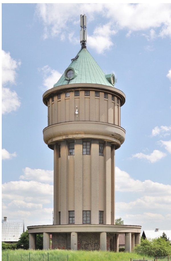
74. Jaroměř , věžový vodojem (1928), stav k roku 2020
