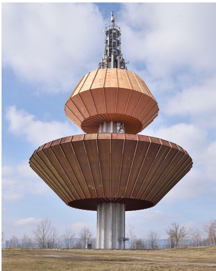
37. Teplice-Nová Ves , věžový vodojem (2. pol. 80. let 20. stol.), stav k roku 2022
