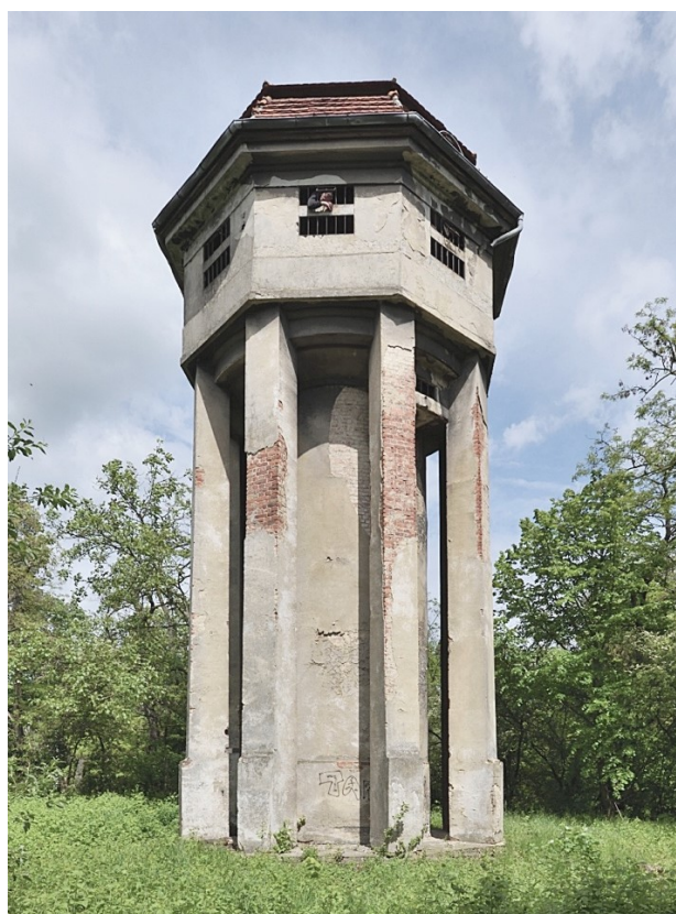
66. Hlučín , věžový vodojem (1913), stav k roku 2019
