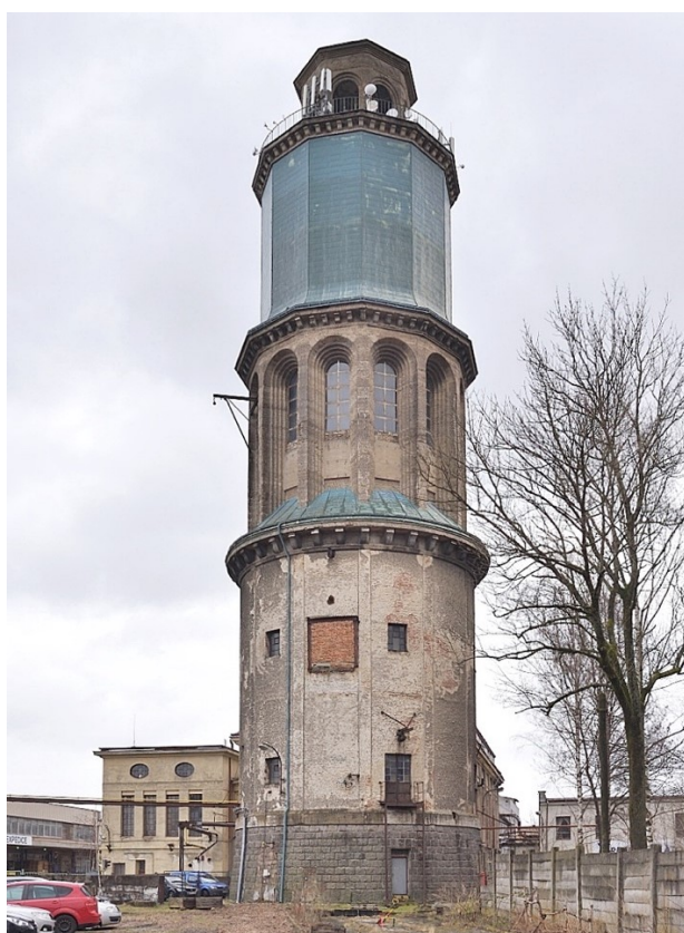
68. Liberec-Vratislavice nad Nisou , zauhlovací a vodárenská věž (1916–1919), stav k roku 2022
