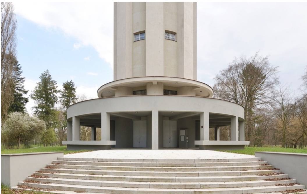
80. Poděbrady, věžový vodojem (1929–1930), stav k roku 2021, detail ochozu
