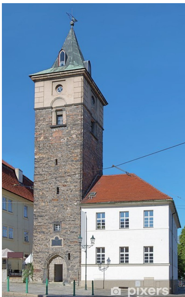
16. Plzeň , klasicistní přestavba věžového vodojemu (1845–1849), nedatováno
