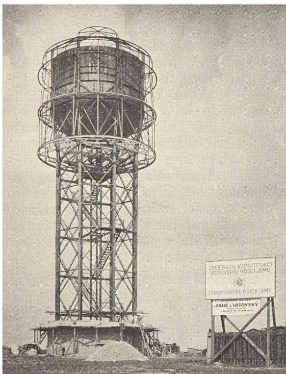
114. Kladno-Rozdělův, věžový vodojem (1933), konstrukce
