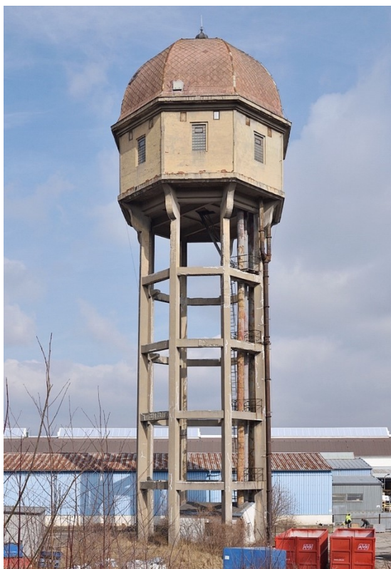
67. Bílina-Chudeřice , věžový vodojem (1916), stav k roku 2022
