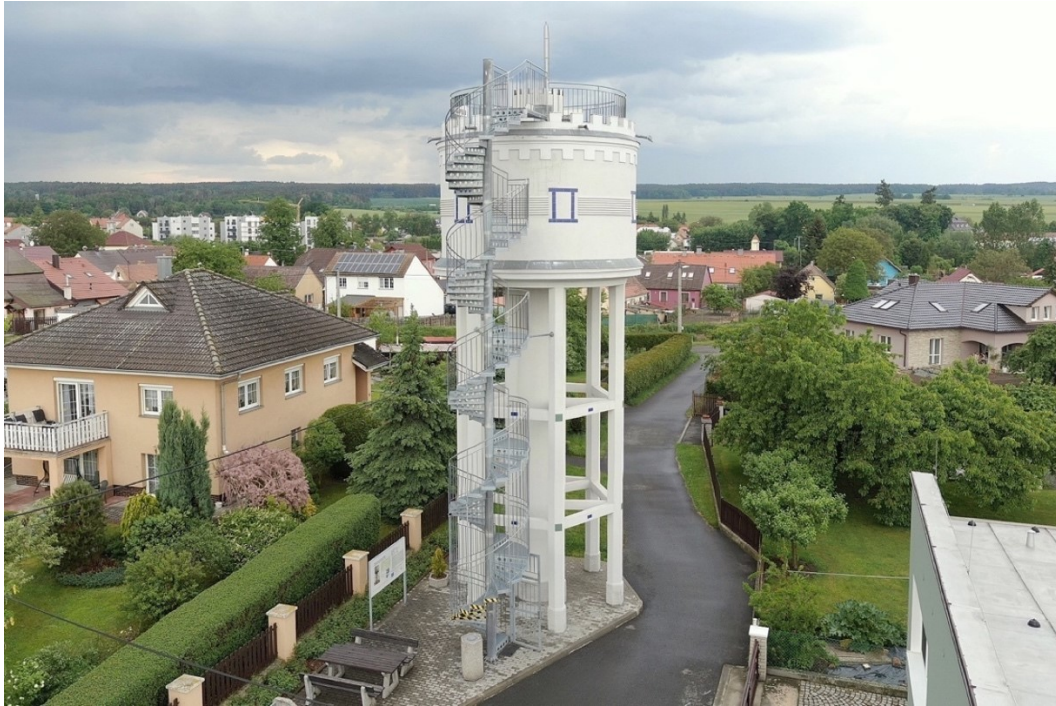
135. Heřmanova Huť , věžový vodojem po konverzi (1908), stav k roku 2021
