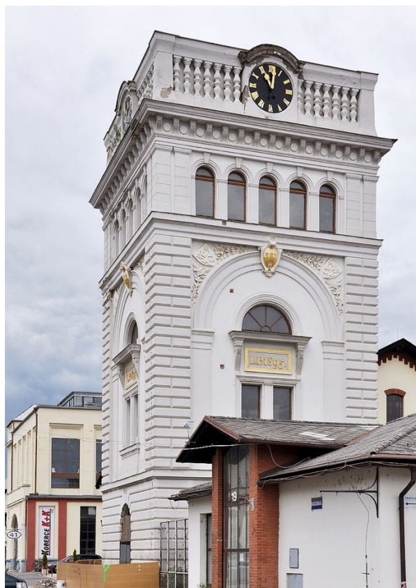
23. Praha-Holešovice, věžový vodojem (1893–1895), stav k roku 2018
