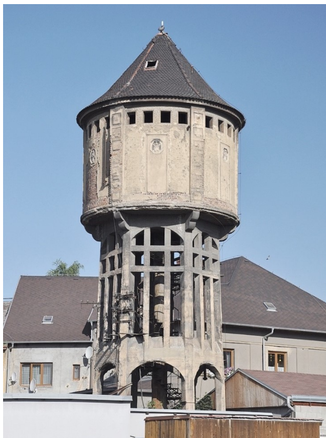
65. Duchcov , věžový vodojem (1912), stav k roku 2014
