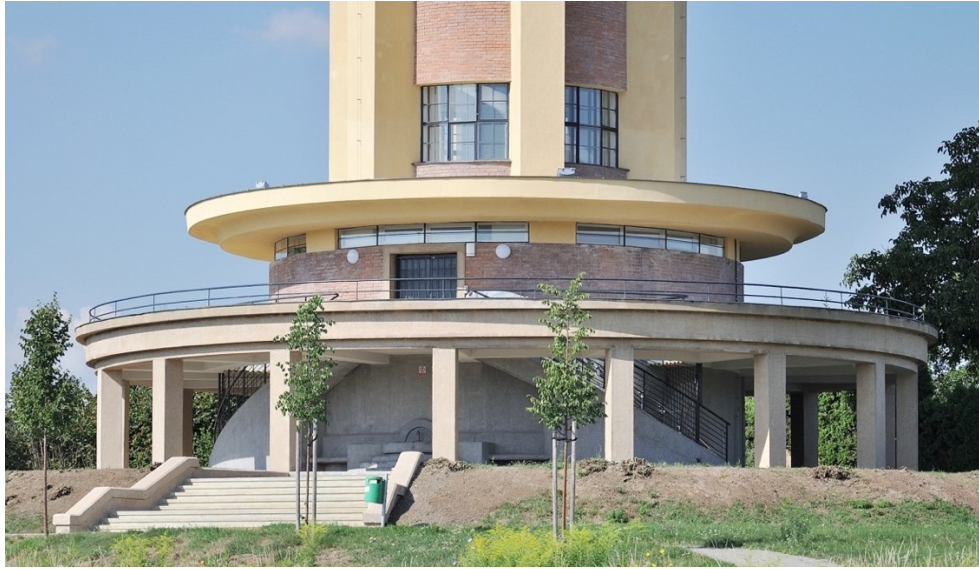
77. Kolín, věžový vodojem (1929–1930), stav k roku 2016, detail ochozu
