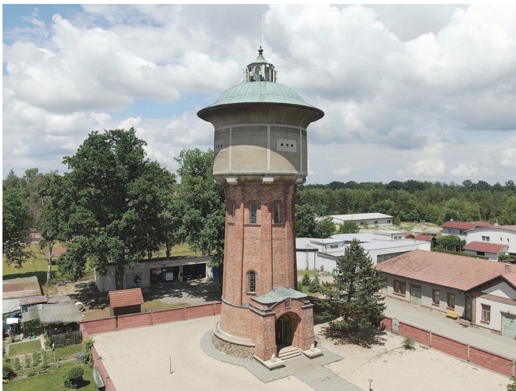
62. Třeboň , věžový vodojem (1909), stav k roku 2021
