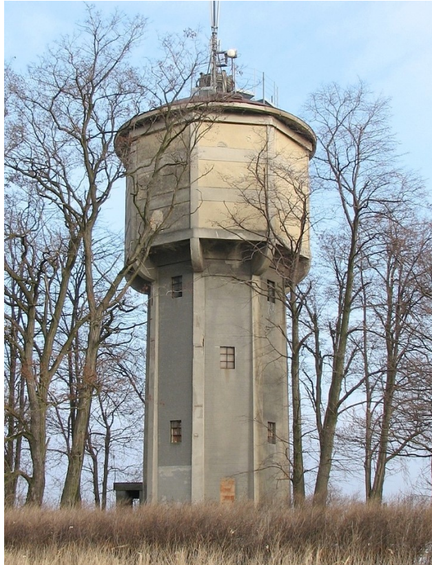
107. Peruc , věžový vodojem (1928), stav k roku 2007
