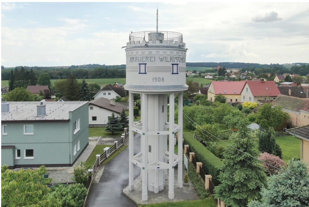
136. Heřmanova Huť , věžový vodojem po konverzi (1908), stav k roku 2021
