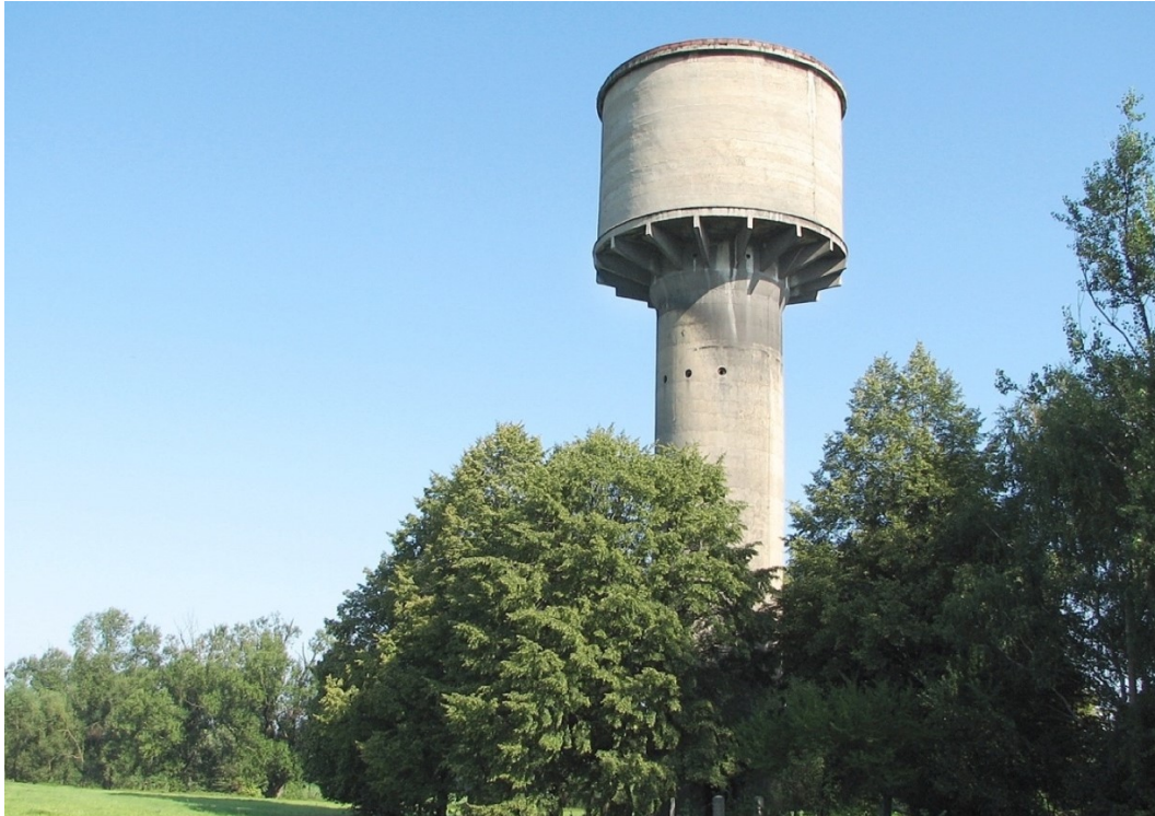
31. Bohumín-Pudlov , věžový vodojem (1961), stav k roku 2009
