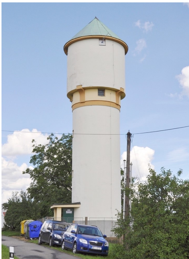
83. Bílá Hlína , věžový vodojem (1929–1934), stav k roku 2016
