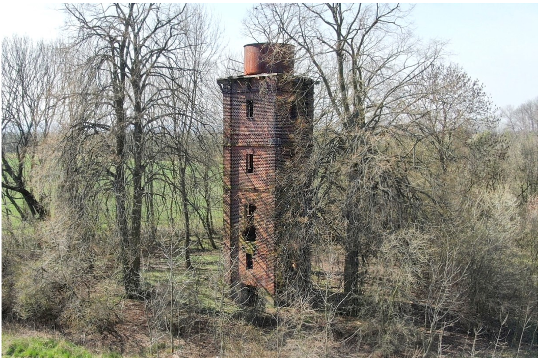
42. Pardubice-Dražkovice , věžový vodojem (kolem 1901), stav k roku 2019
