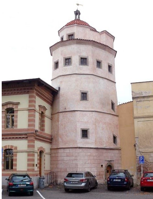
8. Nymburk , vodárenská věž zv. Turecká (založena 1597), stav k roku 2017
