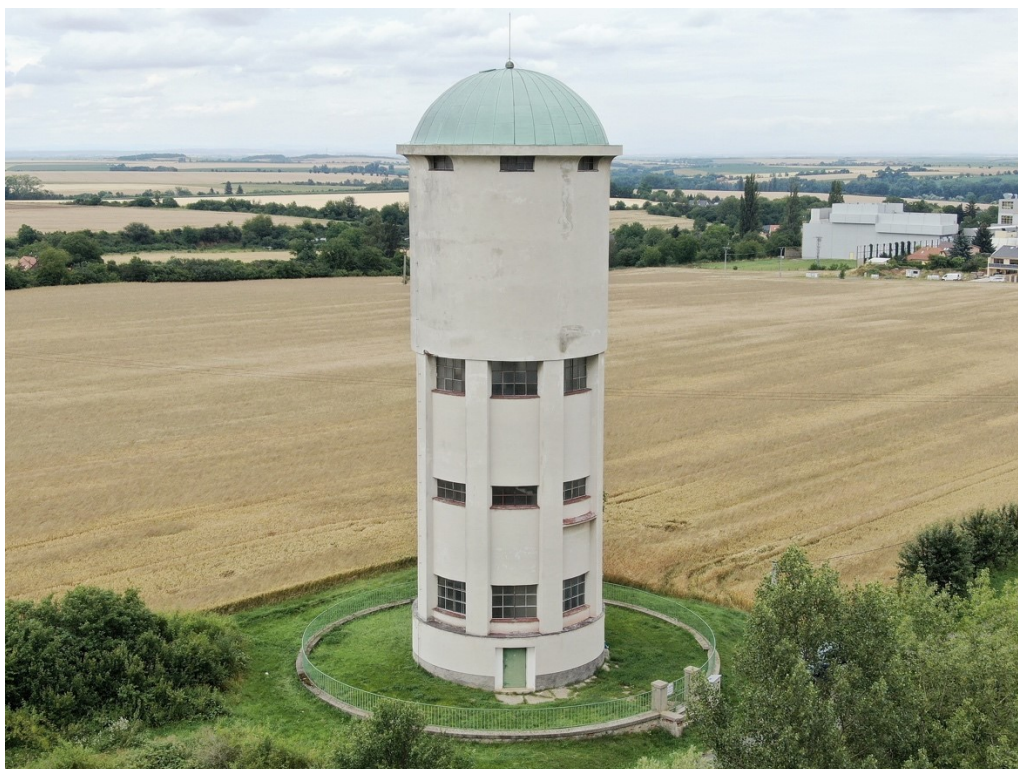
81. Kouřim , věžový vodojem (1930), stav k roku 2020
