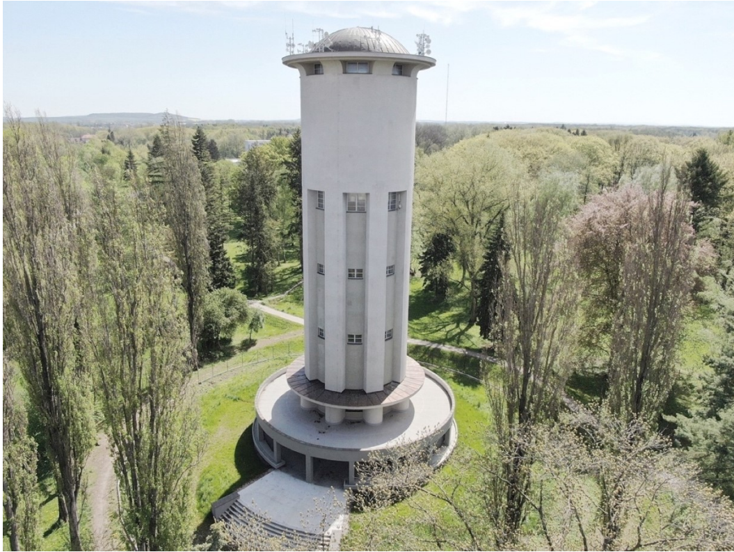
79. Poděbrady, věžový vodojem (1929–1930), stav k roku 2021
