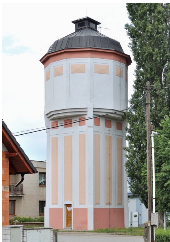
84. Mečeříž , věžový vodojem (1913), stav k roku 2015
