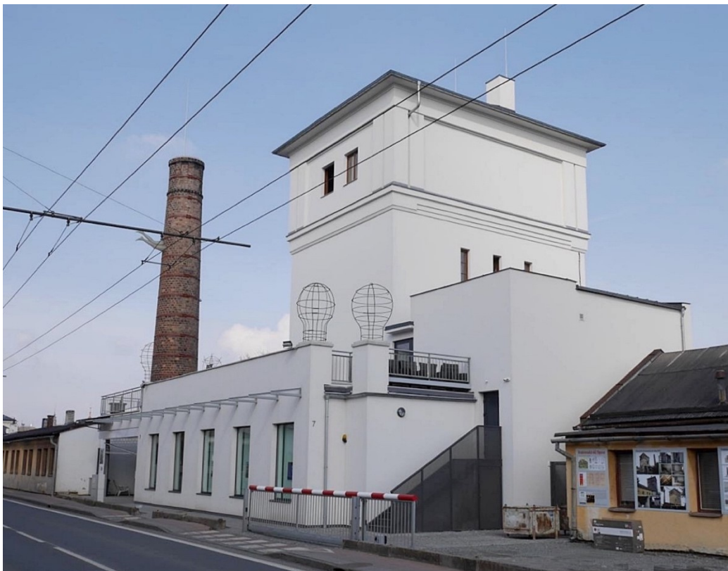
156. Opava-východ , konverze drážního věžového vodojemu (1893), stav k roku 2017
