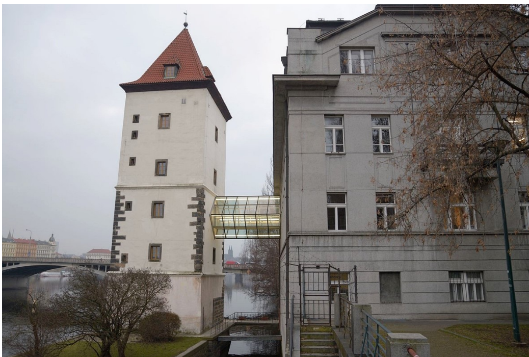
3. Praha-Smíchov , Petřilkovská vodárenská věž (založena po 1502), nedatováno
