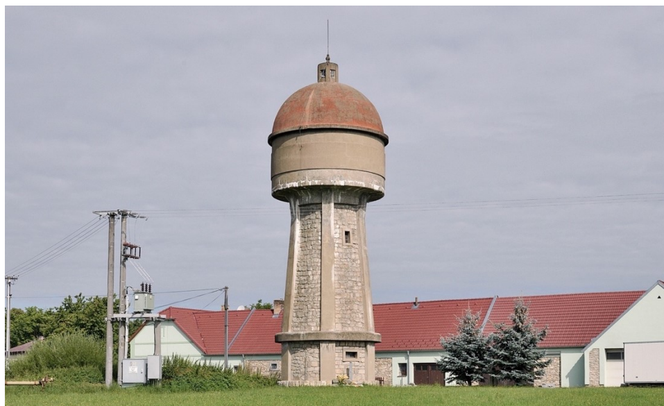
69. Trhové Sviny-Něchov , věžový vodojem (1925–1927), stav k roku 2020
