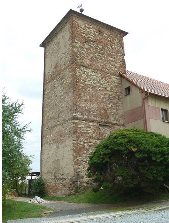
7. Benátky nad Jizerou , vodárenská věž (založena koncem 14. stol.), stav k roku 2017
