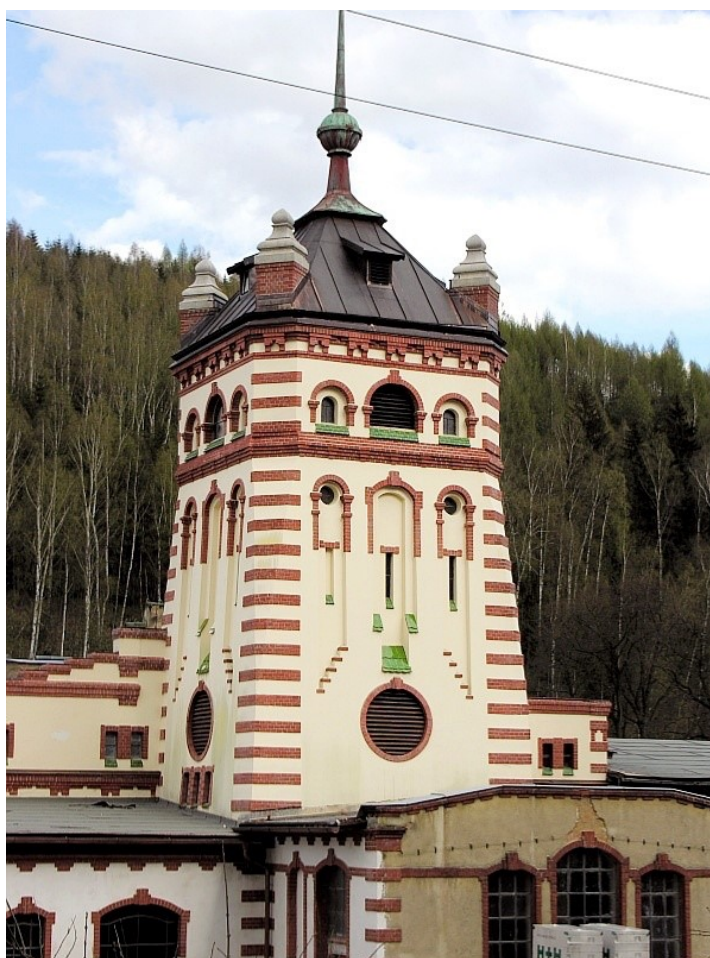
54. Kraslice , věžový vodojem v areálu městských jatek (1904), stav k roku 2008
