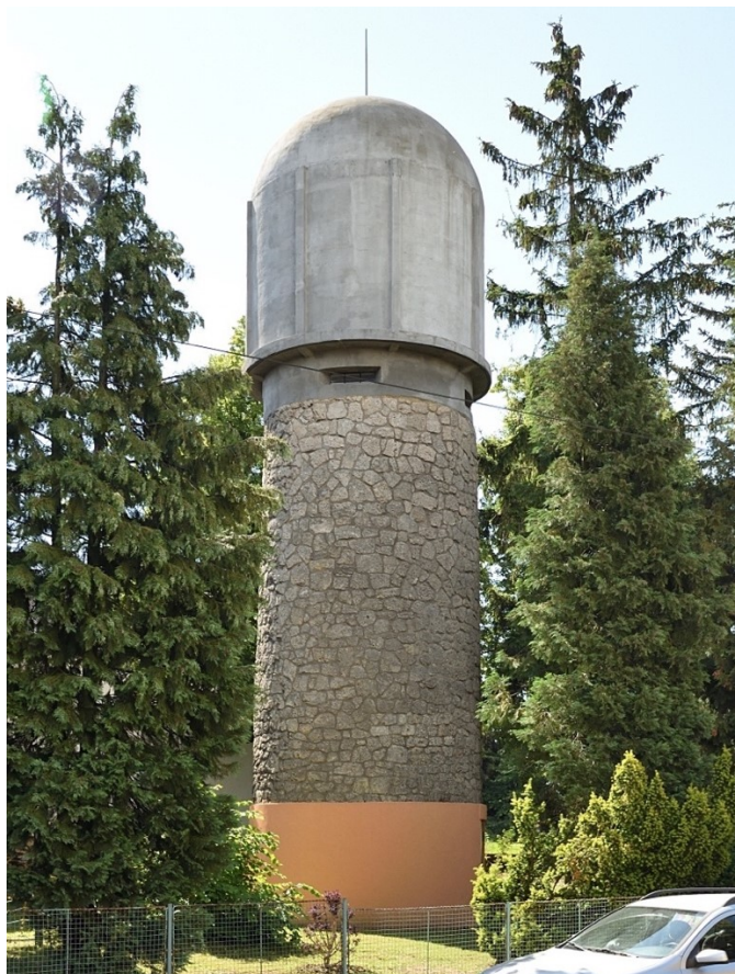
106. Kolín-Zibohlavý , věžový vodojem (1927), stav k roku 2020
