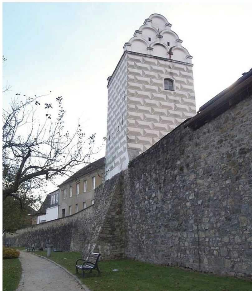
6. Tábor , vodárenská věž (založena před 1508), stav k roku 2010
