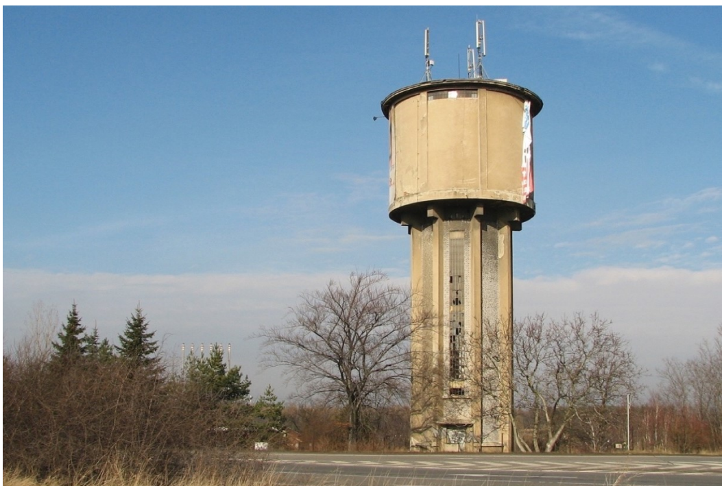
89. Buštěhrad , věžový vodojem (1933), stav k roku 2007
