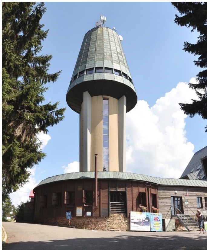
112. Suchý Vrch , věžový vodojem (1931–1932), po přestavbě v období 1982–1986, stav k roku 2020
