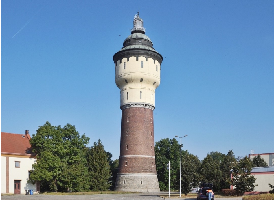
51. Plzeň , věžový vodojem v areálu pivovaru Plzeňský Prazdroj (1905–1907), stav k roku 2021
