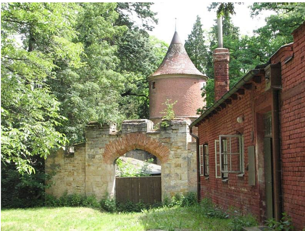
17. Hrádek u Nechanic , věžový vodojem (1838–1856), stav k roku 2007
