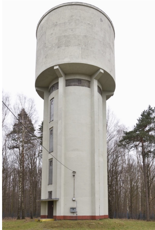
105. Petřvald , věžový vodojem (1954), stav k roku 2019
