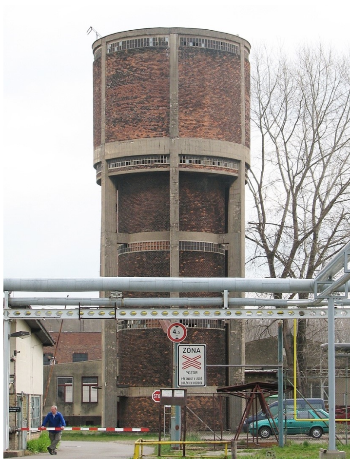
122. Kolín , drážní věžový vodojem (1943), stav k roku 2007
