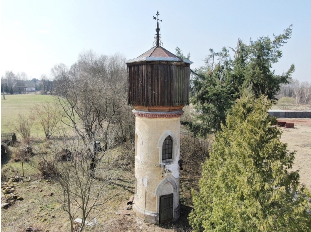
41. Nová Ves nad Lužnicí , věžový vodojem (počátek 20. stol.), stav k roku 2020
