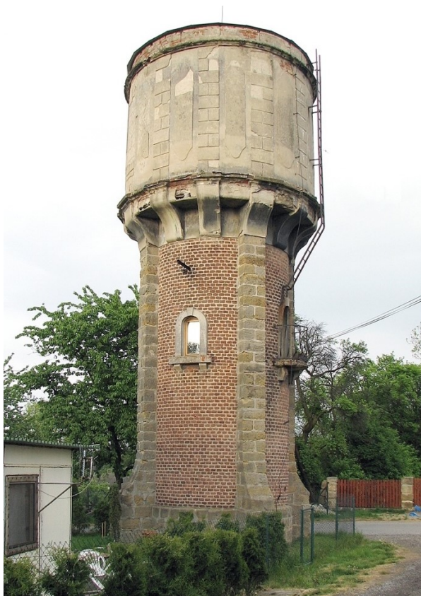
45. Kanina , věžový vodojem (1910), stav k roku 2007
