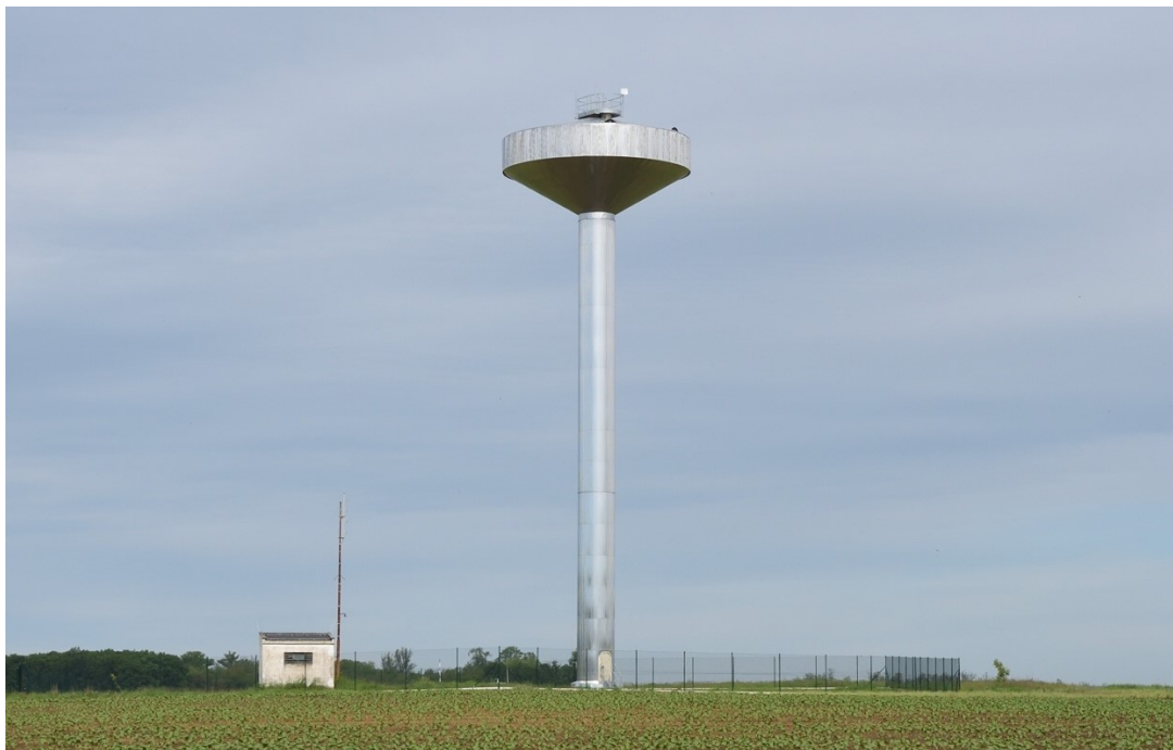
39. Šanov, věžový vodojem (2020), stav k roku 2021
