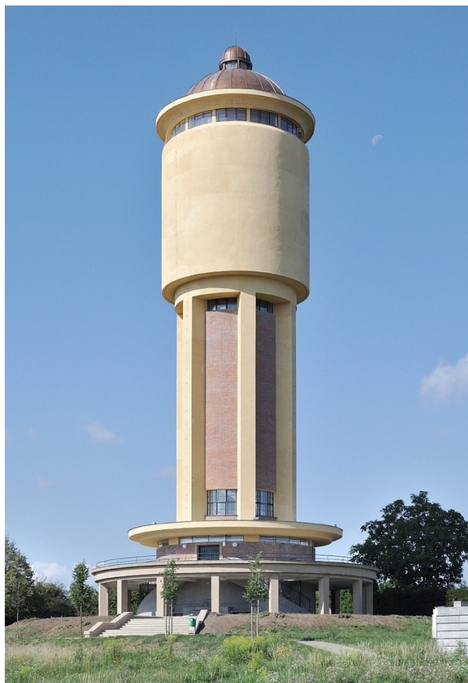
76. Kolín , věžový vodojem (1929–1930), stav k roku 2016
