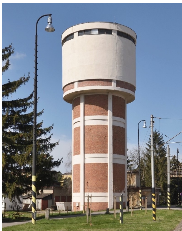
126. Nymburk , drážní věžový vodojem (1950), stav k roku 2021
