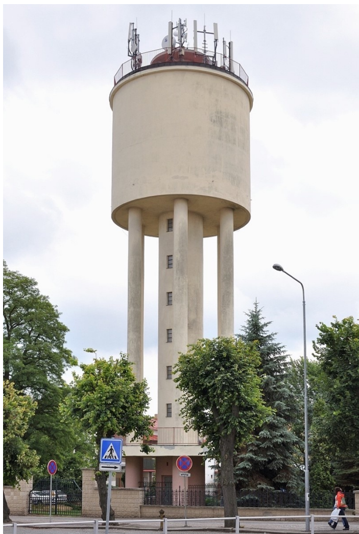
99. Pečky , věžový vodojem (1932), stav k roku 2015
