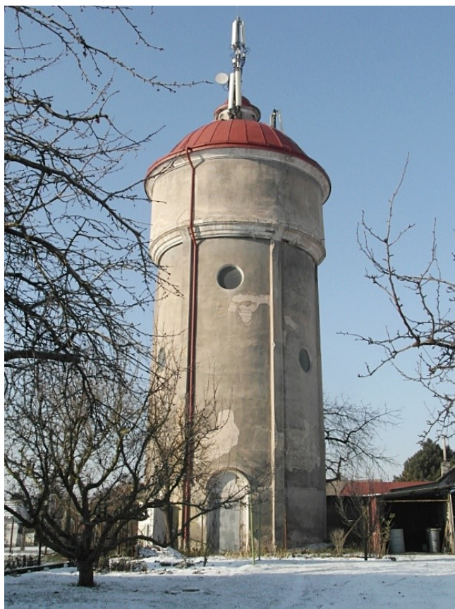
47. Týnec nad Labem, věžový vodojem (1916–1921), stav k roku 2012
