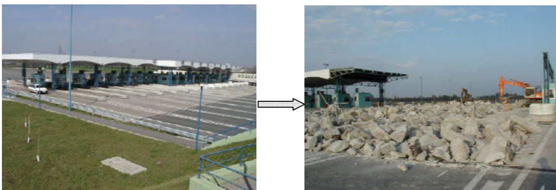
Obrázek 11: Výstavba a následná demolice mýtné brány na dálnici M1
