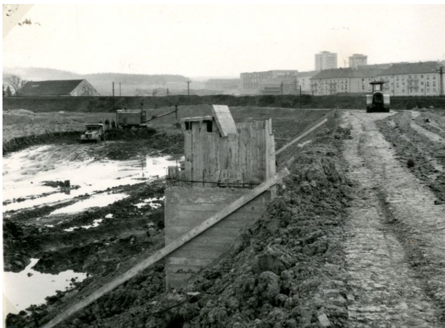
Obrázek č. 7: Válcování povrchu zvýšené severní hráze 1962
