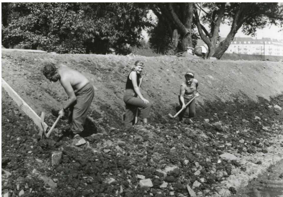
Obrázek č. 8: Budování Nového rybníka v rámci Akce Z od roku 1963
