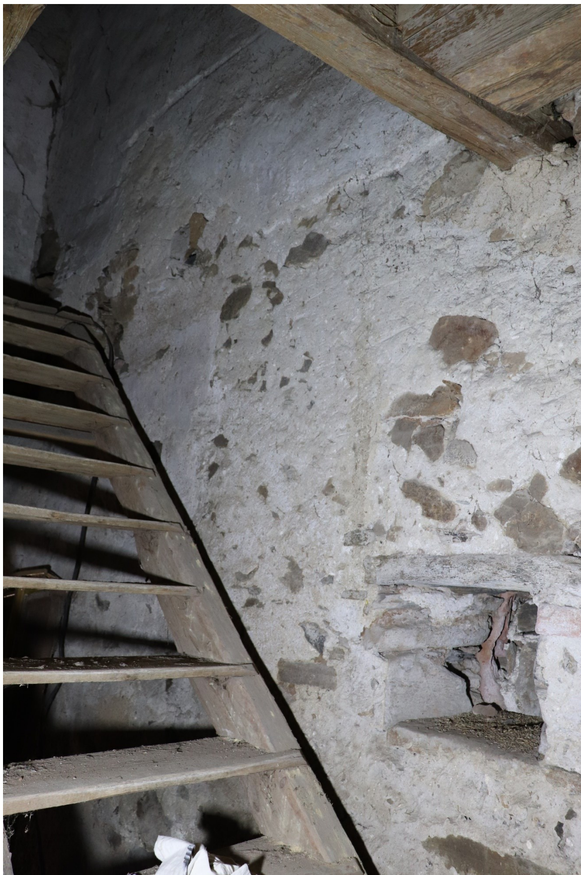
45) Sýpka, východní průčelní stěna, pohled z interiéru, 2022.
