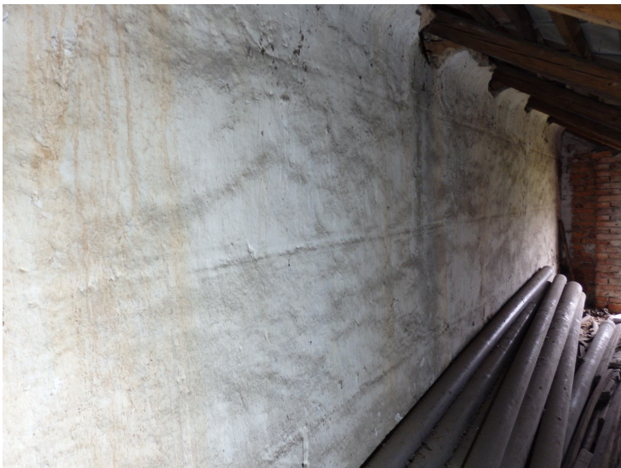
20) Sýpka, část jižní stěny, kryté pultovou střechou garáže, detail sgrafitového kvádrování, 2022.
