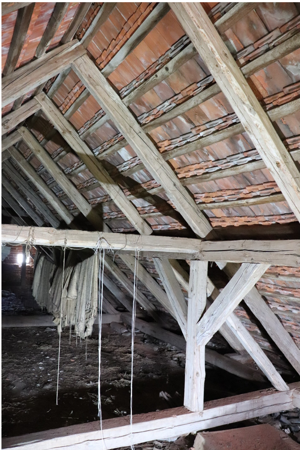
49) Sýpka, pohled do krovu, z východu, 2022.
