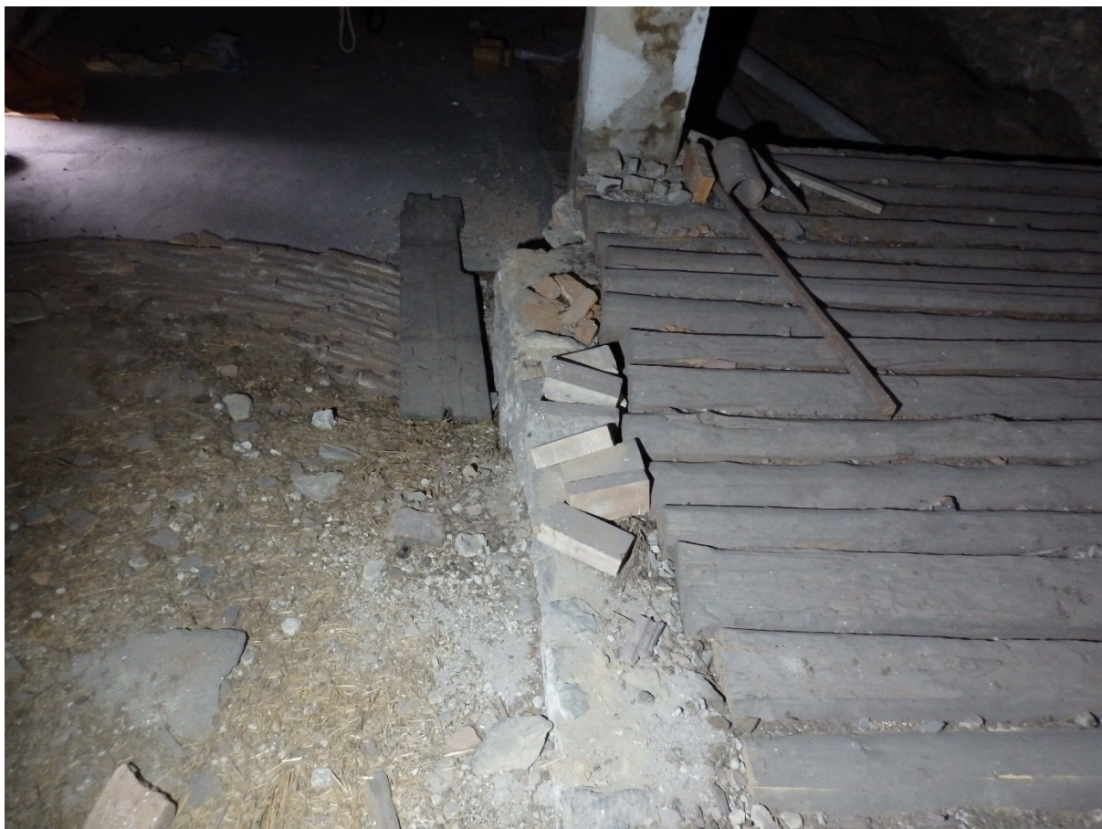
35) Obytné stavení, vlevo valená segmentová klenba síně, vpravo povalový strop kuchyně, pohled z jihu, 2022.
