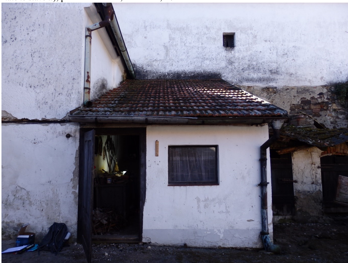
17) Předstíň sýpky, detail zlomu a přechodu korunní římsy v západní stěně (pozůstatek zaniklého malého stavení ), pohled ze dvora, ze severu, 2022
