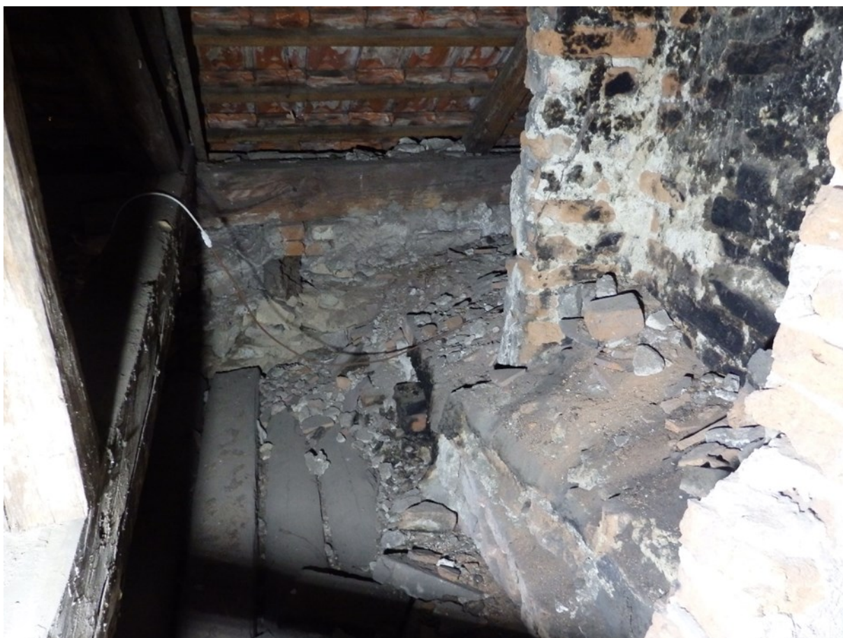
38) Obytné stavení, povalový strop kuchyně a torzo dymníku při mezitraktové stěně mezi kuchyní a někdejší světnicí, 2022.
