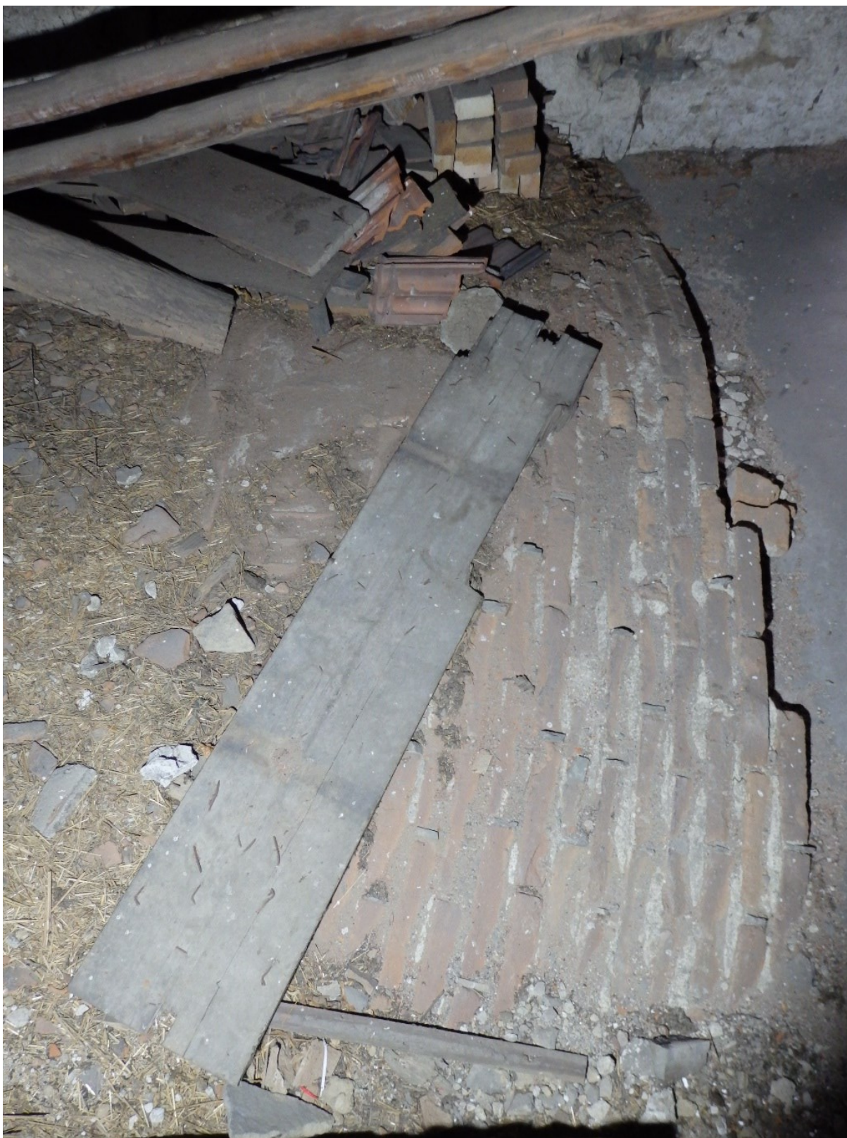
39) Obytné stavení, detail valené segmentové klenby síně, vpravo zřetelné ulámané severní čelo, 2022.
