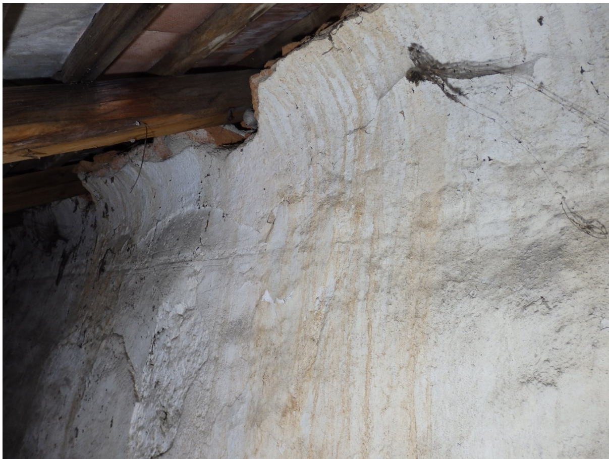
21) Sýpka, část jižní stěny, kryté pultovou střechou garáže, detail sgrafitového kvádrování, 2022.
