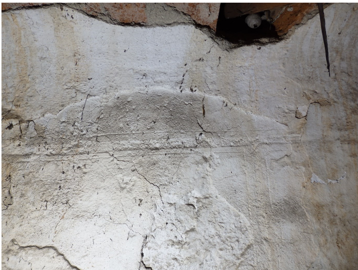
23) Sýpka, část jižní stěny, kryté pultovou střechou garáže, detail sgrafitového kvádrování, 2022.
