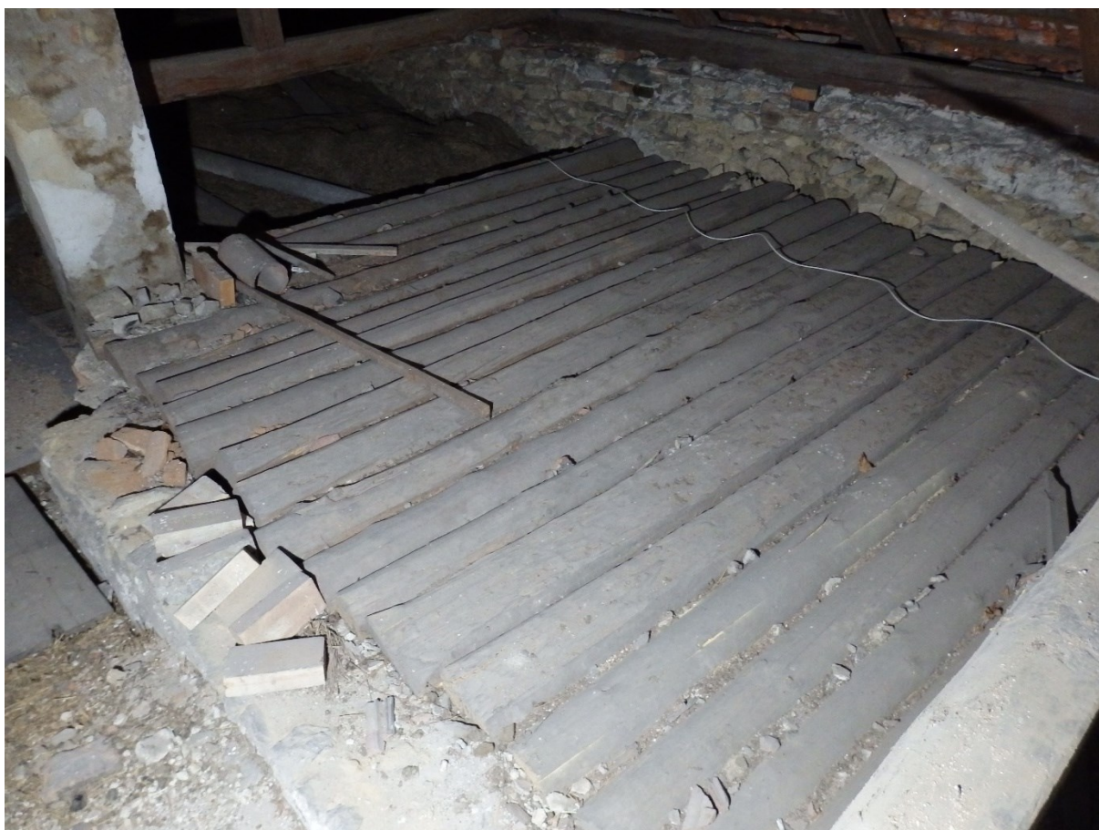
33) Obytné stavení, povalový strop kuchyně. Vlevo mezitraktová stěna mezi kuchyní a síní, 2022.
