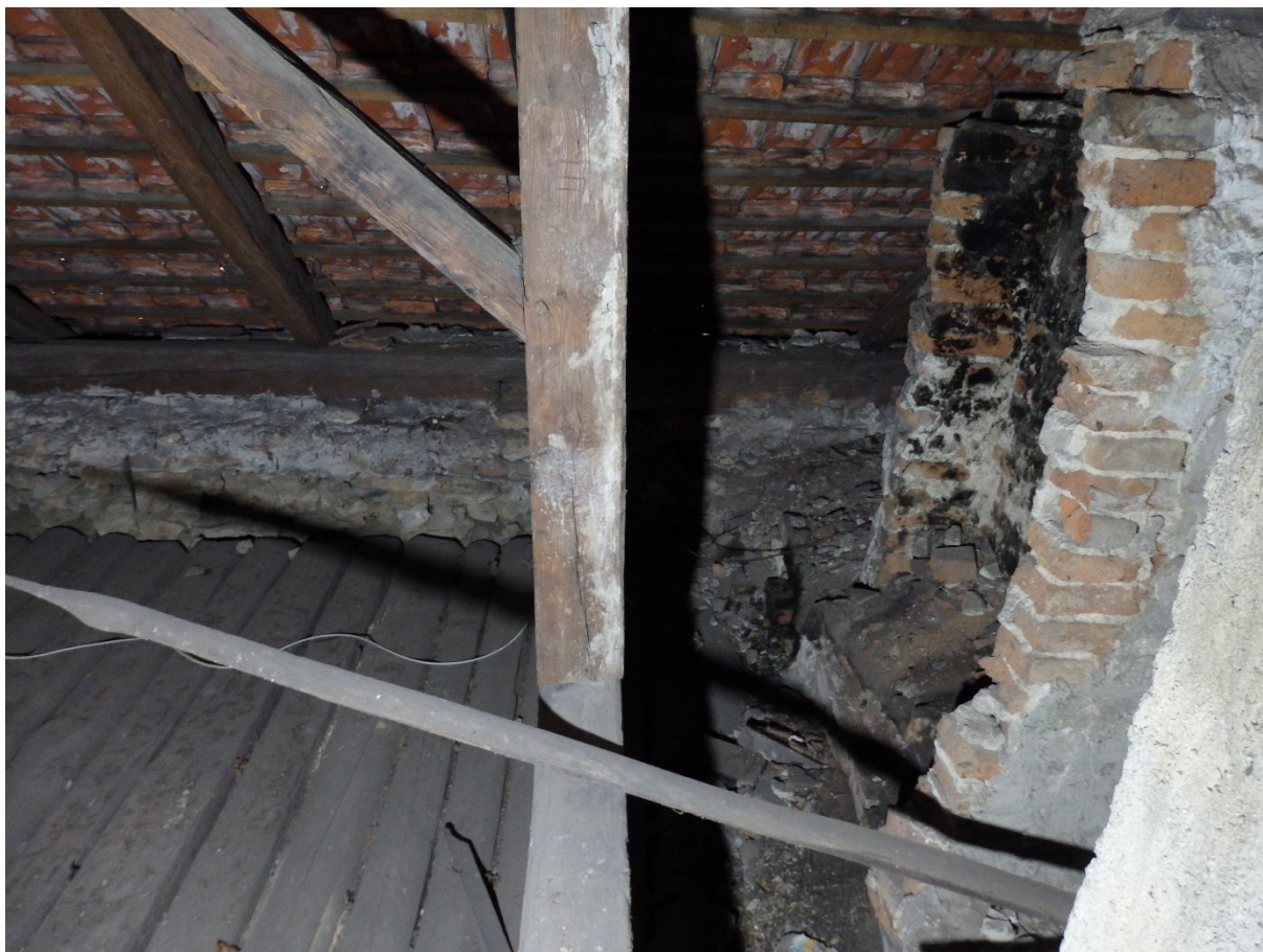
37) Obytné stavení, povalový strop kuchyně a torzo dymníku při mezitraktové stěně mezi kuchyní a někdejší světnicí, 2022.
