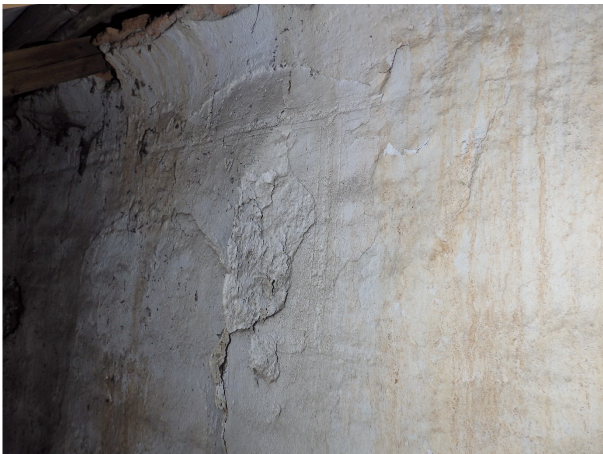
24) Sýpka, část jižní stěny, kryté pultovou střechou garáže, detail sgrafitového kvádrování, 2022.
