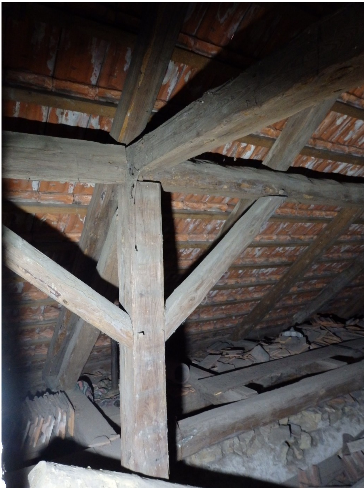
34) Obytné stavení, pohled do krovu, jedna ze stolic vaznicového krovu, 2022.
