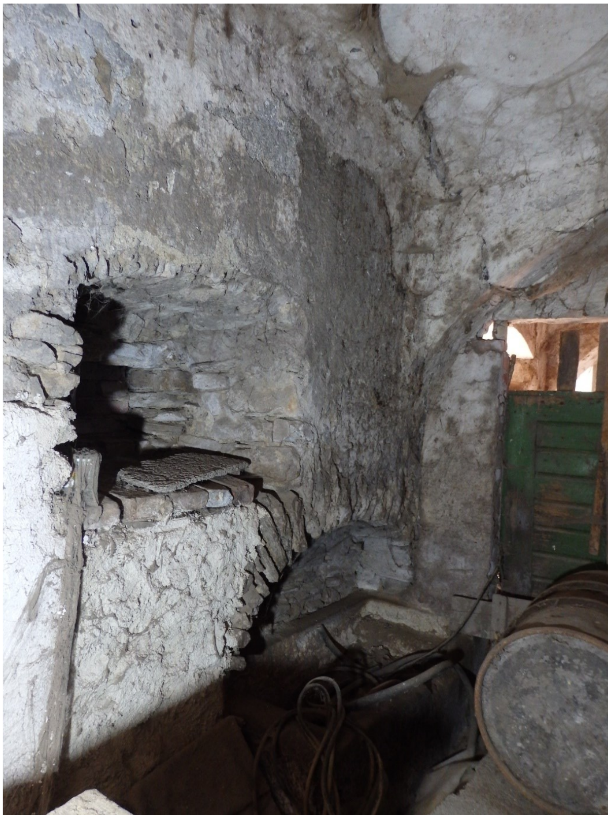
53) Maštál, osvětlovací výklenek, jižní obvodová stěna, západní část budovy, 2022.
