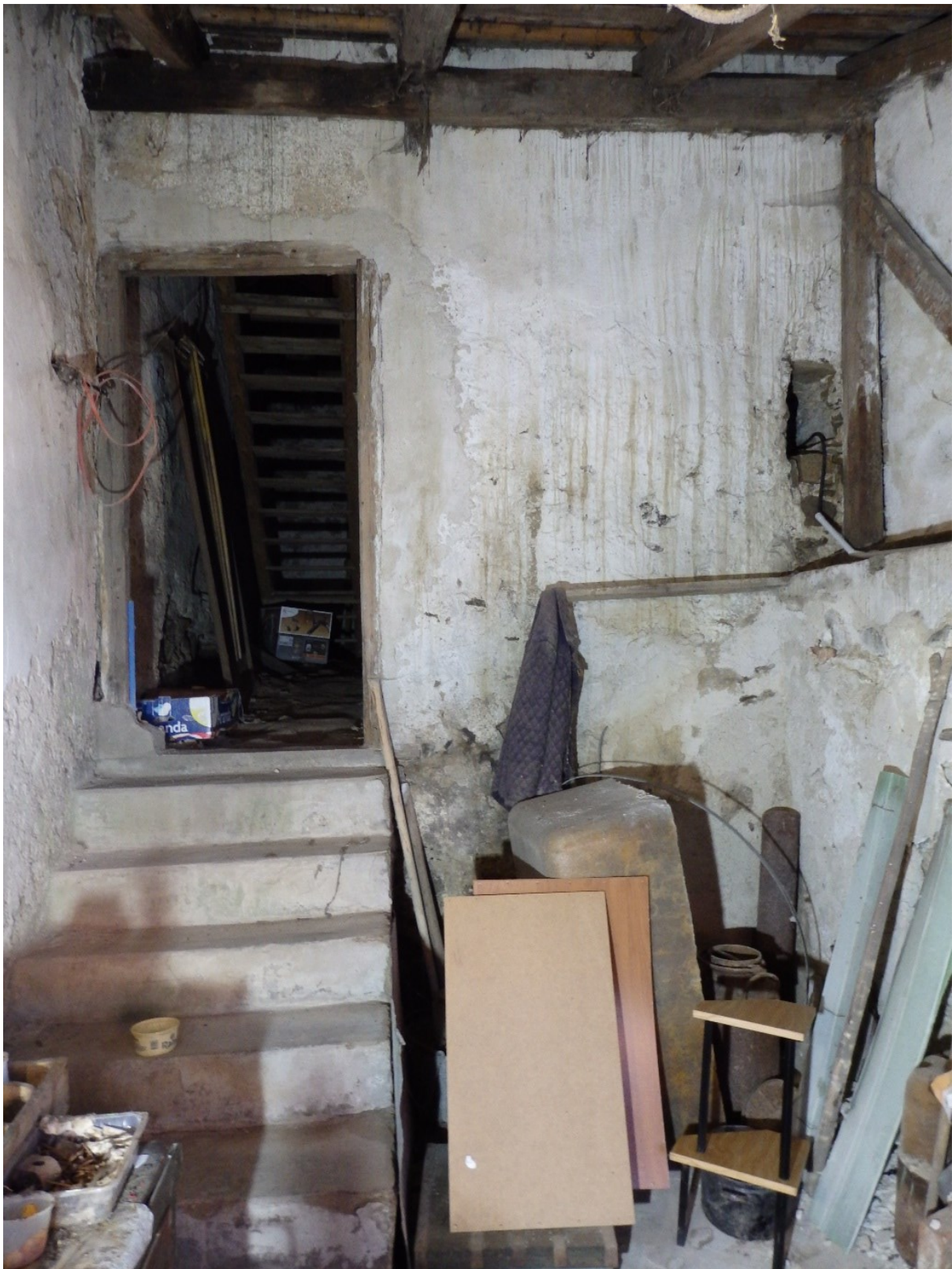
42) Sýpka, pohled na vstup, pohled z předsíně, ze severu, 2022.
