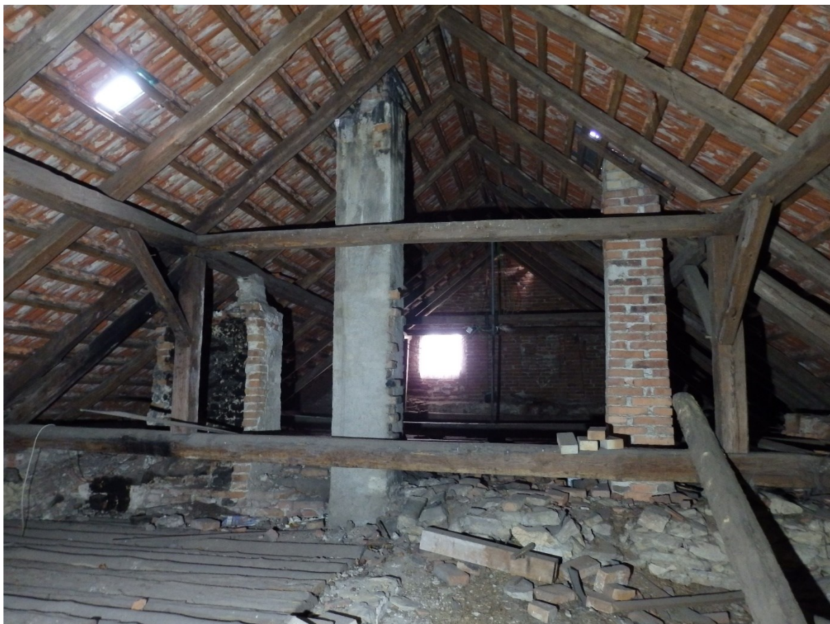
32) Obytné stavení, pohled do krovu, pohled ze severu (vlevo povalový strop kuchyně, při něm torzo zaniklého dymníku), 2022.
