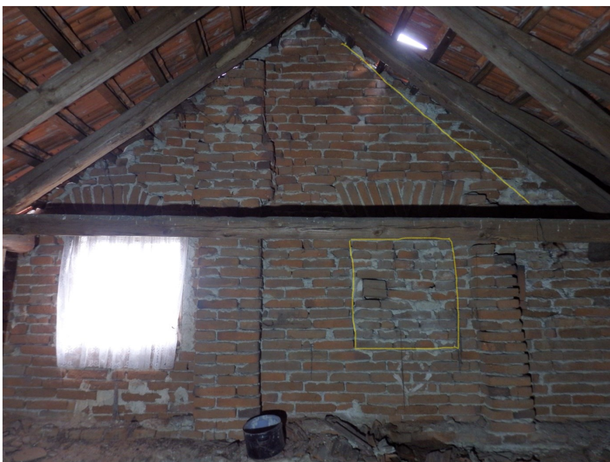
31.1) Obytné stavení, vnitřní stěna jižního štítu, žlutě mladší zásahy, vpravo přízděná podezdívka pro pultovou střechu podsklepeného přístavku, 2022.
