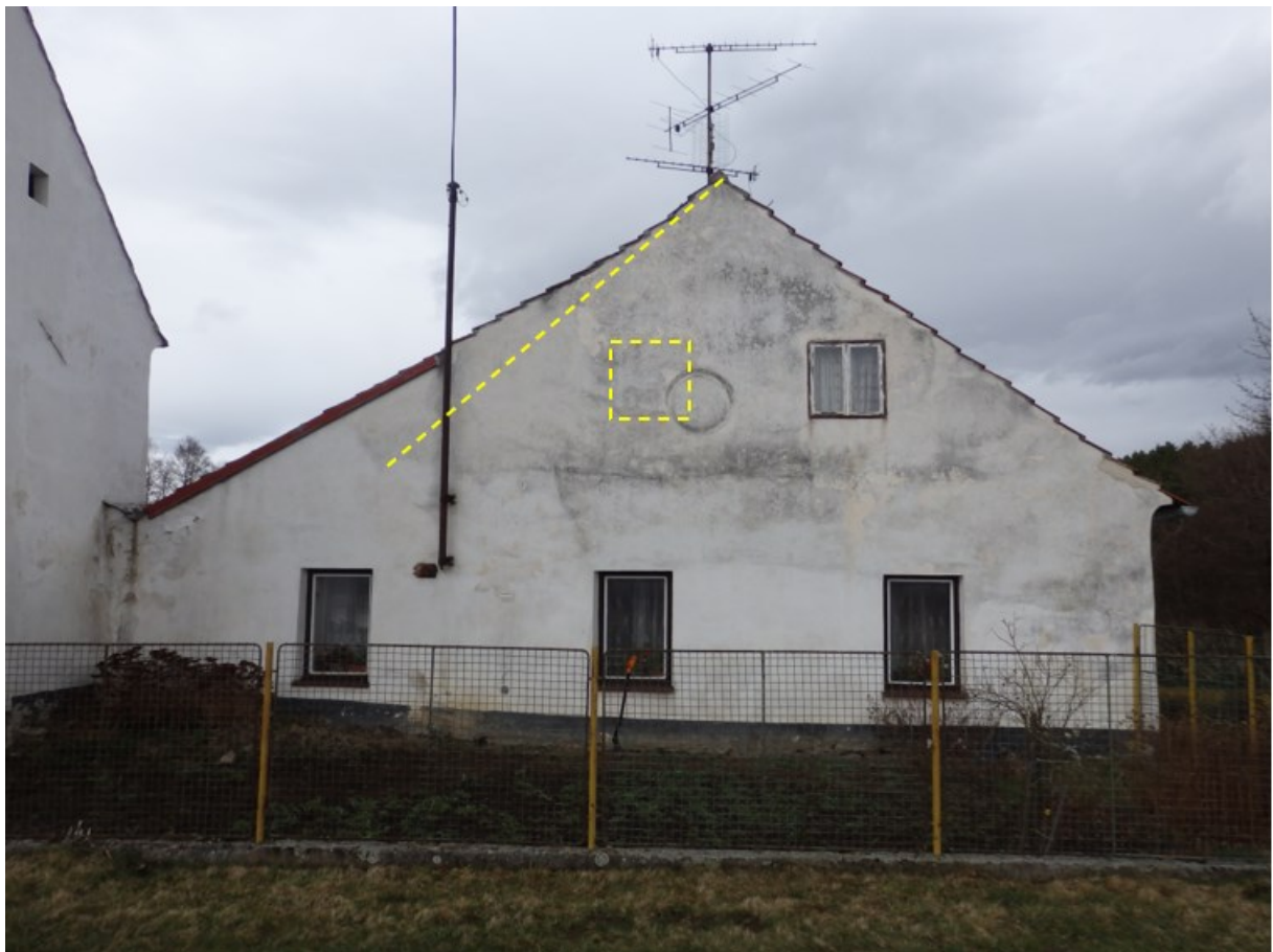
11. 1) Obytné stavení, jižní průčelí, pohled z jihu, 2022, návrh podoby průčelí před rokem 1864.
