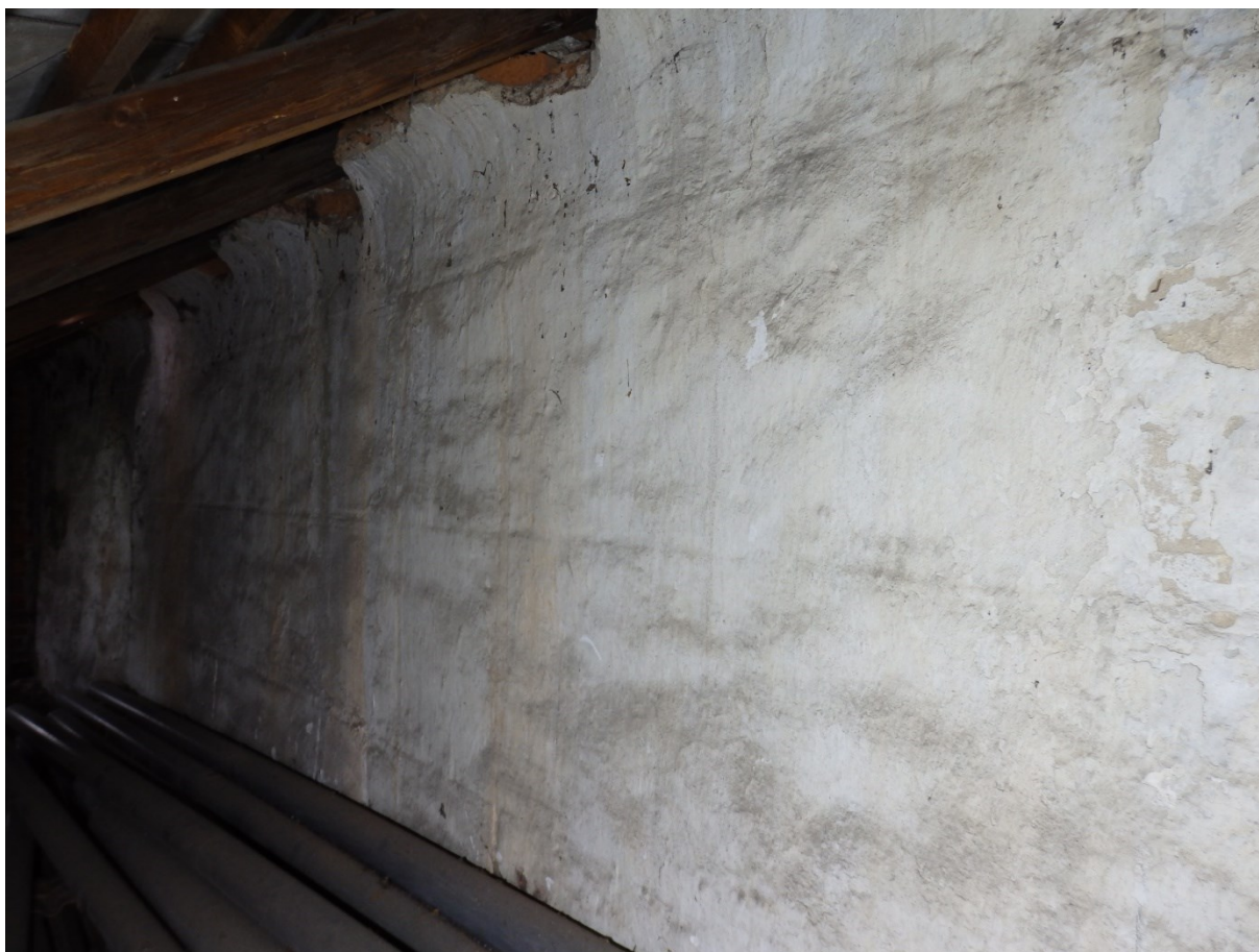
19) Sýpka, část jižní stěny, kryté pultovou střechou garáže, detail sgrafitového kvádrování, 2022.
