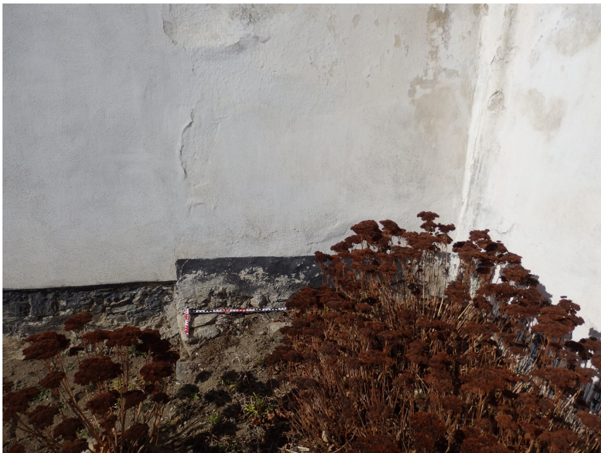
26) Sypka, východní průčelí, fragmenty základového zdiva zaniklého malého stavení , 2022.
