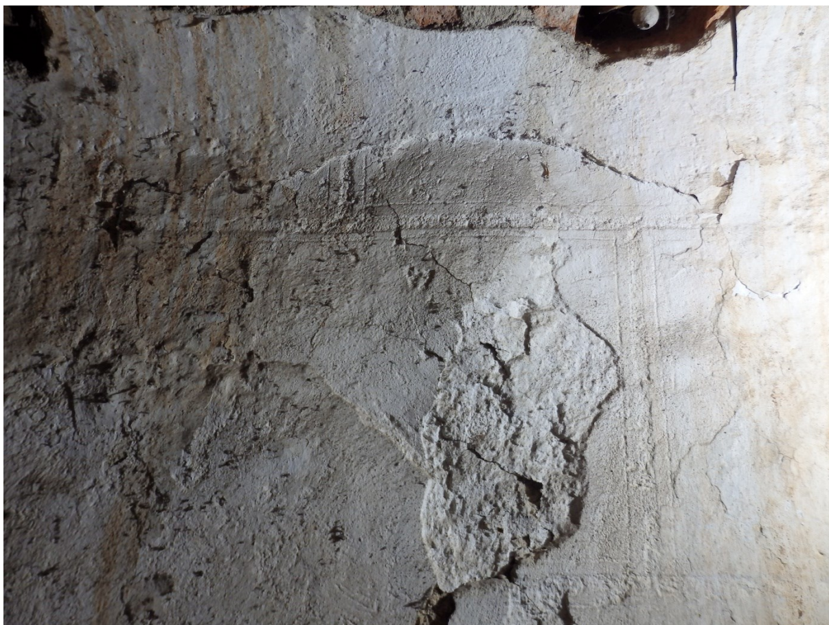
22) Sýpka, část jižní stěny, kryté pultovou střechou garáže, detail sgrafitového kvádrování, 2022.
