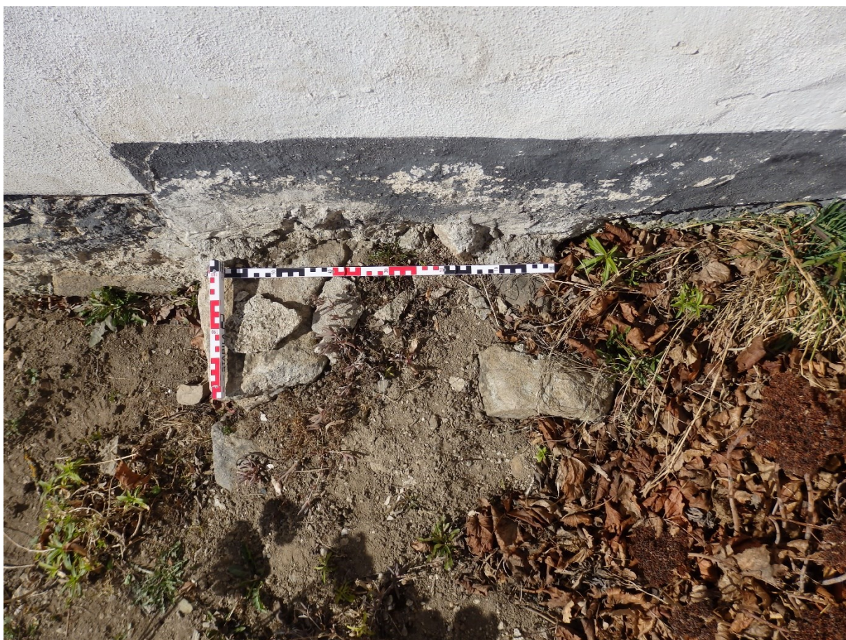
27) Sypka, východní průčelí, fragmenty základového zdiva zaniklého malého stavení , 2022.
