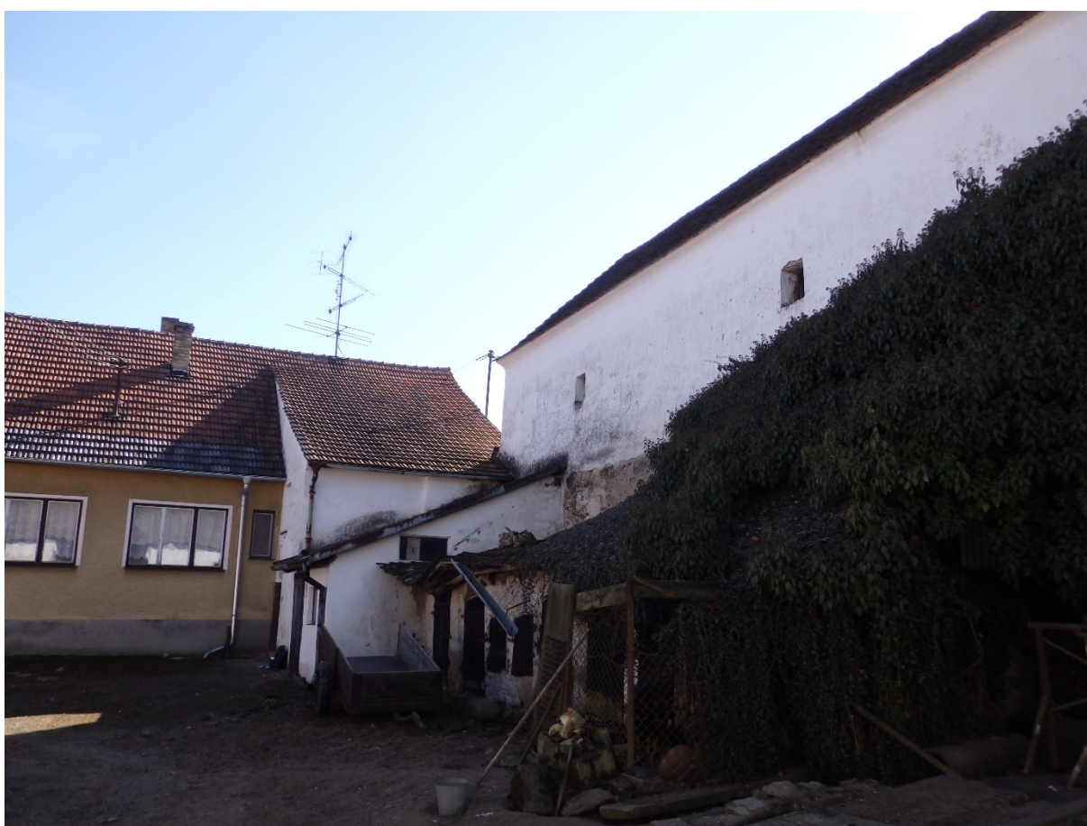
13) Sýpka s předsíní, pohled na podsklepený přístavek a verandu (vlevo), pohled ze dvora, ze severozápadu, 2022.
