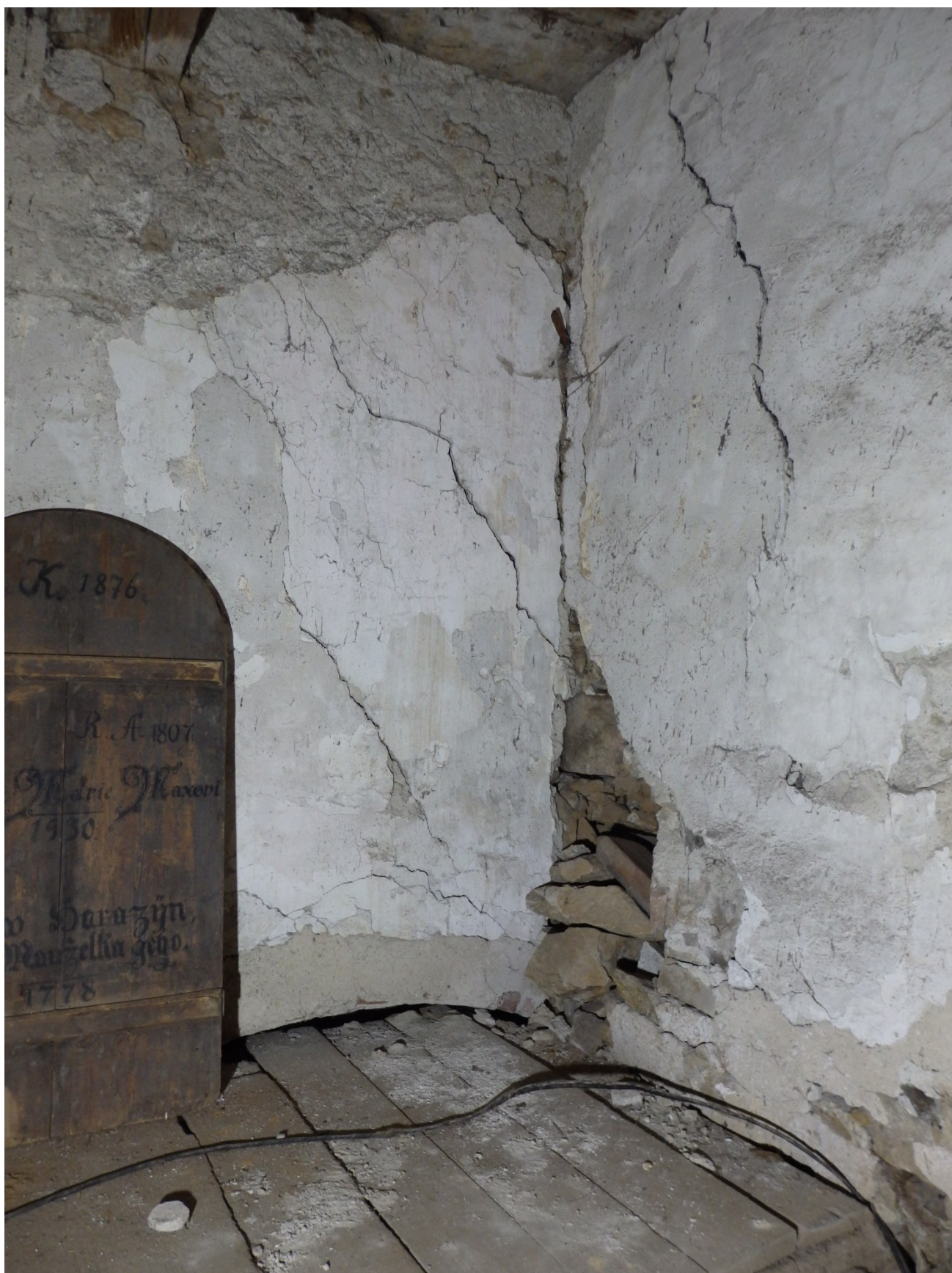
44) Sýpka, pohled na segmentový záklenek vstupu (viz obr. 34) z jihu, podlaha prvního patra, 2022
