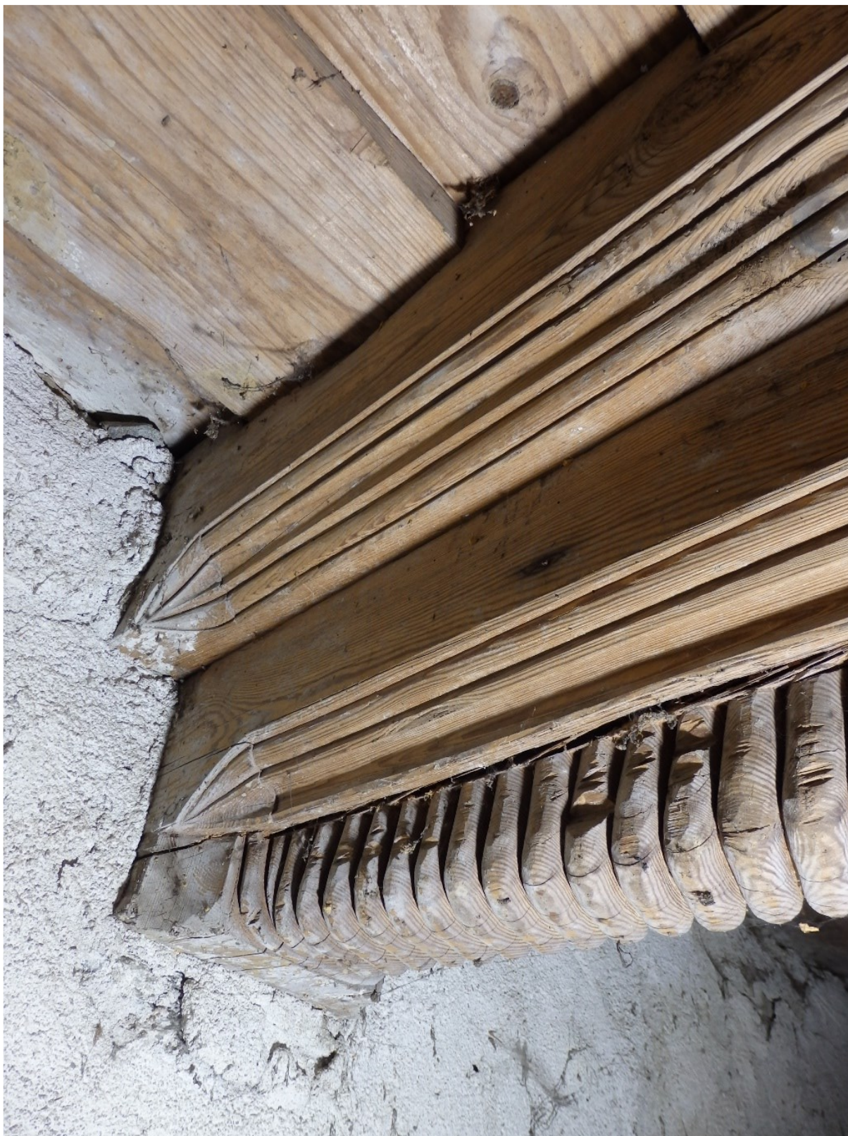
50) Sýpka, první patro, druhý nejzápadnější stropní trám, 2022.
