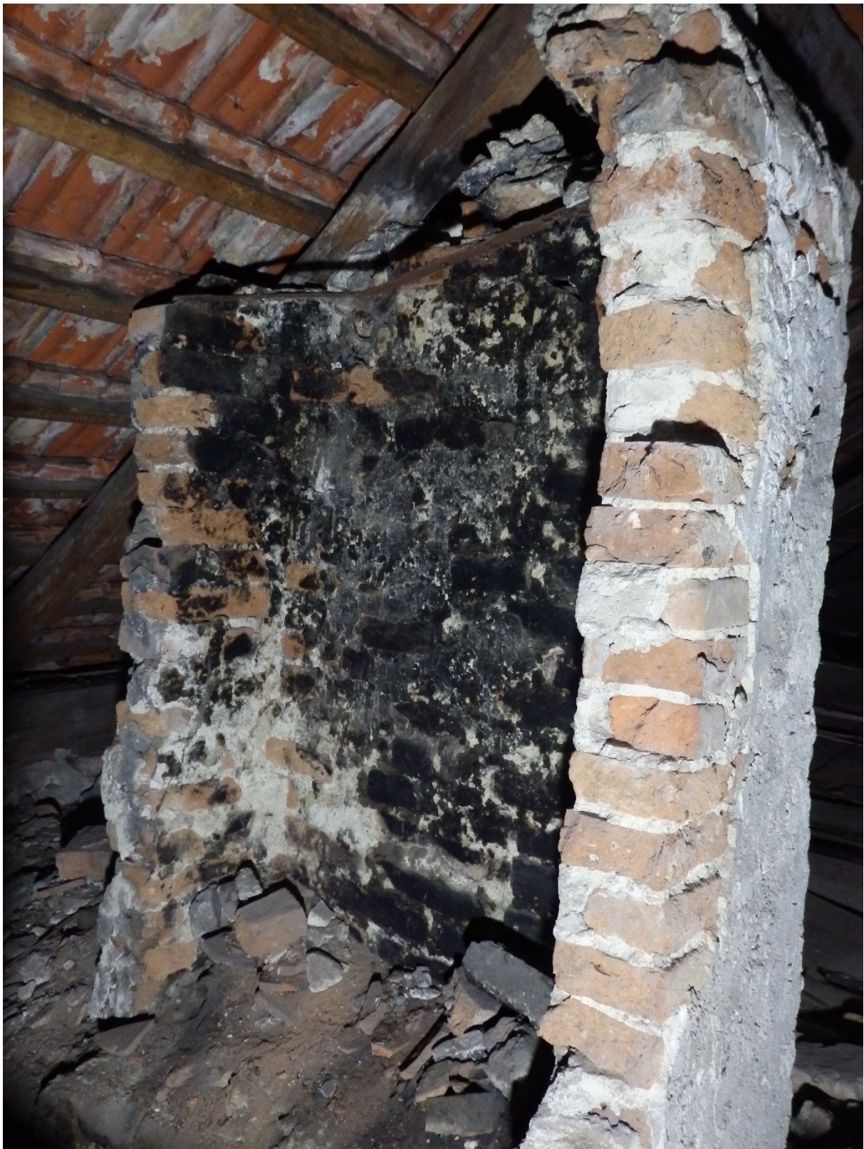
40) Obytné stavení, torzo dymníku, 2022.
