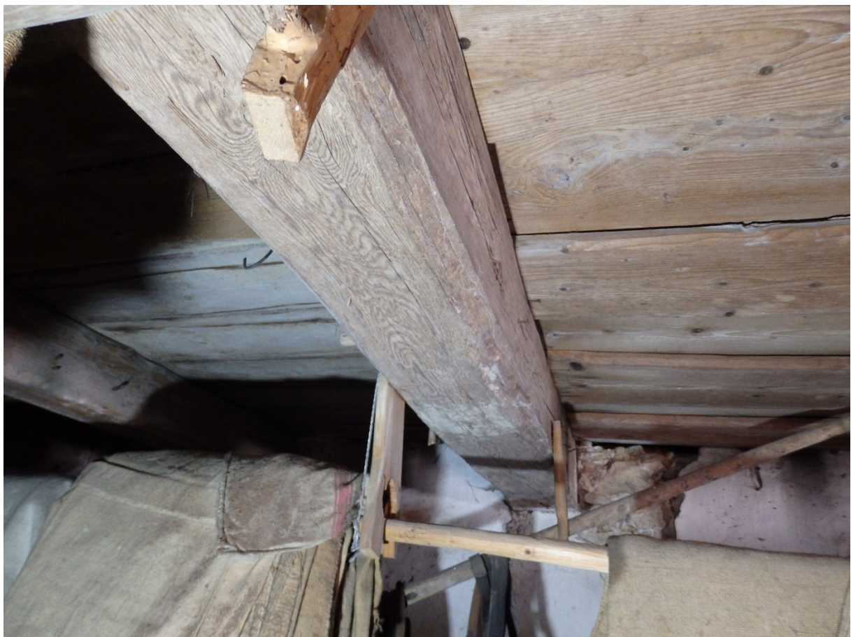
52) Sýpka, první patro, druhý trám od západu, přechod mezi základovým stropem (vpravo, viz trám s pletencem) a fošnami (vlevo), 2022.
