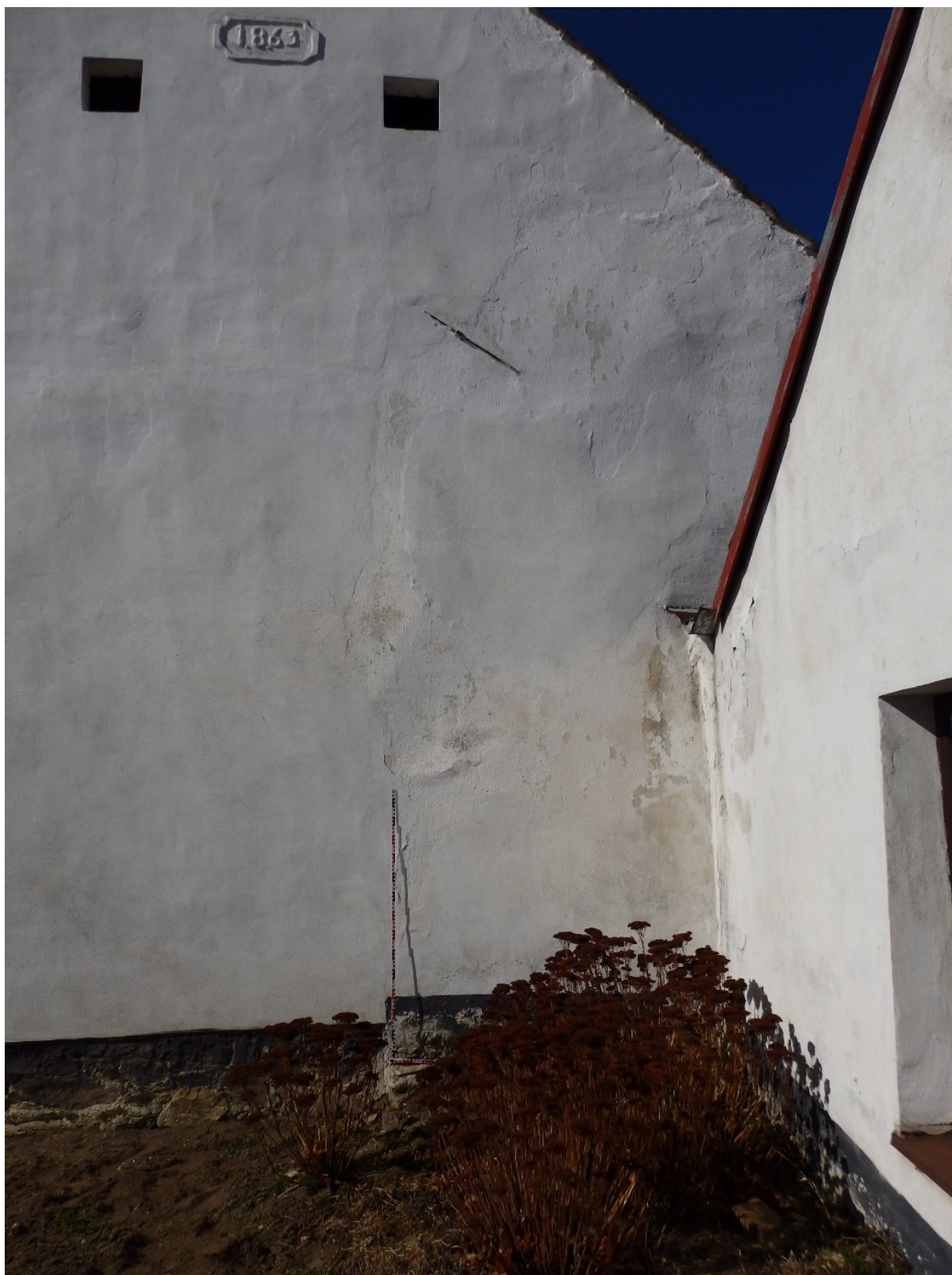
25) Sýpka, východní průčelí, 2022.
