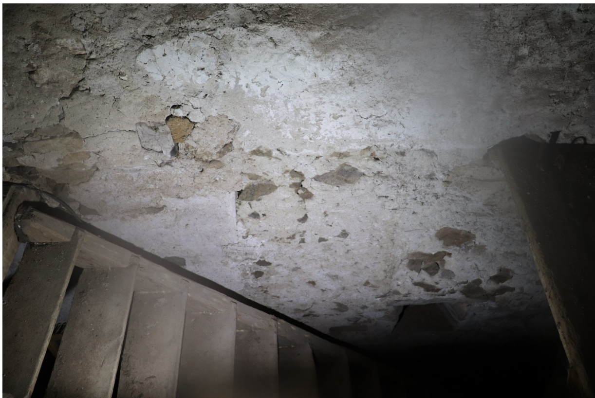
46) Sýpka, východní průčelní stěna, pohled z interiéru, 2022.
