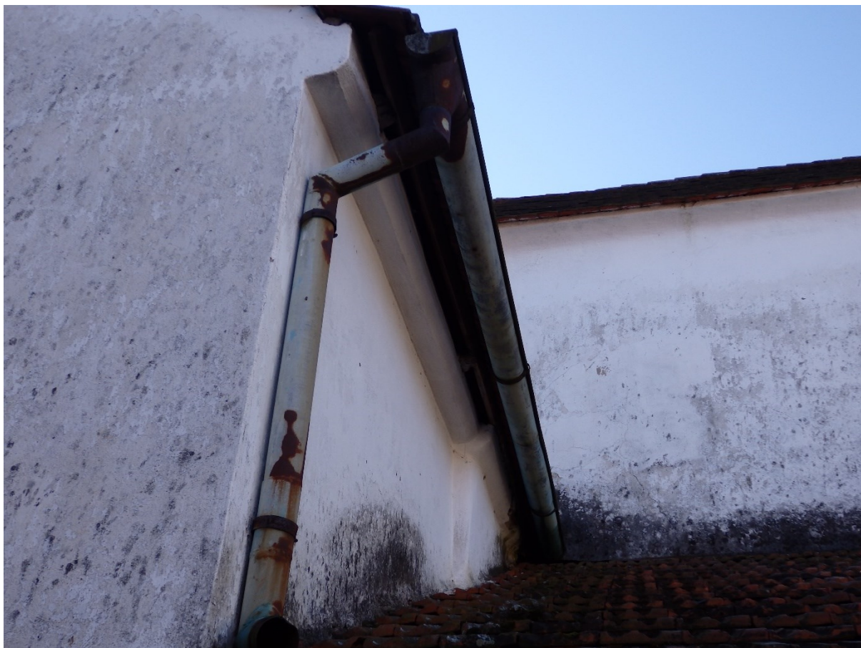
16) Podsklepený přístavek, detail zlomu a přechodu korunní římsy v západní stěně (pozůstatek zaniklého malého stavení ), pohled ze dvora, ze severu, 2022.
