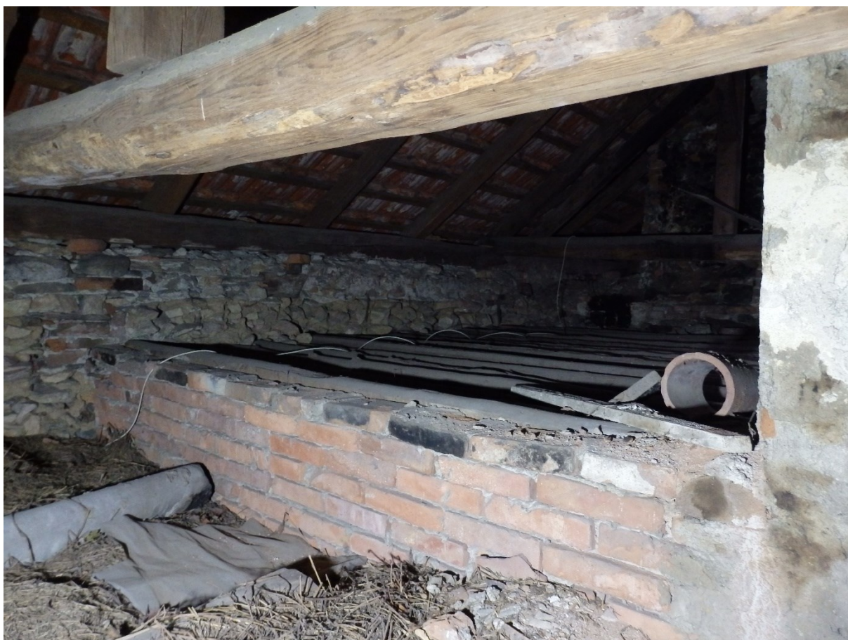
36) Obytné stavení, cihelná podezdívka povalového stropu kuchyně, pohled ze severozápadu, 2022.
