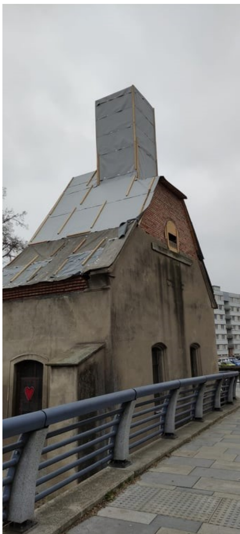
Kostel svaté Kateřiny, který v současné době prochází rekonstrukcí. 256
