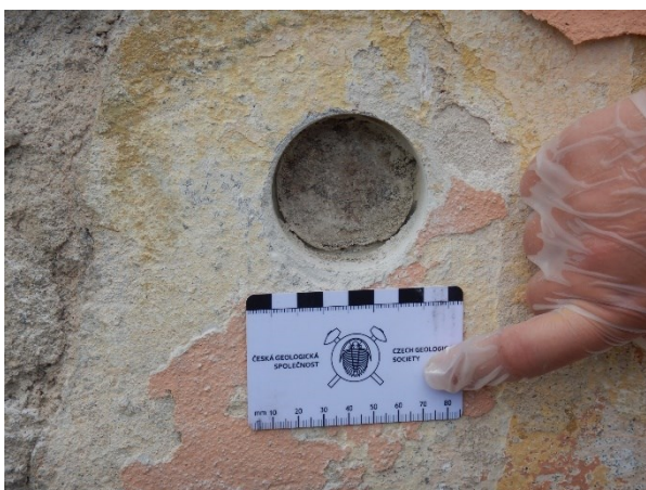
Obr. 9: Vyvrtaný otvor ve zdi domu č. 7 po odběru vzorku. Foto V. Goliáš 2022.
