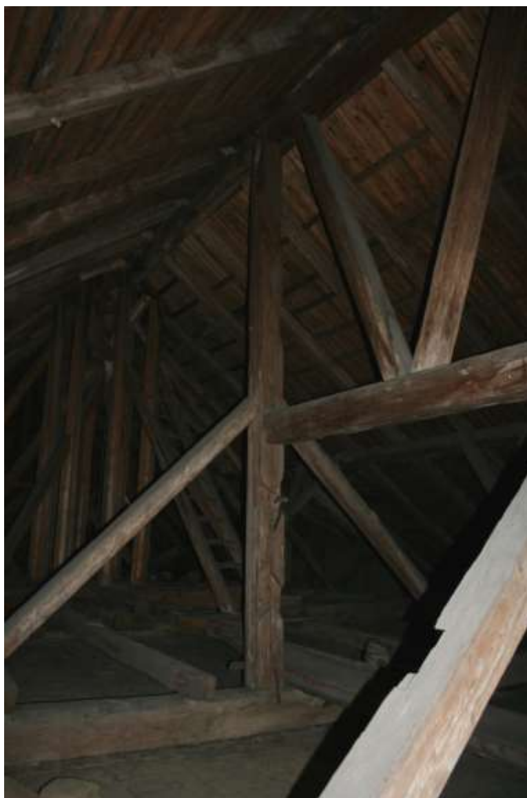
Obr. 43 Horní Měst, kostel sv. Máří Magdaleny, krov, dendrochronologicky datovaný do roku 1660 v úpravě z 19. století, dlaby ukazují dřívější spojení prvků
