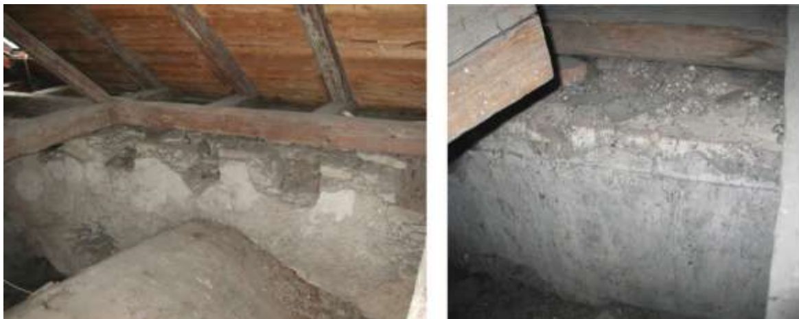
Obr. 31 Velká Polom, kostel sv. Václava, podkroví s otvory po starším zastropení. Bravantice, kostel sv. Valentina, obloun jako stopa po starším stropě. Foto autorka, 2006 a 2008.
