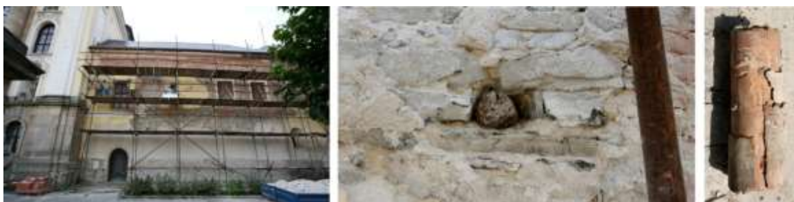
Obr. 44 Fulnek, kanonie augustiniánů při opravě a nosníky zabudovaného lešení (Foto: autorka, 2015)
