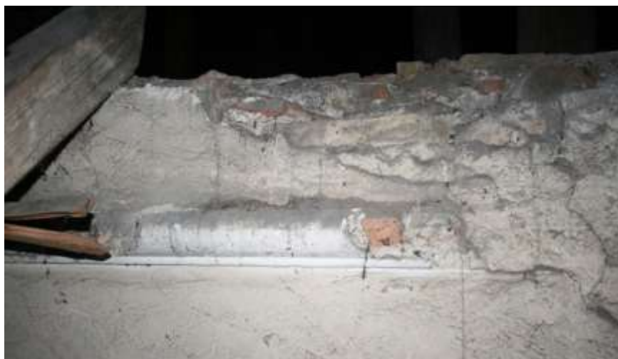
Obr. 34 Starý Jičín, kostel sv. Václava, podkroví jižní předsíně s torzem římsový, u níž je vidět její cihelná skladba (Foto: autorka, 2013)
