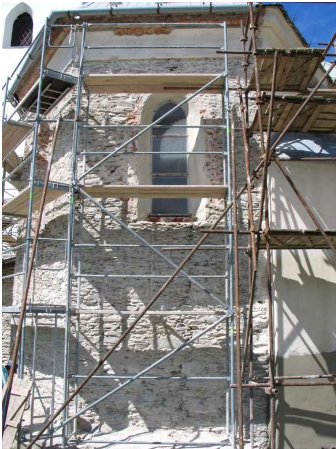
Obr. 32 Břidličná, kostel Tří svatých králů, východní strana presbytáře, spáry znamenající zazdívku okna, na něž dole navazují trhliny (Foto: autorka, 2006)
