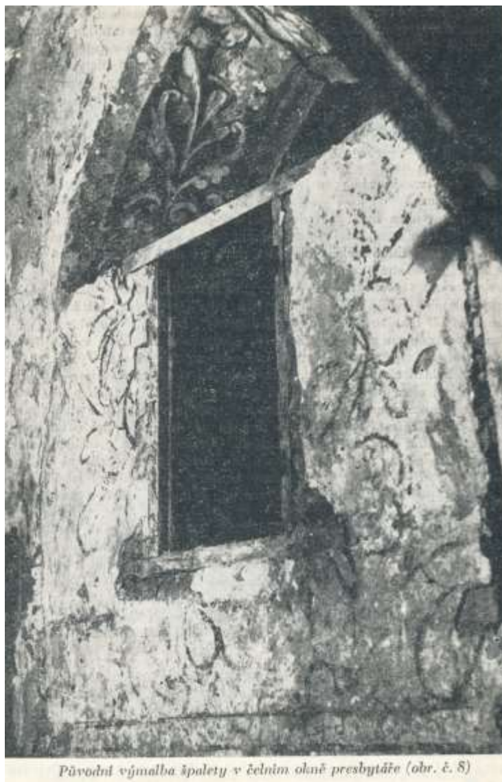
Obr. 55 Kostel sv. Václava, okno v presbytáři s malbami ve špaletě i na zadržce jako příklad nálezové situace a malou pravděpodobností intaktního dochování, Převzato z článku Milan HLUBINKA, Významné objevy při stavebně historickém průzkumu kostela sv. Václava v Ostravě. Ostrava. Sborník příspěvků k dějinám a výstavbě města 8, 1975.
