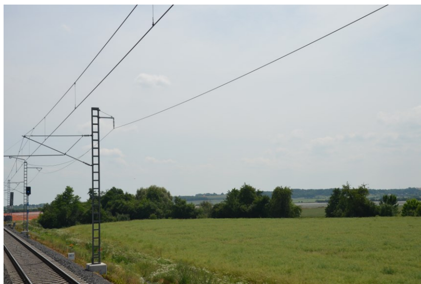
Obrázek 33: Přídatné vedení – na pravé straně stožáru vidíme malou konzoli, která přidržuje jednovodičové přídatné vedení. Při bližším pohledu je vidět mezi stožáry vodič, který spojuje přídatné vedení s trolejí.
