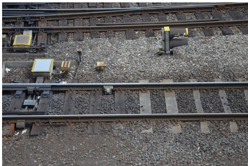
Obrázek 3: Dřevěné pražce pod výhybkou. Na bližší koleji je zleva vidět část výhybky – tato část koleje je upevněna na dřevěných pražcích (tmavší barvy). Směrem doprava pokračují pražce betonové (světlejší barvy). Na vzdálenější koleji jsou jen dřevěné pražce.
