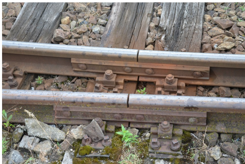
Obrázek 8: Kolejnicový styk na výhybce.
