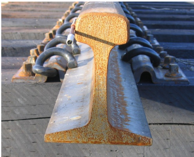
Obrázek 4: Profil kolejnice [3].
