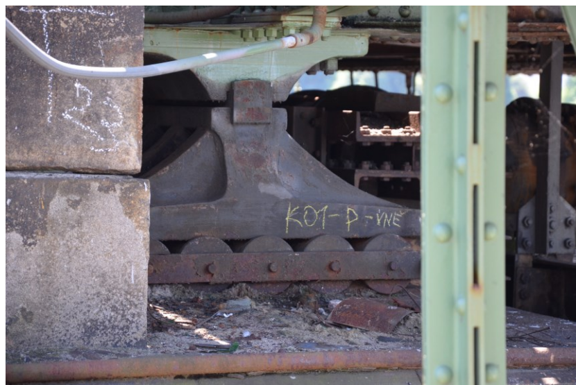
Obrázek 10: Mostová konstrukce posazená na válcové ložisko. Železniční most v pražské Výtoni.
