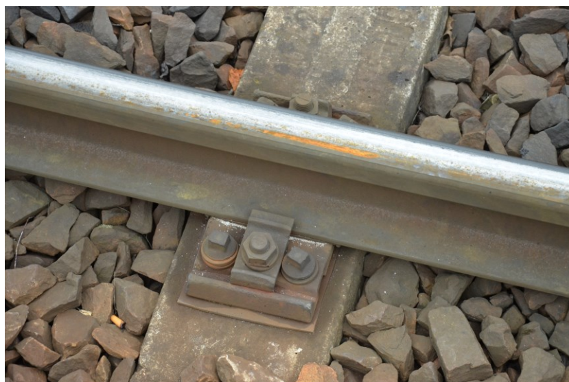
Obrázek 6: Rozponové upevnění. Dva krajní šrouby přichycují podkladnici k pražci, prostředním šroubem je upevněna vložka k podkladnici. Vložka přesahuje přes okraj paty kolejnice. Kolejnice je tak zajištěna proti příčnému pohybu, ale může se pohybovat podélně.
