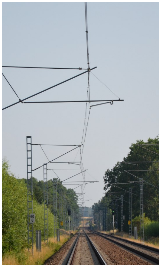
Obrázek 22: Klikatost troleje na rovném úseku. Klikatosti je docíleno tím, že je trolejový drát napínán střídavě na opačné strany – na nejbližším stožáru doprava, na dalším doleva, atd.
