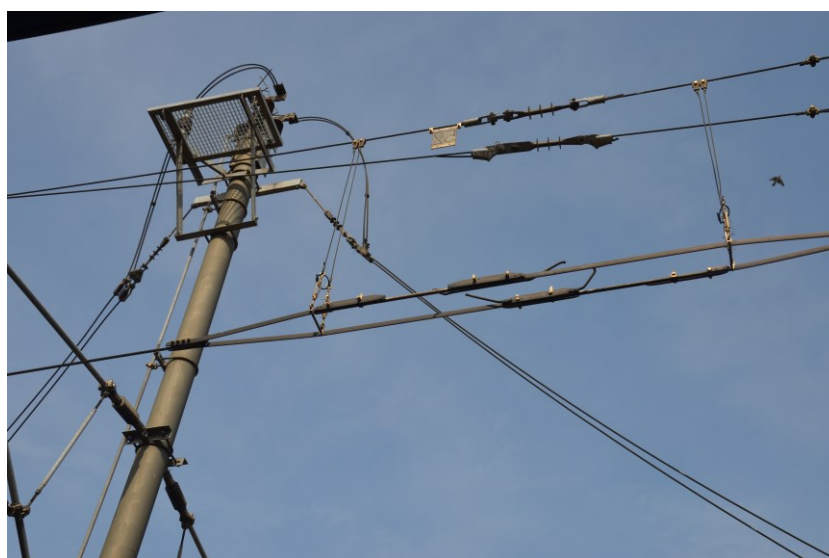
Obrázek 35: Úsekový dělič novějšího typu.
