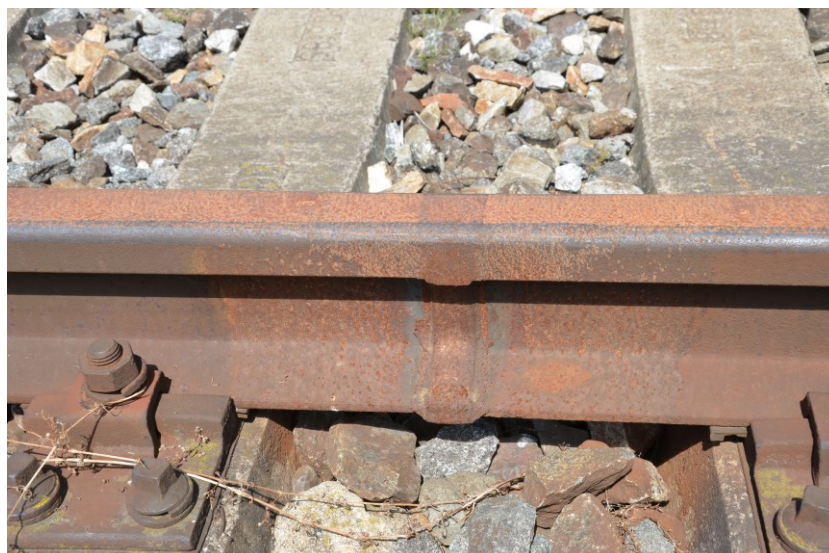
Obrázek 9: Svarový spoj.
