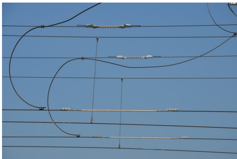
Obrázek 38: Izolační tyče na dvoukolejné trati.
