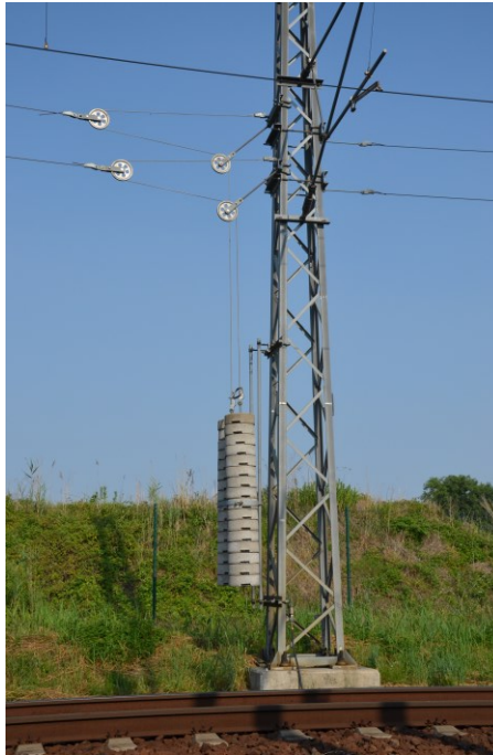
Obrázek 20: Kladkostroj. Na konci troleje je připevněna volná kladka, která potřebnou sílu k napnutí snižuje na polovinu. Díky tomu má závaží poloviční hmotnost, než by bylo třeba, kdyby bylo zavěšeno přímo na troleji.
