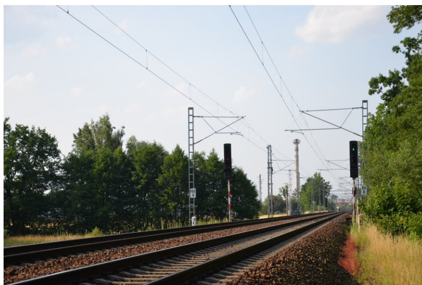
Obrázek 15: Dvoukolejná elektrifikovaná trať.
