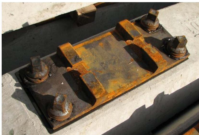
Obrázek 5: Podkladnice upevněná k pražci [5]. Do široké drážky ve střední části se vkládá kolejnice.
