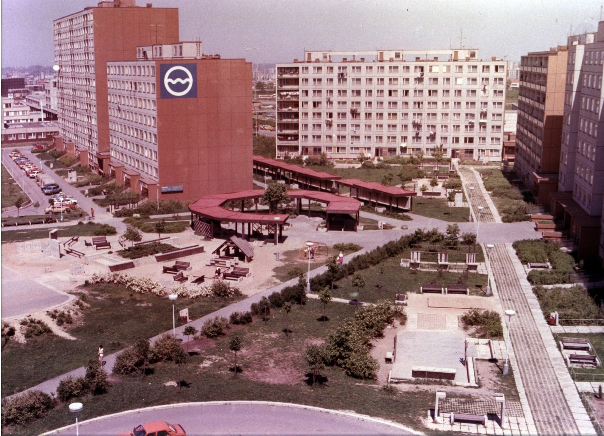
Obrázek 14 – Stavba Voda nedlouho po dokončení, zřejmě rok 1986, zdroj: archiv Vítězslavy Rothbauerové
