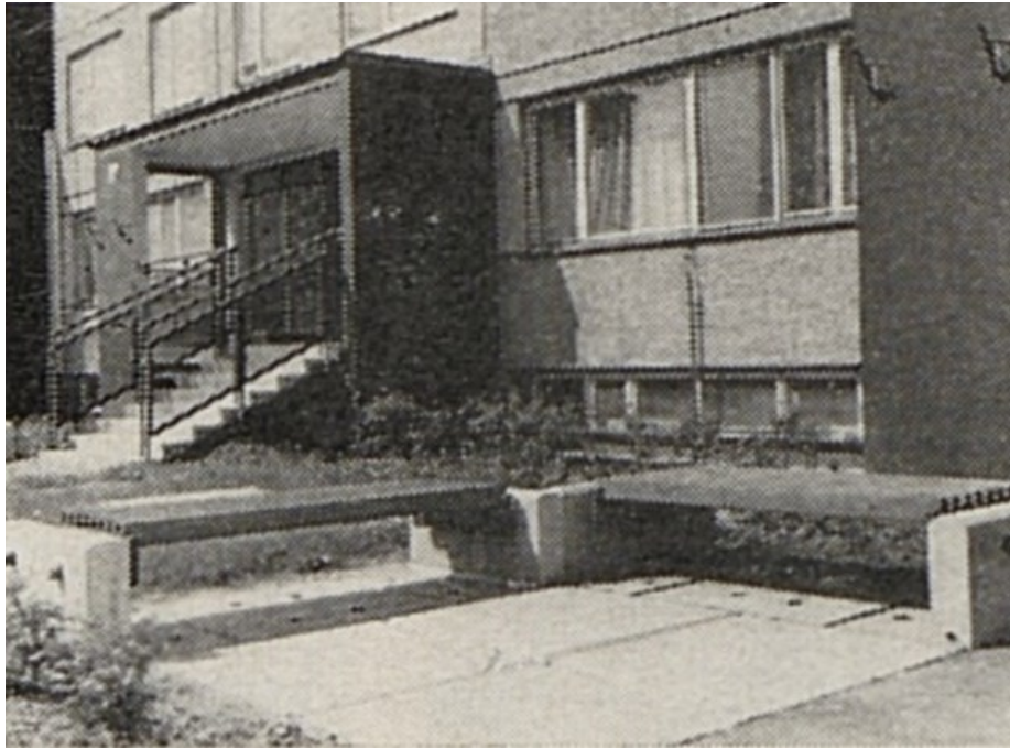
Obrázek 12 – Krytý vchod se zábradlím a lavičkami z typizovaných dílců drobné architektury, zdroj: Jižní Město II, západ, realizace 2. stavby, Architektura ČSR , č. 9 1984, s. 421
