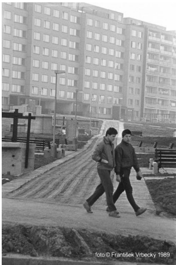
Obrázek 25 – Domy v konstrukční soustavě VVÚ-ETA na Jižním Městě II v roce 1989, zdroj: https://foto-vrbecky.estranky.cz/fotoalbum/autor-na-vystavach/2014---vystava-v-sujb-praha/jizni-mesto-ii-1989.--.html , dostupné k 31. 7. 2023, foto: František Vrbecký
