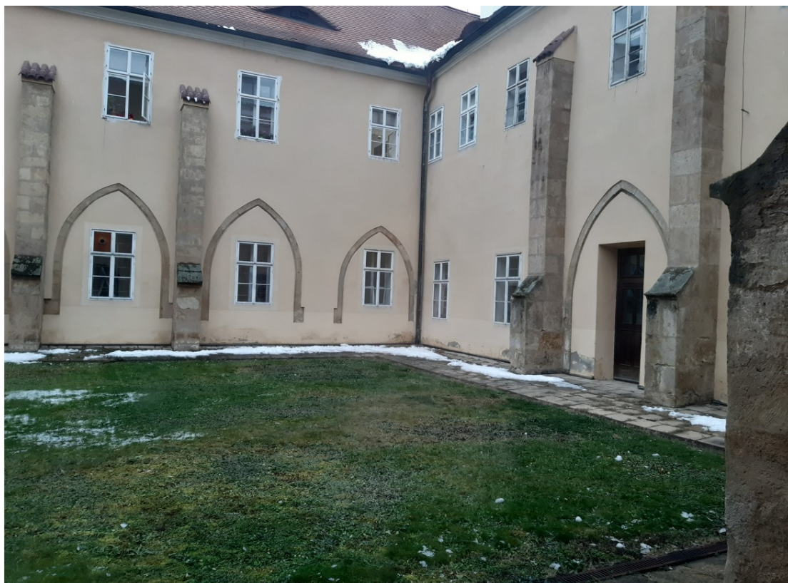
Obrázek č. 6: Rajský dvůr bývalého dominikánského konventu při zbouraném kostele sv. Michala v Litoměřicích. Současné sídlo SOA Litoměřice (stav z listopadu 2021).
