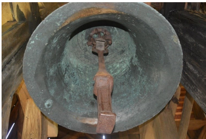
Obr. č. 1. Příklad uchycení létajícího srdce (Farní kostel Všech svatých, Hřešihlavy).
