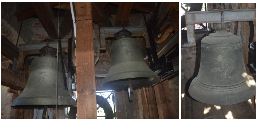
Obr. č. 8. Mirošov, kostel sv. Josefa. Příklad uchycení talířové koruny.
