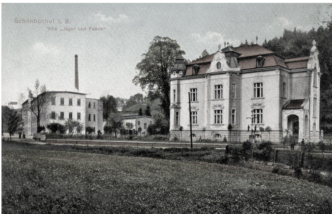
Příloha č. 13 – Jägerova vila spolu s přiléhající továrnou (zdroj: archiv Městského úřadu Krásná Lípa)
