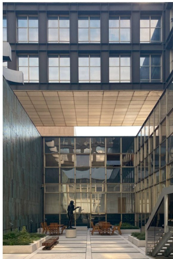
Obrázek 29: atrium v horních patrech budovy bývalého Federálního shromáždění, archiv autorky.
