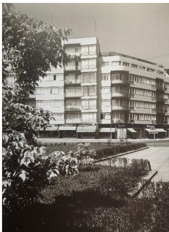
8. Richard F. Podzemný, Domy zemské banky (Skleněný palác), Praha-Dejvice, 1935–1937
