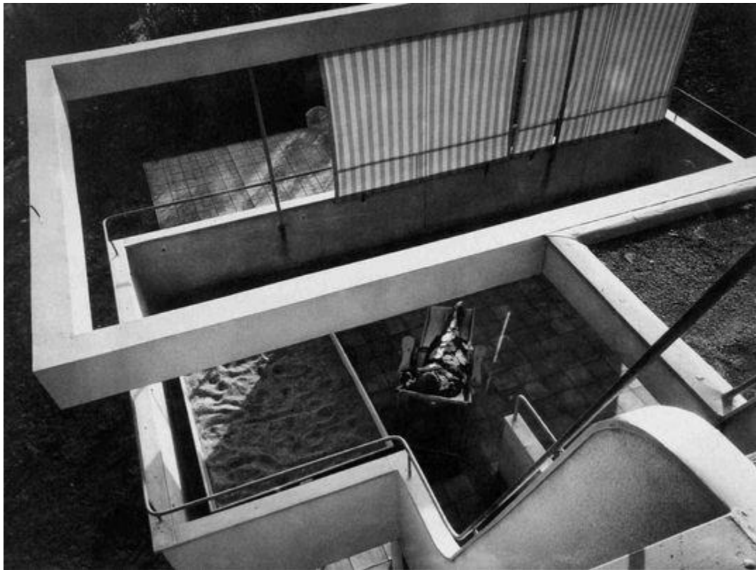
67. Ladislav Žák, Hainova vila se zahradou, Praha-Vysočany, 1932–1933, pohled na patrovou terasu
