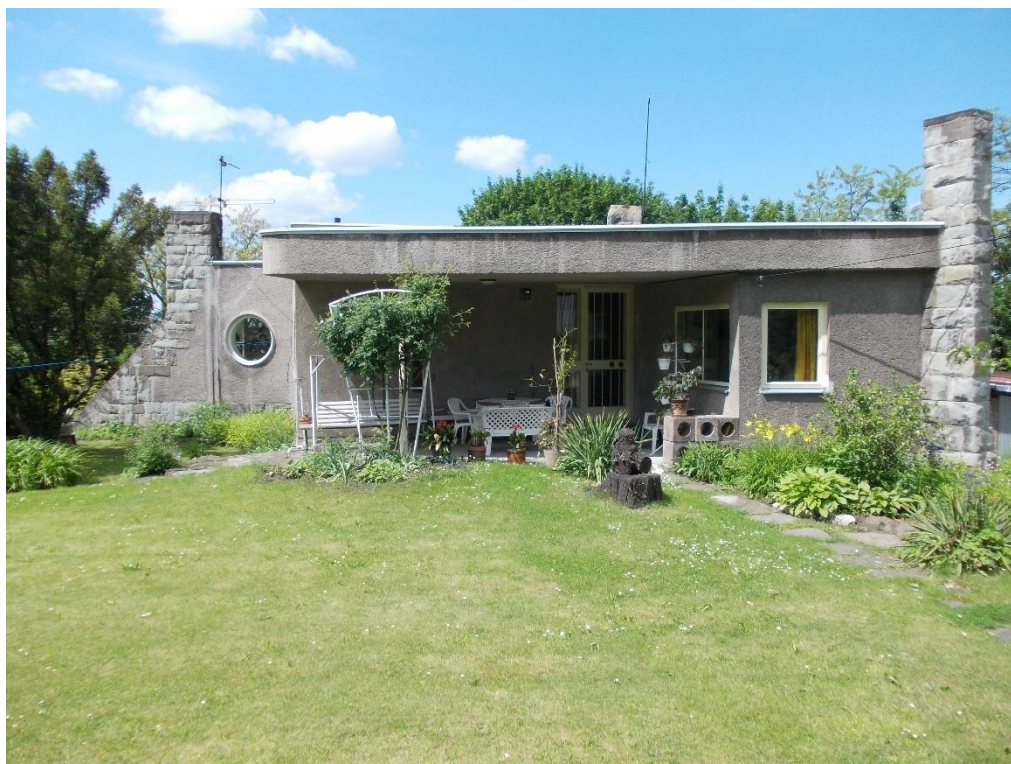
86. Lubomír a Čestmír Šlapetovy, Josef Vaněk, Liskova vila se zahradou, Ostrava, 1934–1935, pohled z východu na terasu, foto: 2018
