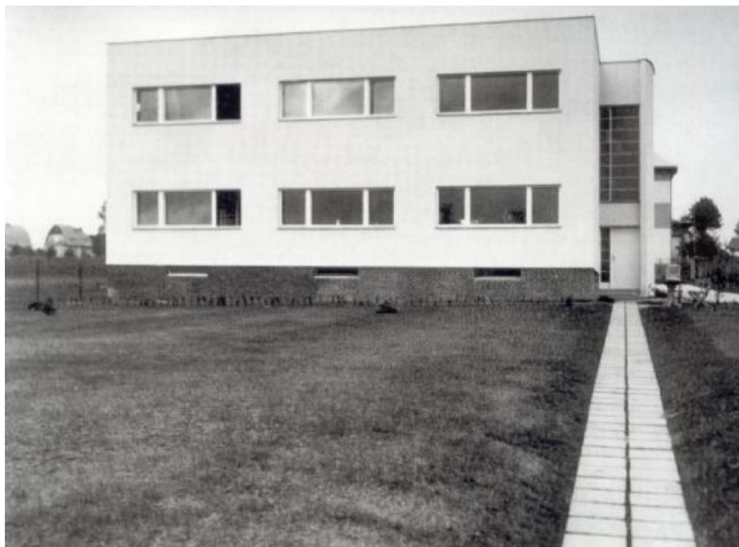
44. Lubomír a Čestmír Šlapetovy, Vila Schön, Příbor, 1932–1933, pohled z jihu
