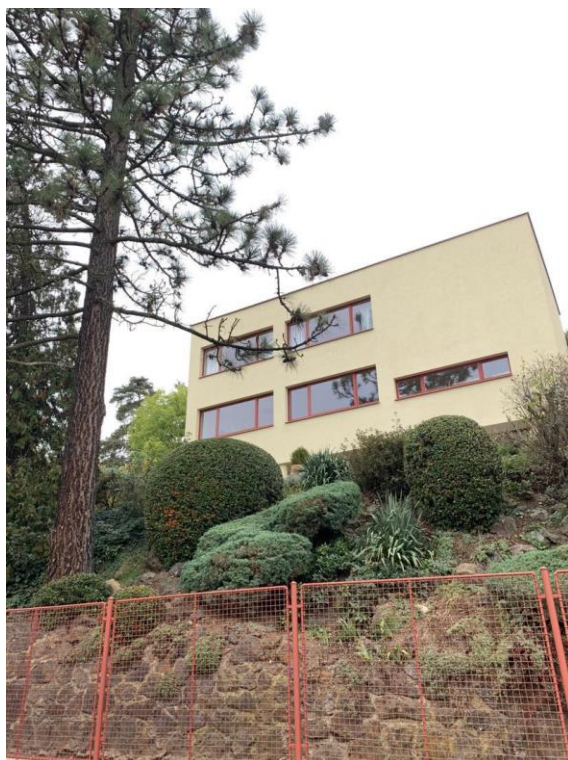
56. Osada Baba, Vila se zahradou Sutnarových, Oldřich Starý a Otokar Fierlinger, 1931–1932, pohled z jihu, foto: 2023
