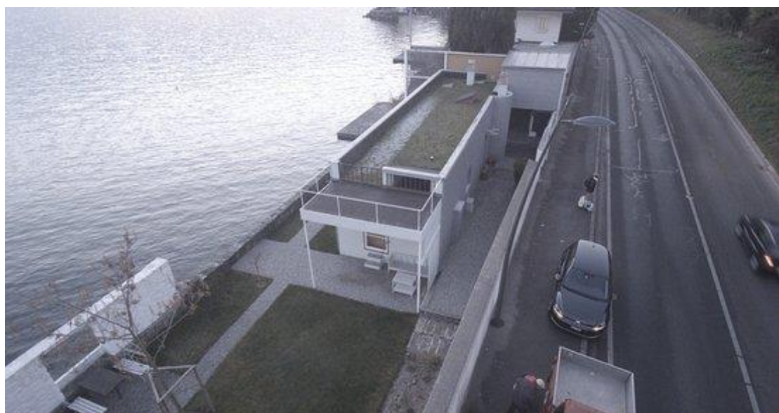
36. Le Corbusier a Pierre Jeanneret, zahrada vily Le Lac, Les Corseaux, 1923/ 1953, pohled ze shora, současný stav
