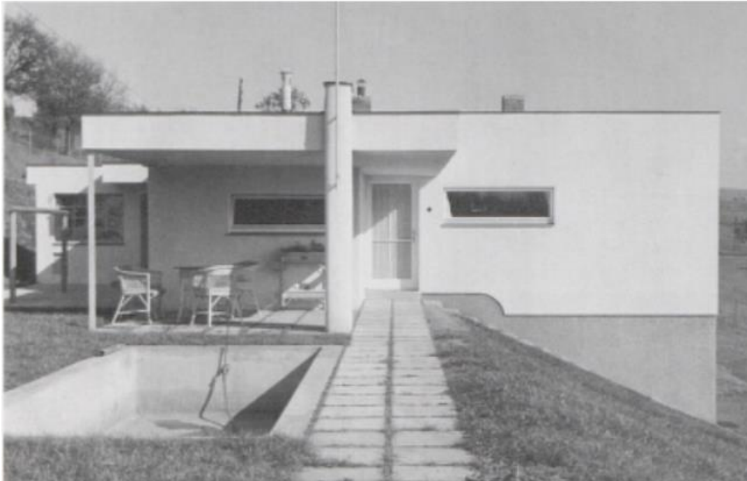
43. Lubomír a Čestmír Šlapetovy, Vila Josefa Kotoučka, Příbor-Klokočov, 1932–1933, pohled ze západu na rekreační bazén a krytou terasu
