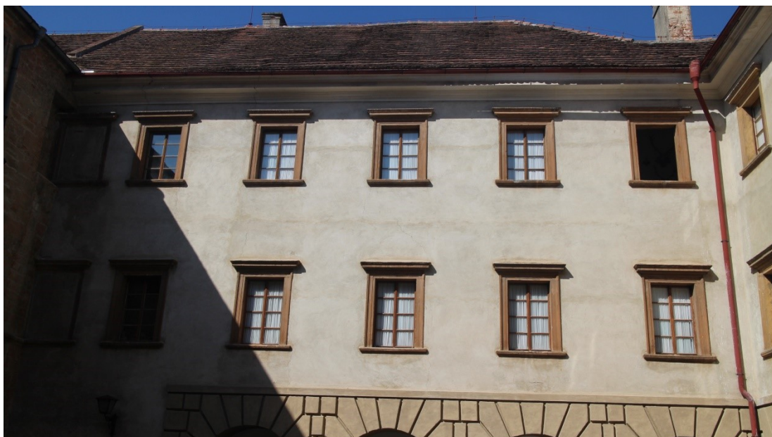
107. Nádvoří zámku, obr. 1, dnešní stav (k 23. 8. 2023), zdroj archiv autora .
