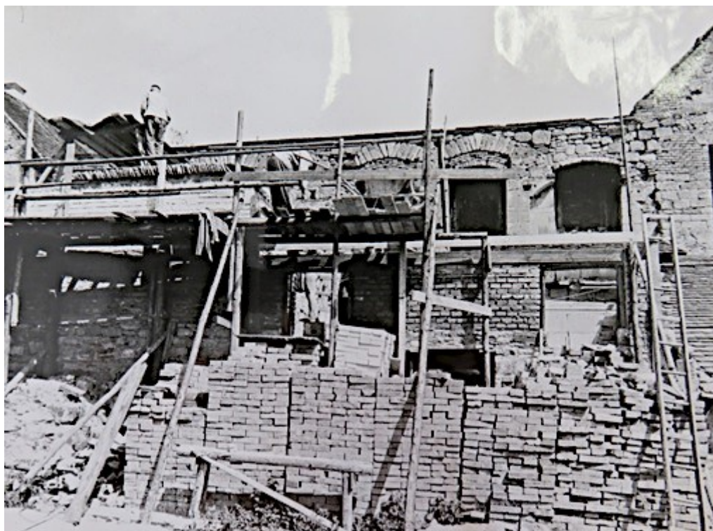
52. Budování gotické části zámku, nedatováno, zdroj fond OS SH, fotografie zámku.
