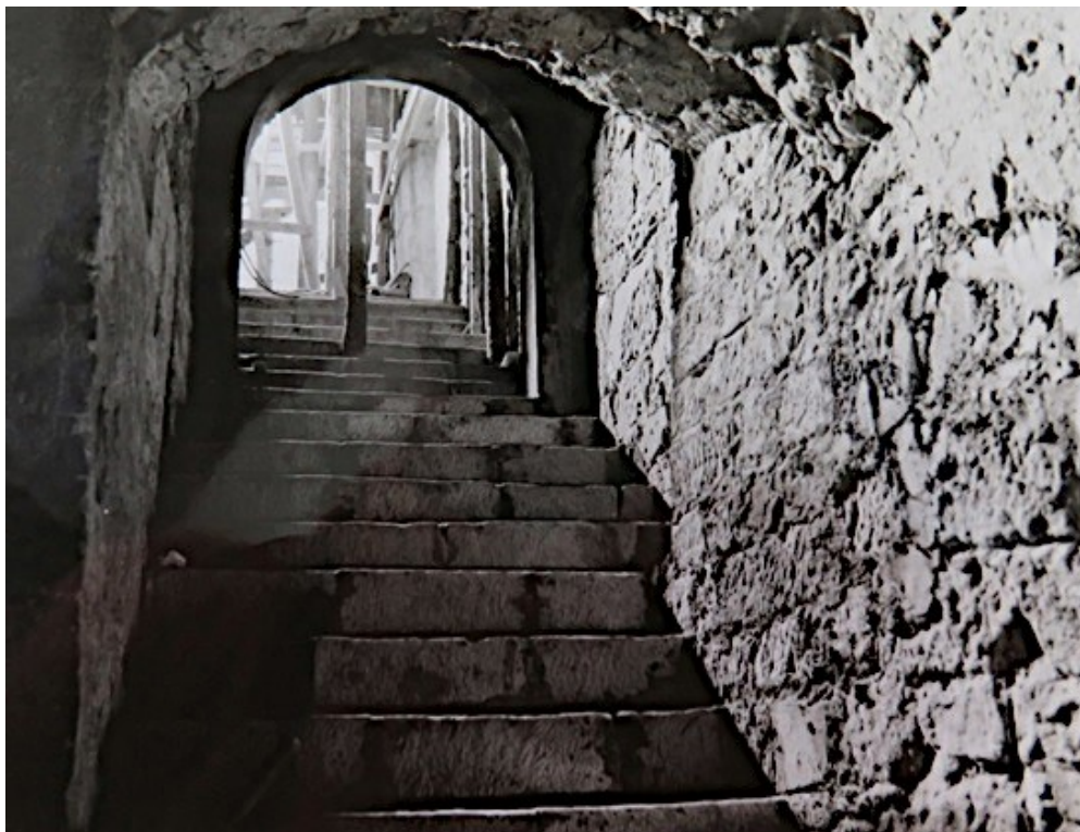
59. Schody z přízemí gotické části do 1. patra, nedatováno, zdroj fond OS SH, fotografie zámku.
