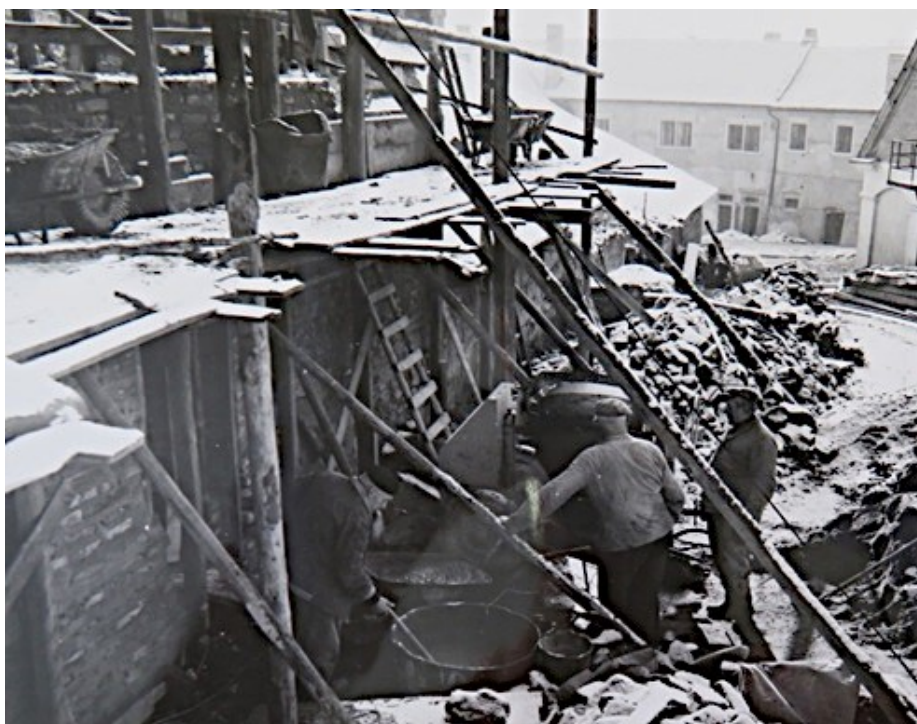
56. Budování gotické části zámku, nedatováno, zdroj fond OS SH, fotografie zámku.
