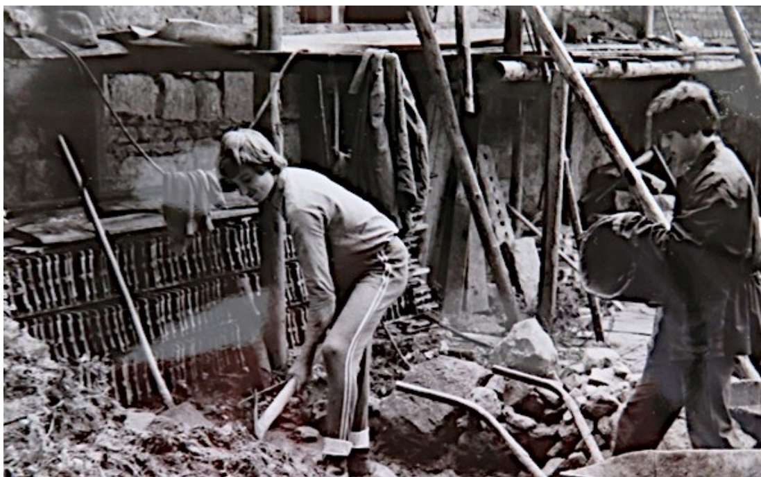
57. Budování gotické části zámku, nedatováno, zdroj fond OS SH, fotografie zámku.
