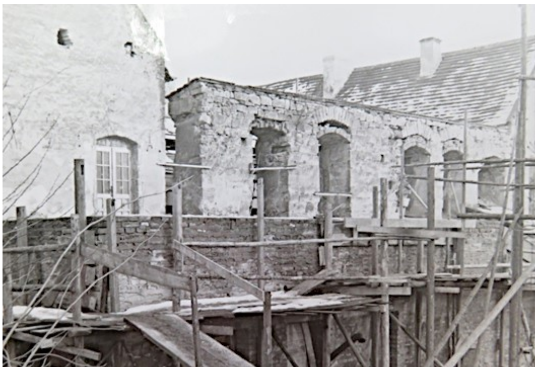
49. Budování gotické části zámku, nedatováno, zdroj fond OS SH, fotografie zámku.
