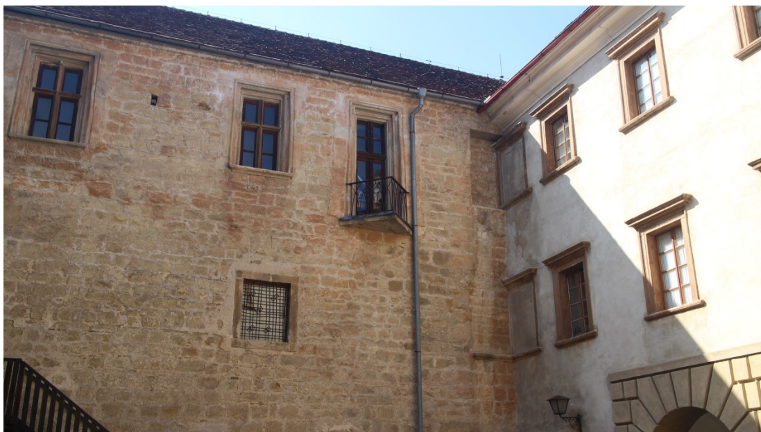
110. Nádvoří zámku, obr. 4, dnešní stav (k 23. 8. 2023), zdroj archiv autora .
