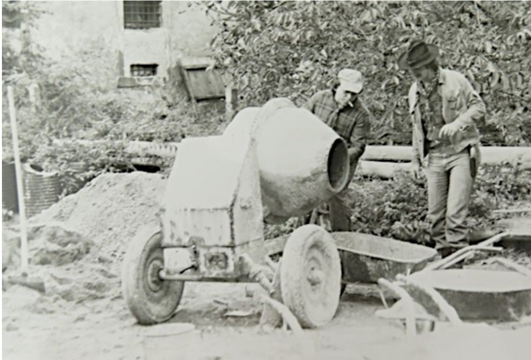
61. Trampové při práci za gotickou částí, nedatováno, zdroj fond OS SH, fotografie zámku.
