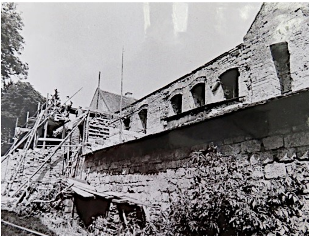
53. Budování gotické části zámku, nedatováno, zdroj fond OS SH, fotografie zámku.
