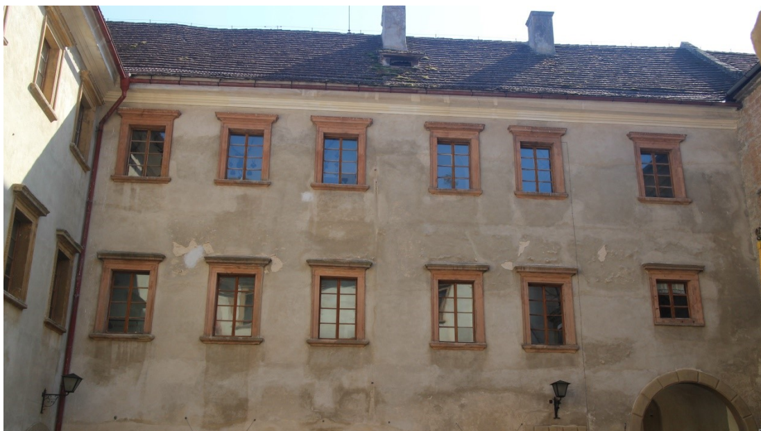
109. Nádvoří zámku, obr. 3, dnešní stav (k 23. 8. 2023), zdroj archiv autora .
