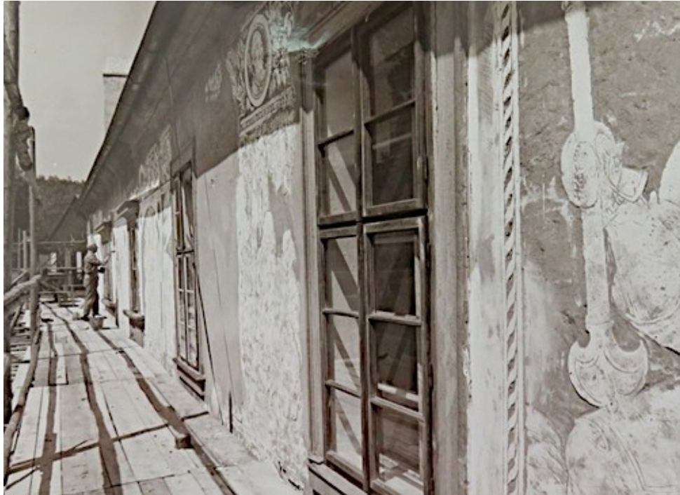
19. Oprava sgrafit v létě 1974, v pozadí akad. sochař Alois Tintěra, zdroj fond OS SH, fotografie zámku.
