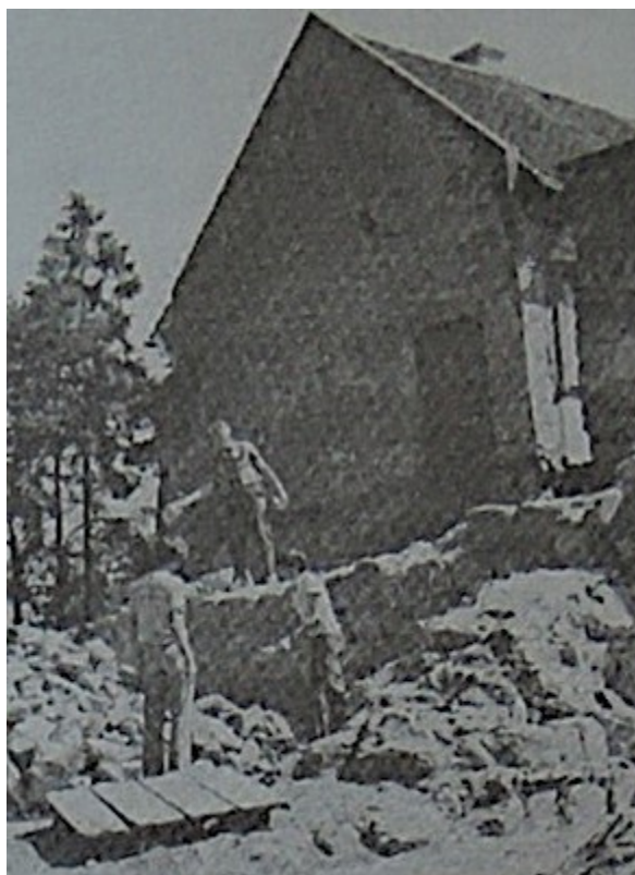
41. Práce na gotické části zámku, léto 1975, zdroj Staré Hrady: Paměť doby .
