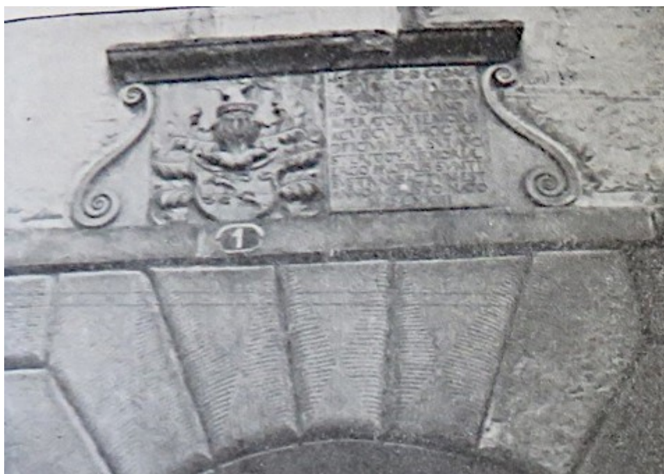
4. Detail vstupní brány, nedatováno, zdroj Opomíjené Staré Hrady u Libáně.
