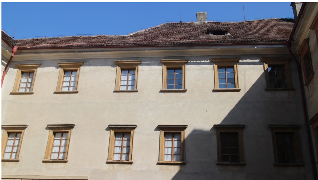
108. Nádvoří zámku, obr. 2, dnešní stav (k 23. 8. 2023), zdroj archiv autora .
