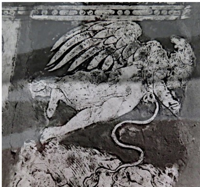
27. Oprava sgrafit v létě 1974, detail, zdroj fond OS SH, fotografie zámku.
