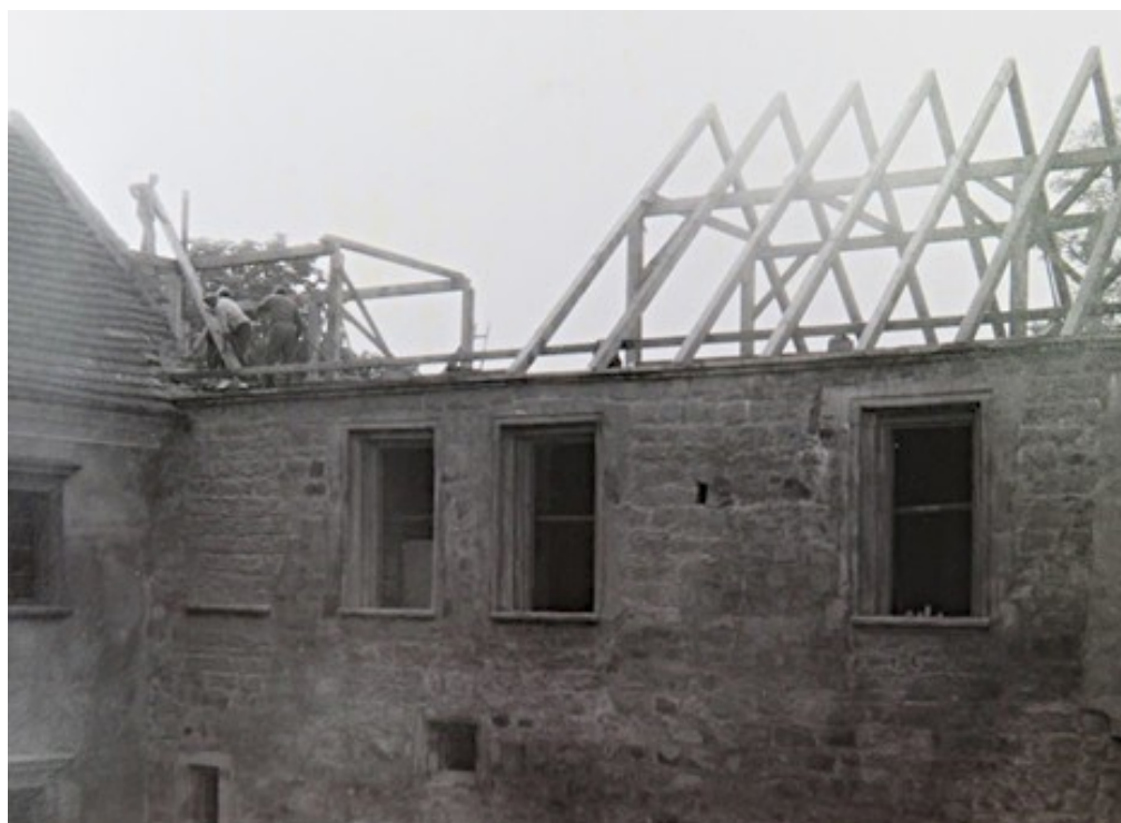
54. Budování gotické části zámku, nedatováno, zdroj fond OS SH, fotografie zámku.
