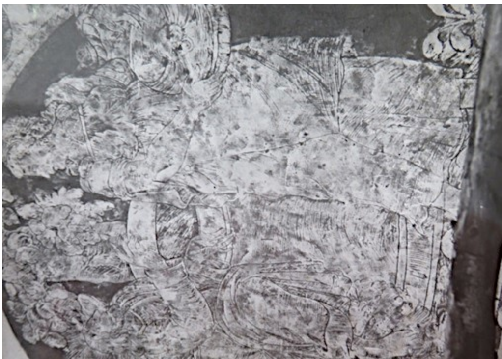
25. Oprava sgrafit v létě 1974, detail, zdroj fond OS SH, fotografie zámku.
