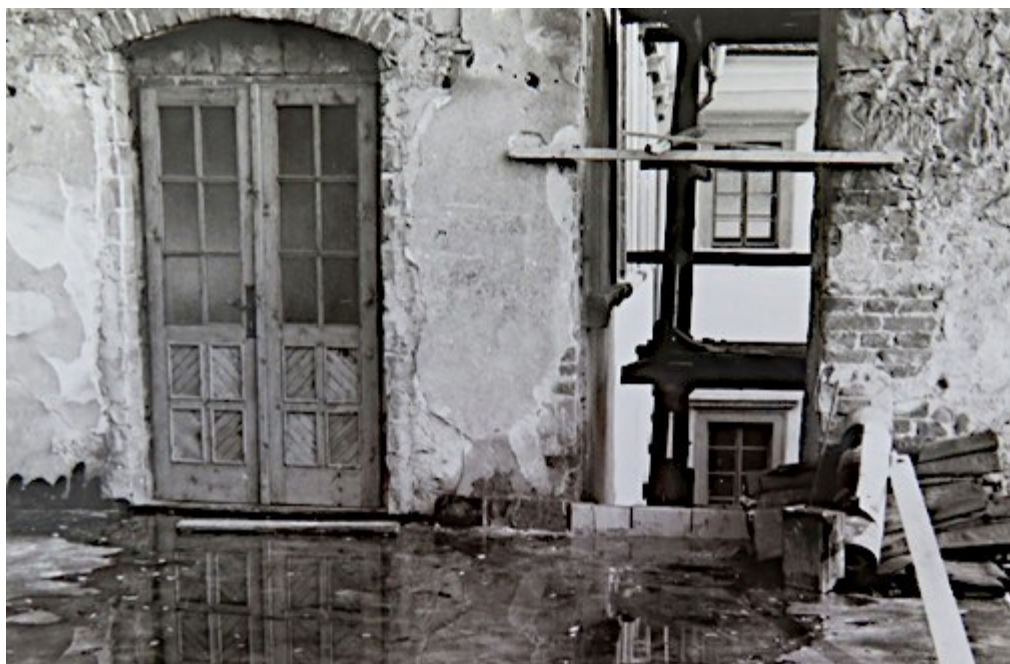
51. Budování gotické části zámku, nedatováno, zdroj fond OS SH, fotografie zámku.
