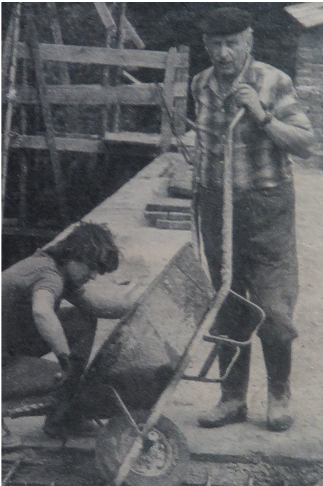
69. Vladimír Holman a jeho zapojení do rekonstrukčních prací po boku ochotné mládeže, nedatováno, zdroj fond OS SH, výstřižky článků z novin a časopisů (Květy, roč. 32, č 31, 1982).
