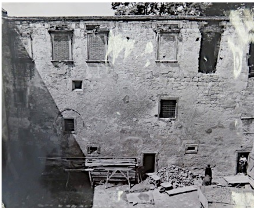
40. Pohled z chodby 2. patra zámku na zeď gotické části uzavírající na západní straně 2. zámecké nádvoří, nedatováno, zdroj fond OS SH, fotografie zámku.
