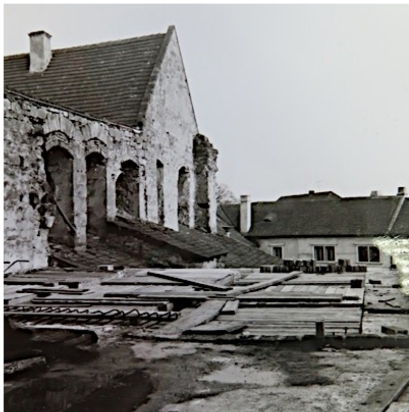
50. Budování gotické části zámku, nedatováno zdroj fond OS SH, fotografie zámku.
