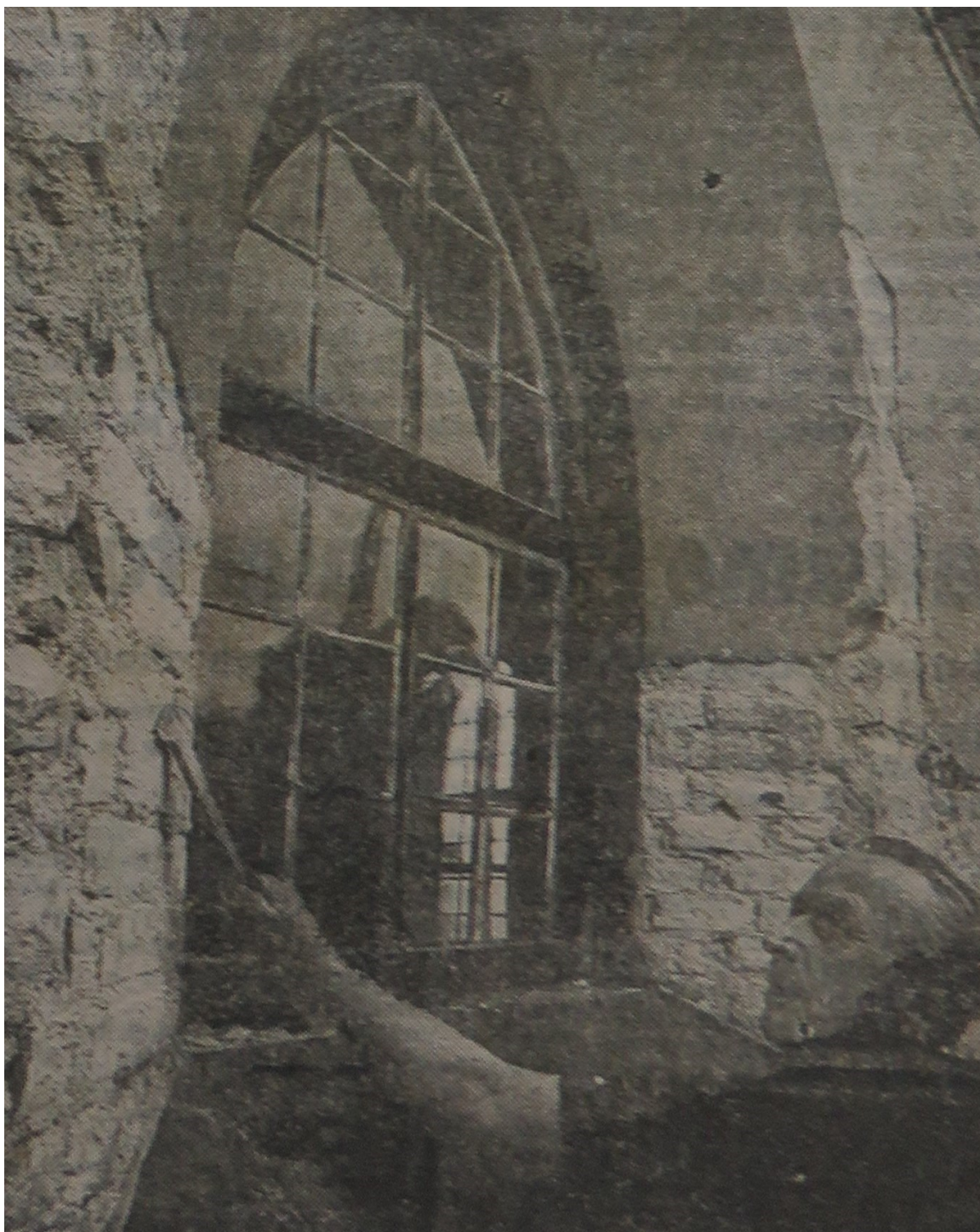
70. Vladimír Holman odstraňuje starou omítku okolo okna zámecké kaple, nedatováno, zdroj fond OS SH, výstřižky článků z novin a časopisů (Rudé právo, roč. 69, č. 186, 1989).
