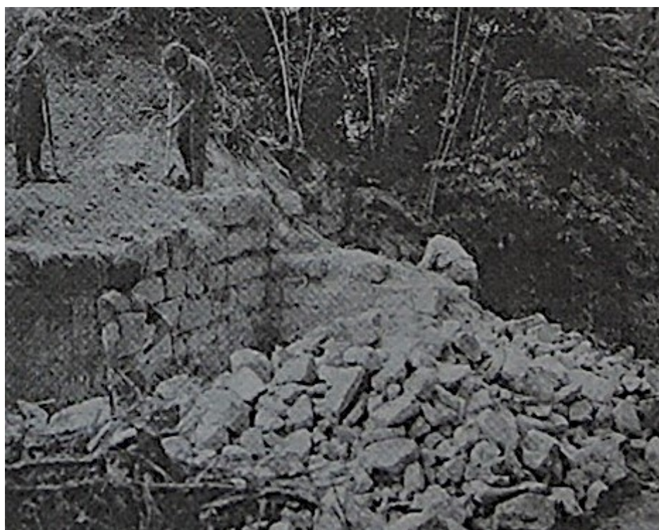
42. Práce na gotické části zámku, léto 1975, zdroj Staré Hrady: Paměť doby .
