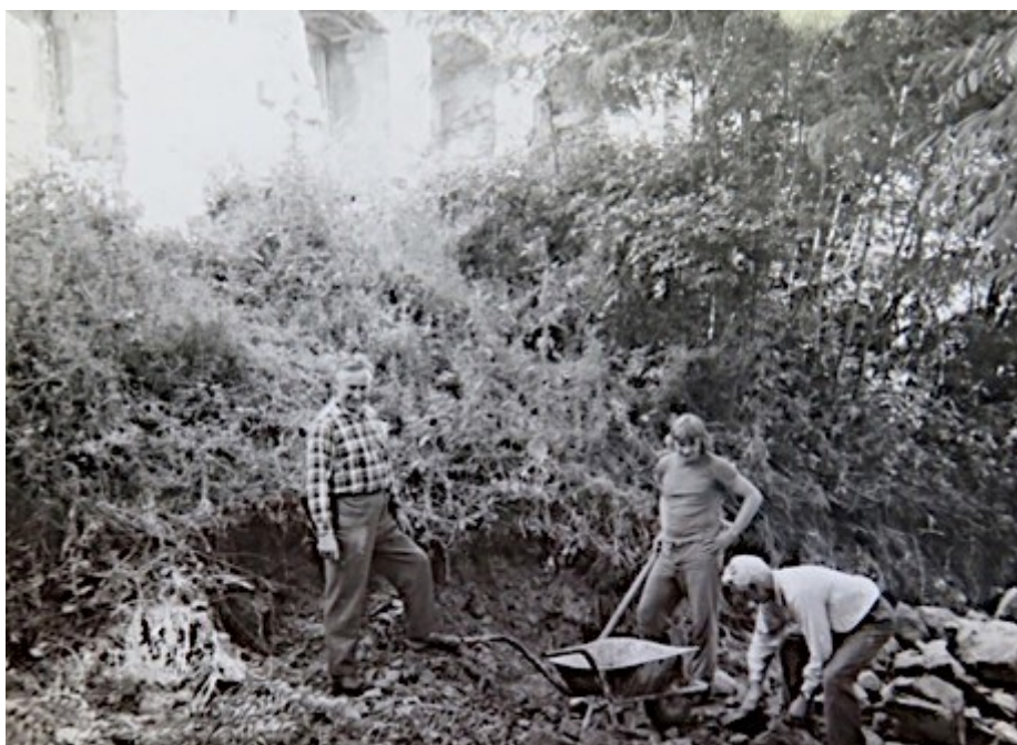
38. Začátek prací na gotické části v létě 1975, vlevo Vladimír Holman, zdroj fond OS SH, fotografie zámku.
