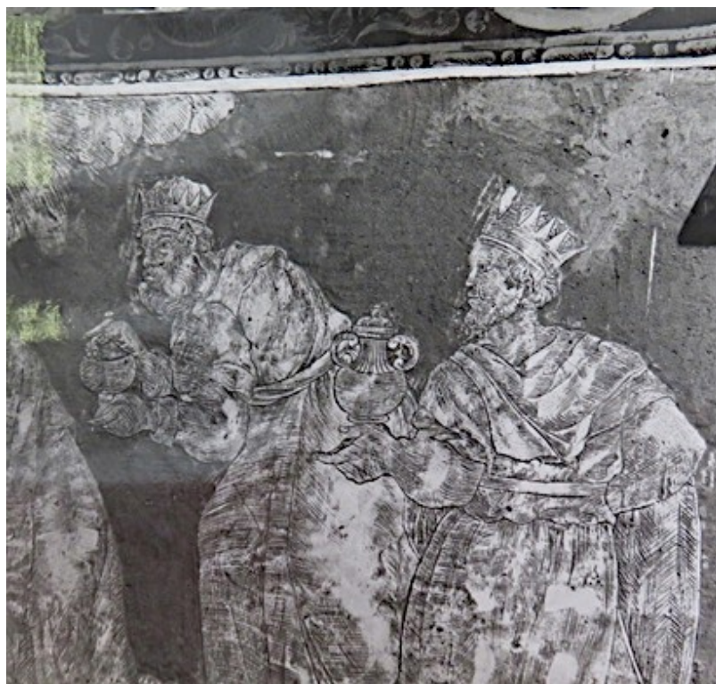
26. Oprava sgrafit v létě 1974, detail, zdroj fond OS SH, fotografie zámku.
