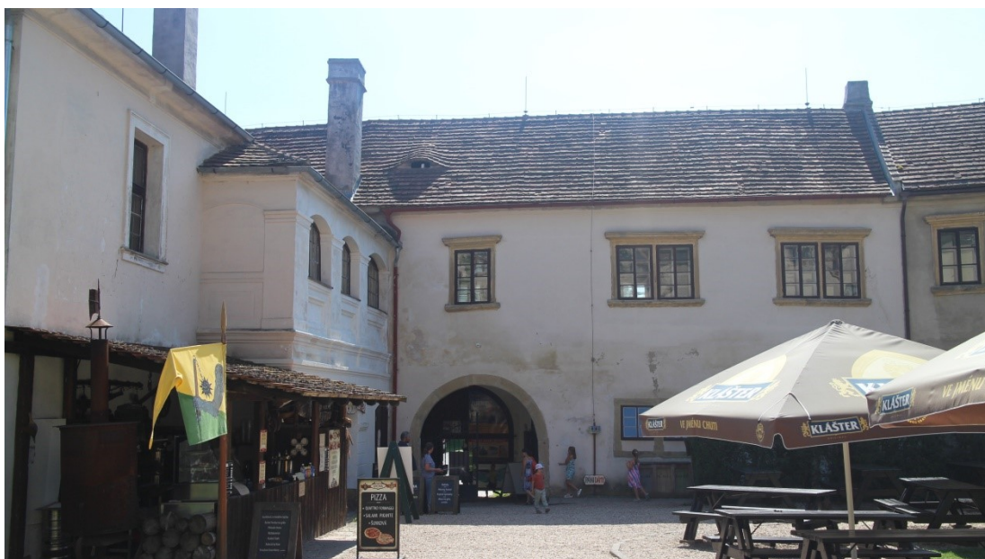
116. Předzámčí, obr. 2, dnešní stav (k 23. 8. 2023), zdroj archiv autora .
