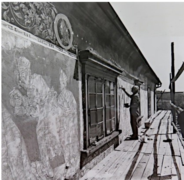
23. Oprava sgrafit v létě 1974, akad. sochař Alois Tintěra, zdroj fond OS SH, fotografie zámku.
