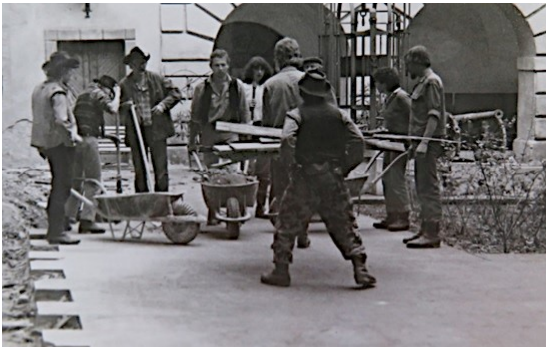
62. Trampové při práci na 2. nádvoří zámku u gotické zdi, nedatováno, zdroj fond OS SH, fotografie zámku.
