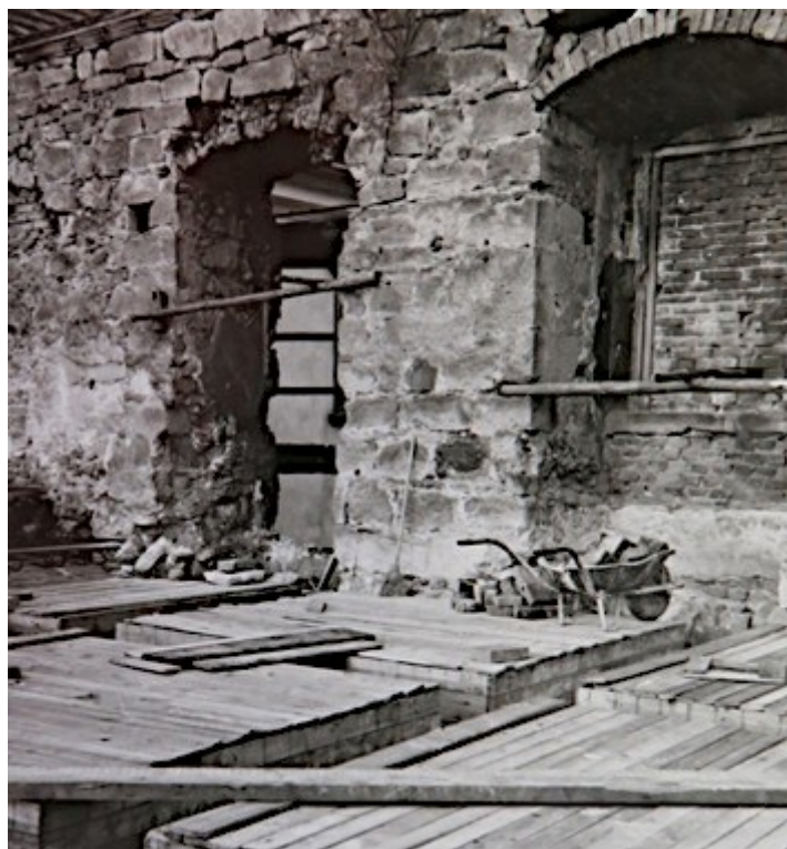
47. Budování gotické části zámku, nedatováno, zdroj fond OS SH, fotografie zámku.
