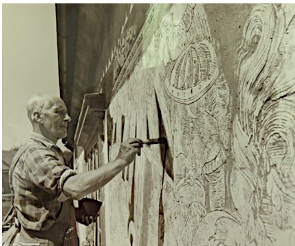
22. Oprava sgrafit v létě 1974, akad. sochař Alois Tintěra, zdroj fond OS SH, fotografie zámku.
