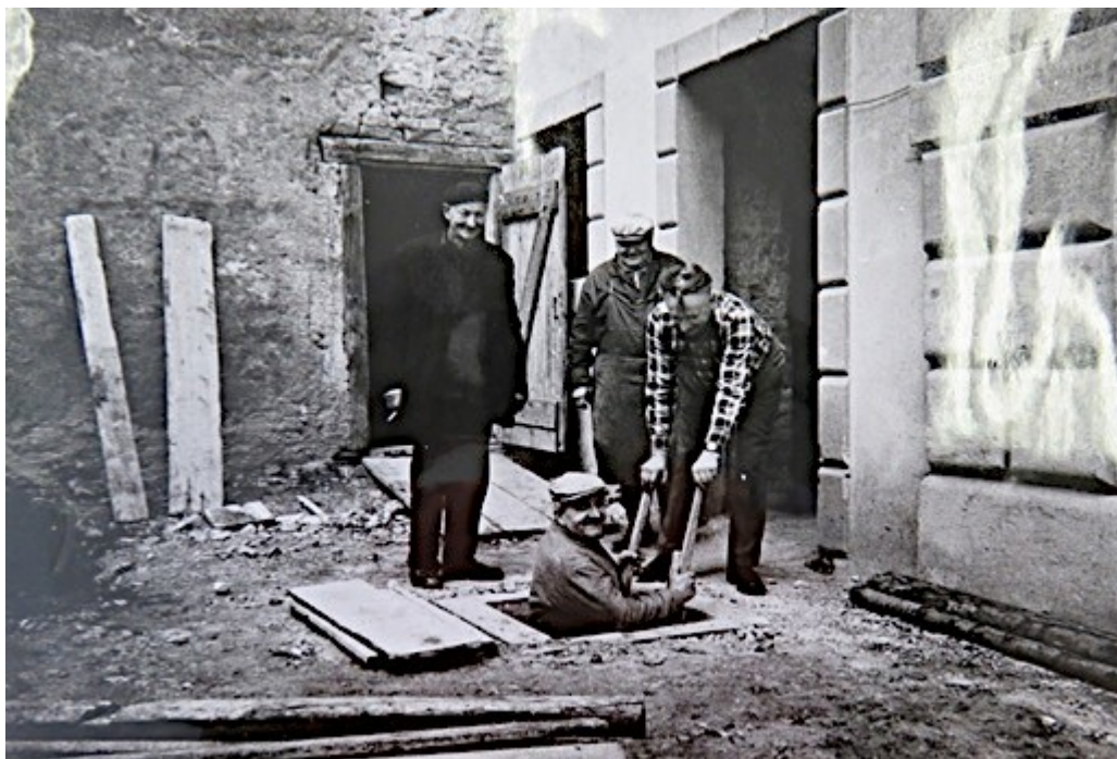
44. Práce na 2. nádvoří zámku, vpravo Vladimír Holman, nedatováno, zdroj fond OS SH, fotografie zámku.
