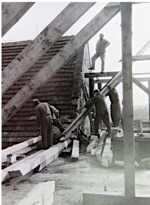
55. Budování gotické části zámku, nedatováno, zdroj fond OS SH, fotografie zámku.
