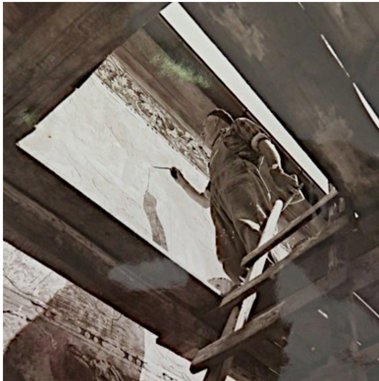
18. Oprava sgrafit v létě 1974, akad. sochař Alois Tintěra, zdroj fond OS SH, fotografie zámku.
