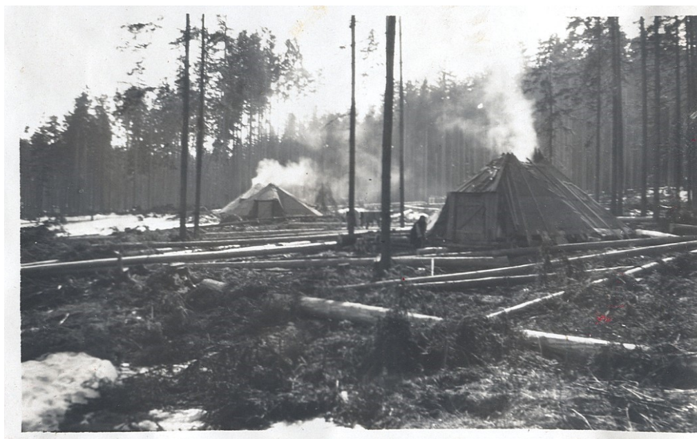
Příloha č. 4: Obydlí lesních dělníků pracujících na odstranění kalamitních škod v roce 1932.
