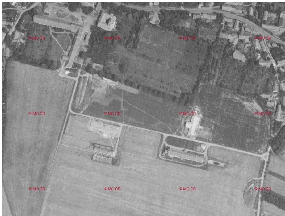
Obrázek 15 Vznikající zemědělské objekty v lokalitě Za Holubníkem (stav k 1. 8.1960) 531
