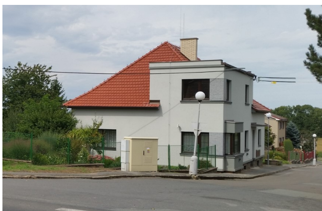
Obrázek 1 Budova obecního úřadu v Bečvárech v roce 2014 (foto: autor)
