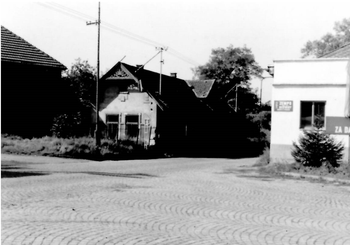
Obrázek 36 Křižovatka silnic Praha – Kutná Hora a Drahobudice – Horní Chvatliny. Zcela vlevo stavení čp. 162, stojící na místě bývalé panské kovárny, uprostřed stavení čp.29, vpravo kino čp. 22, sál bývalého hostince U Šauerů (zbořen 1966). (foto: Růžena Semanská)
