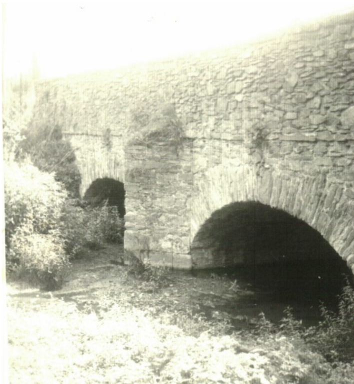
Obrázek 38 Původní mostek na přes Jelčanský potok. Postaven v roce 1925. V roce 2021 nahrazen novým mostkem. (foto: Růžena Semanská)
