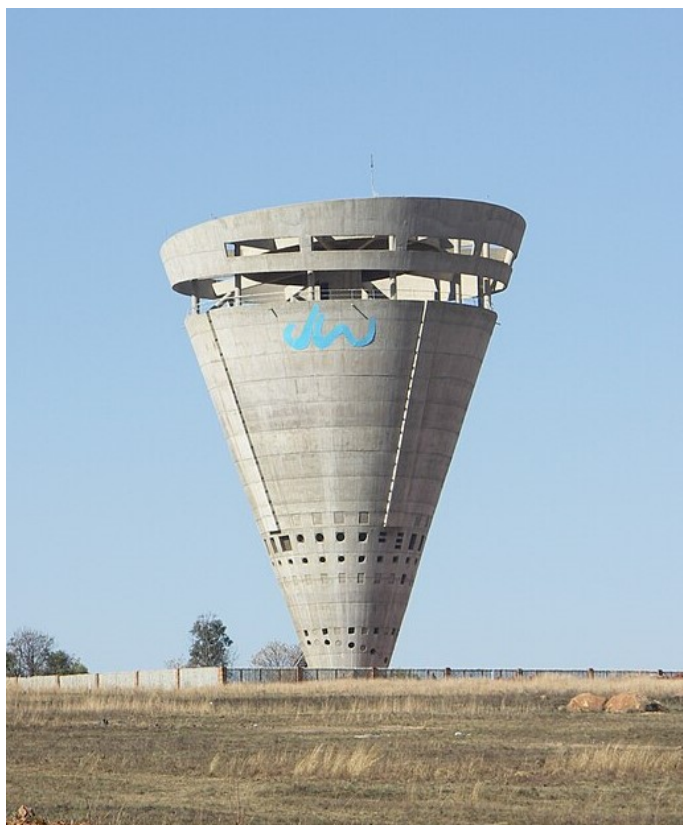
Obrázek 7.32: Vodárenská věž ve tvaru komolého kužele (Midrand, JAR)
