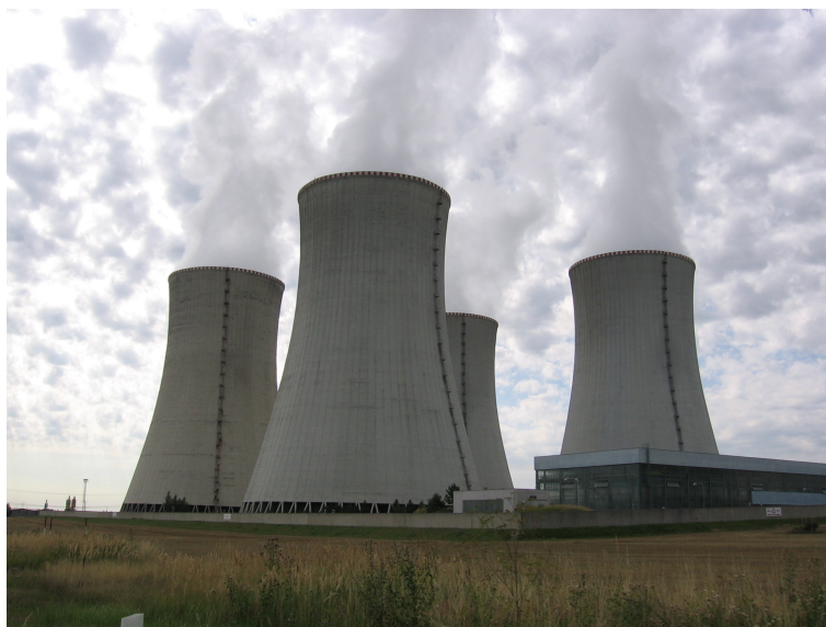
Obrázek 2.42: Chladicí věže jaderné elektrárny Temelín ve tvaru jednodílného rotačního hyperboloidu (Temelín, ČR) [80]
