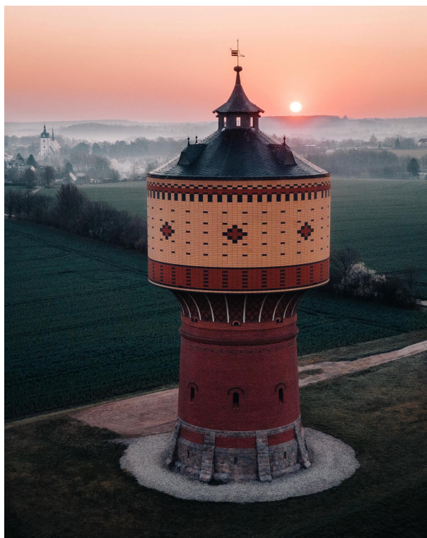
Obrázek 6.3: Vodárenská věž (Mittweida, Německo) [44]
