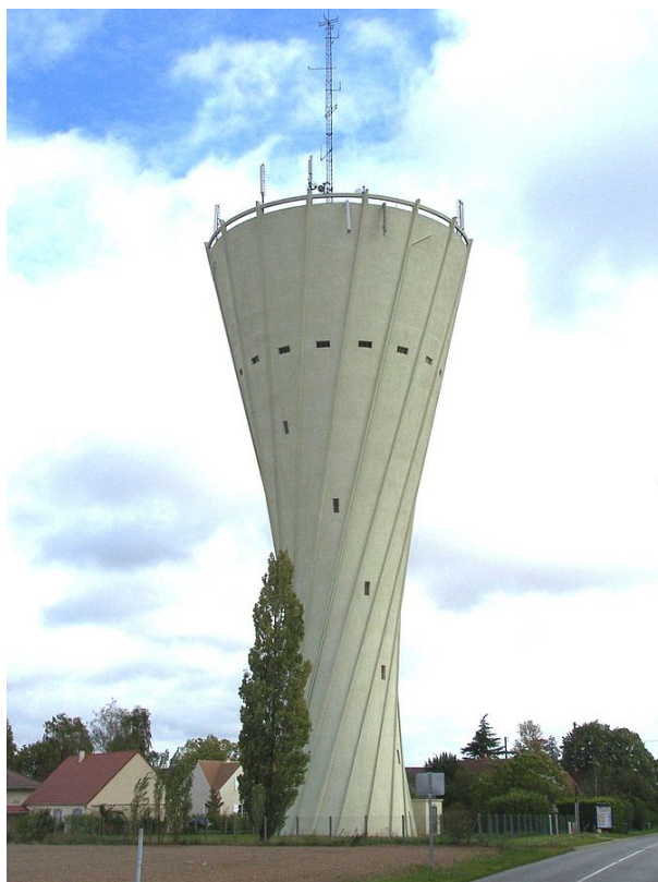
Obrázek 6.37: Vodárenská věž ve tvaru jednodílného rotačního hyperboloidu (Les Essarts-le-Roi, Francie) [83]
