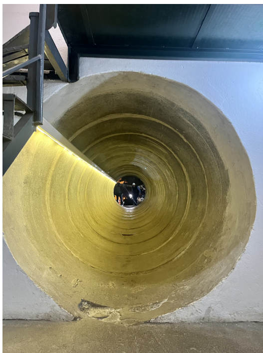
Obrázek 6.5: Betonový tunel (Ponta Delgada, Portugalsko)
