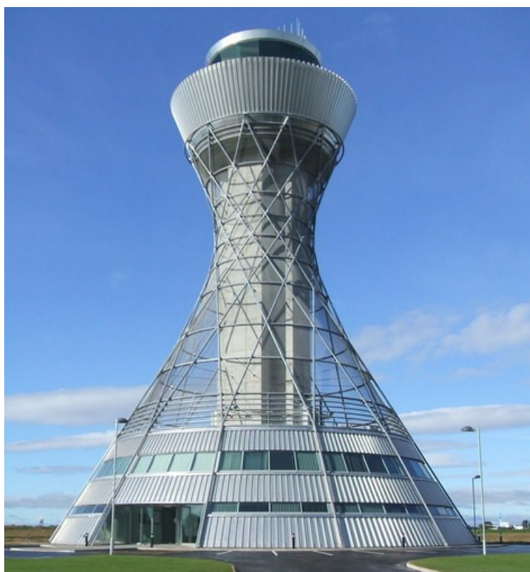
Obrázek 6.38: Řídící věž letecké dopravy ve tvaru jednodílného rotačního hyperboloidu (Newcastle, UK) [84]
