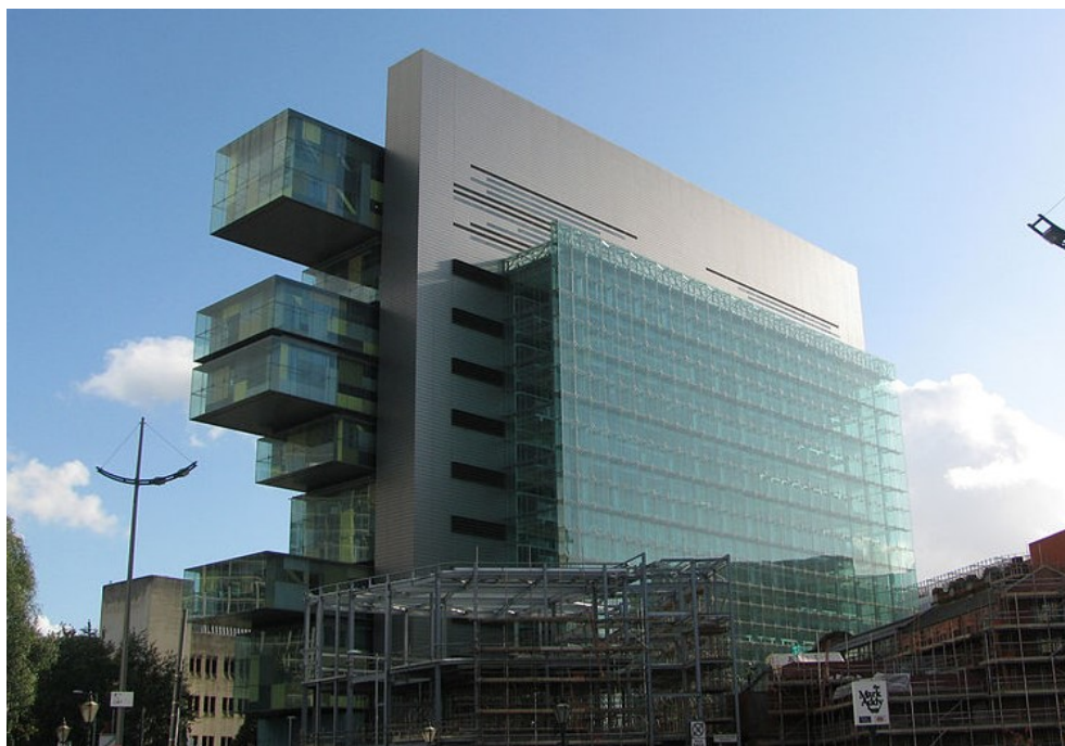
Obrázek 5.1: Budova Civil Justice Centre (Manchester, Velká Británie) [23]
