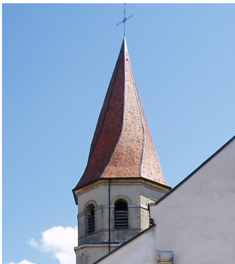
Obrázek 7.42: Antimodel kuželu – střecha kostela Saint-Laurent ve tvaru zkrouceného osmibokého jehlanu (Ceyzériat, Francie) [66]
