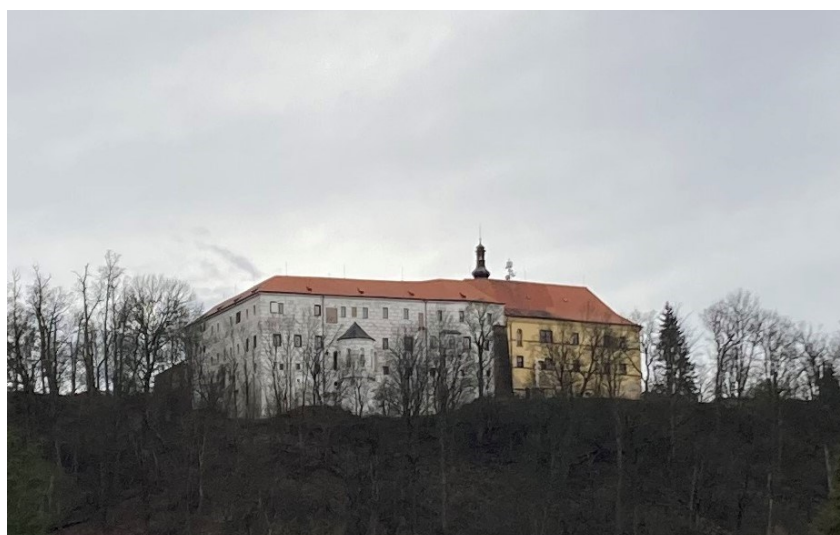
Obr. 28. Komorní Hrádek. Pohled na současný stav zámku od řeky Sázavy (foto autorka, 2023).
