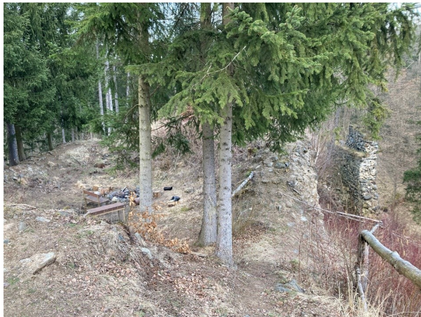
Obr. 40. Kožlí. Pohled z jihovýchodní strany jádra hradu. Vpravo zachycen vnitřní líc parkánové hradby (foto autorka, 2023).
