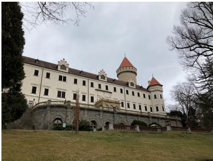
Obr. 34. Konopiště. Pohled na zámek z jižní strany (foto autorka, 2023).
