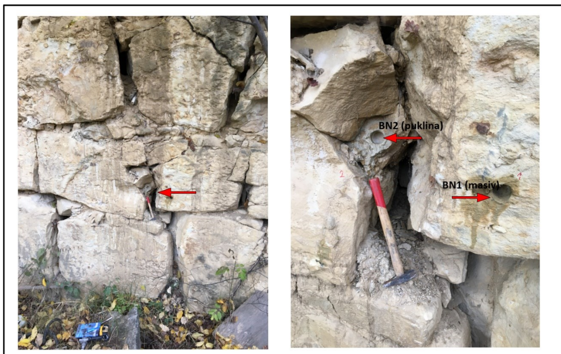
Obr. 6-51 Fotodokumentace výchozu a vzorkovaných míst jemnozrnných silně vápenných pískovců na lokalitě lomu v Benátkách.
