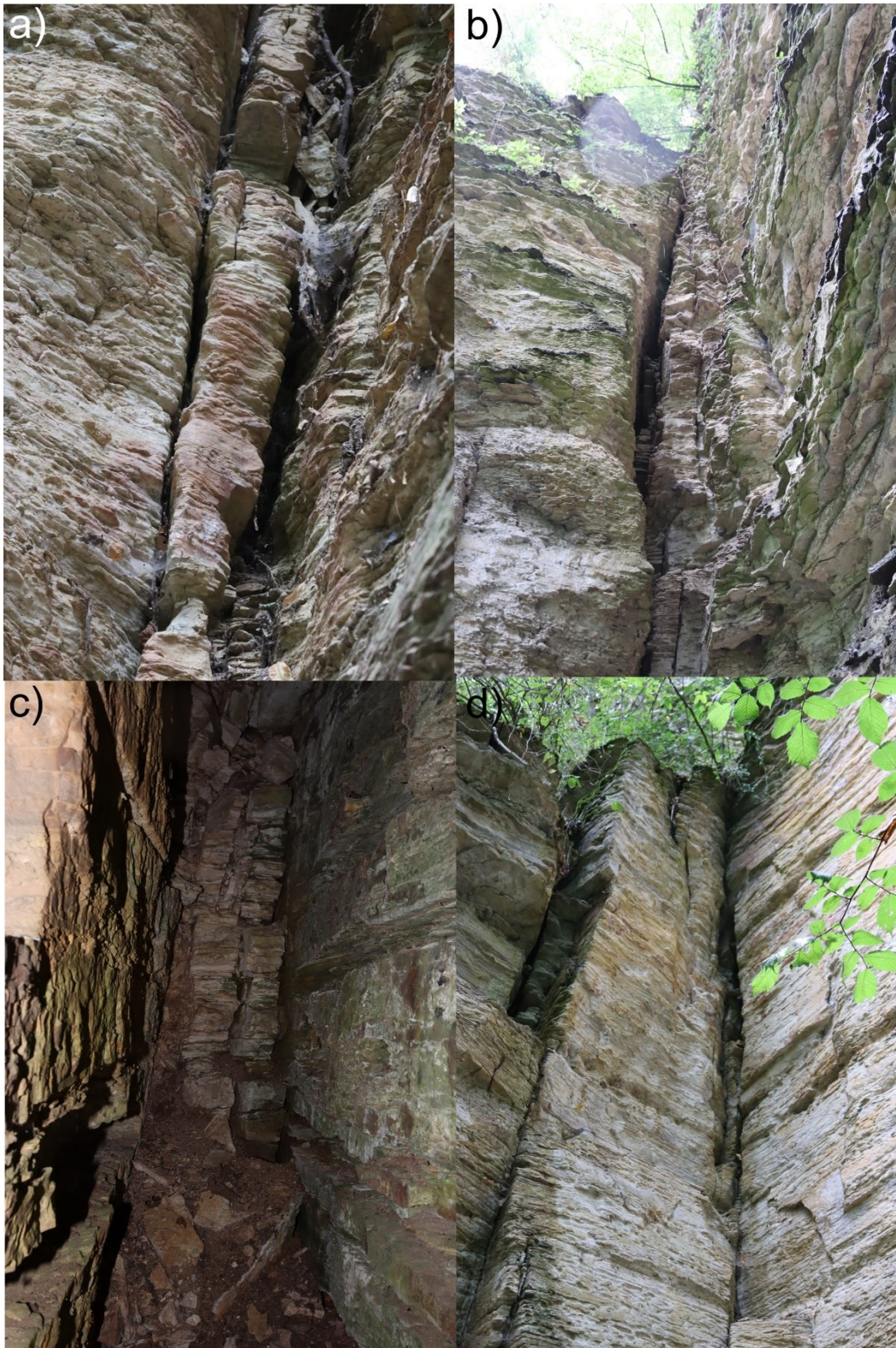
Obr. 7-15 Rozpukavé subvertikální zóny, jejichž vyloužením vznikají snadno odplavitelné malé úlomky. Vyplavení úlomků vytváří vysoce propustné zející trhliny. Nové Město nad Metují, kolektor B
