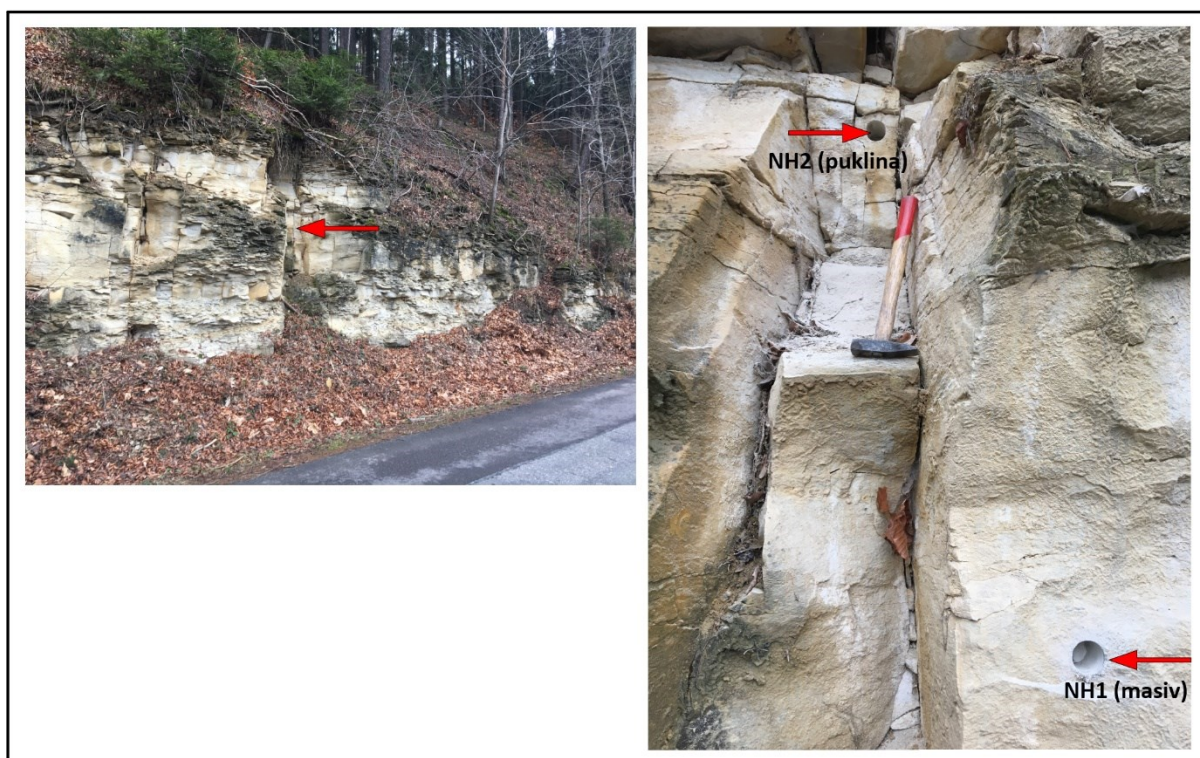
Obr. 6-37 Fotodokumentace výchozu jemnozrnných vápnitých pískovců kolektoru B u Nových Hradů. V poruchové zóně se subvertikálními i subhorizontálními puklinami (vzorek NH2) byly zjištěny nižší obsahy kalcitu a vyšší porozita
