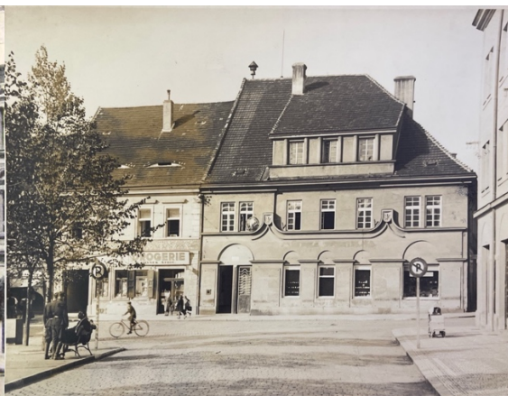
Obr. 9. Pohled na radniční budovu s úpravami fasády od Otakara Novotného. 30. léta.
