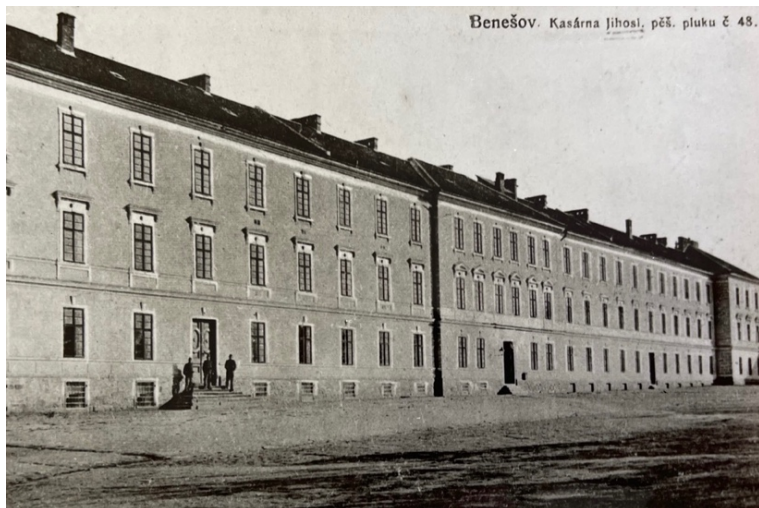
Obr. 6. Tábořská kasárna Jihoslovanského pěšího pluku č. 48. Snímek pořízený okolo roku 1920.
