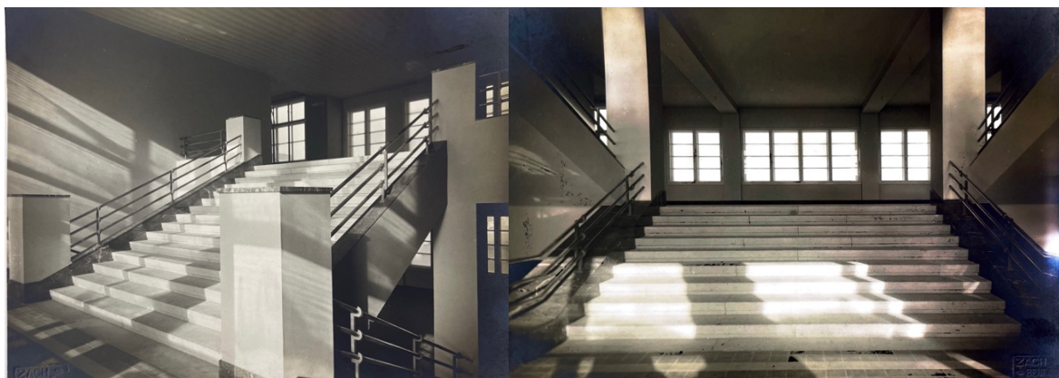
Obr. 33 a 34. Schodiště ve škole v Jiráskově ulici
