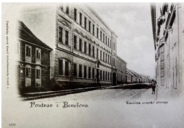
Obr. 7. Kasárna zemské obrany v Pražské ulici roku 1900. Původně byla budova zamýšlena pro dívčí školu.
