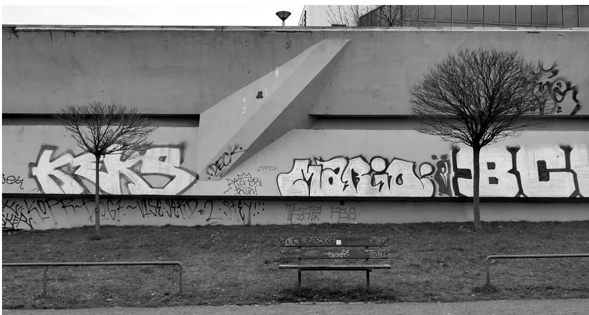
[26] Stanislav Kolíbal: Opěrná stěna Nuselského mostu , 1964-1969, beton, Praha
