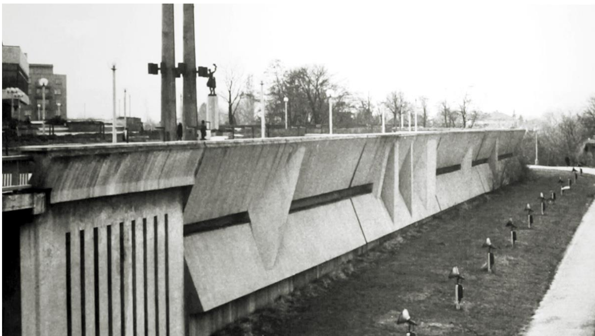
[25] Stanislav Kolíbal: Opěrná stěna Nuselského mostu , 1964-1969, beton, Praha
