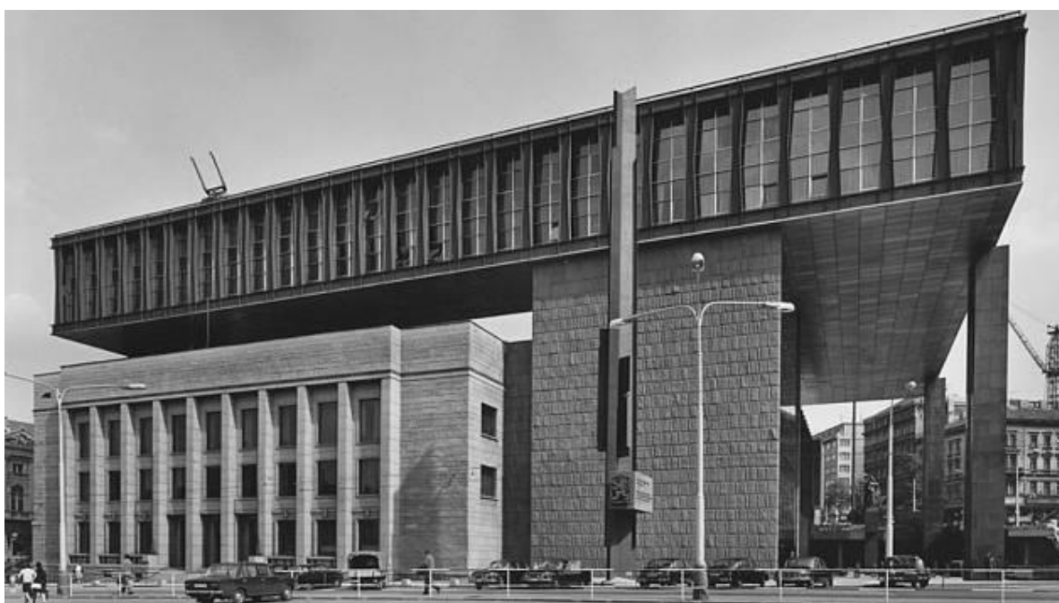
[20] Karel Prager: Pylon , 1968, ocel, před budovou bývalého Federálního shromáždění Praha
