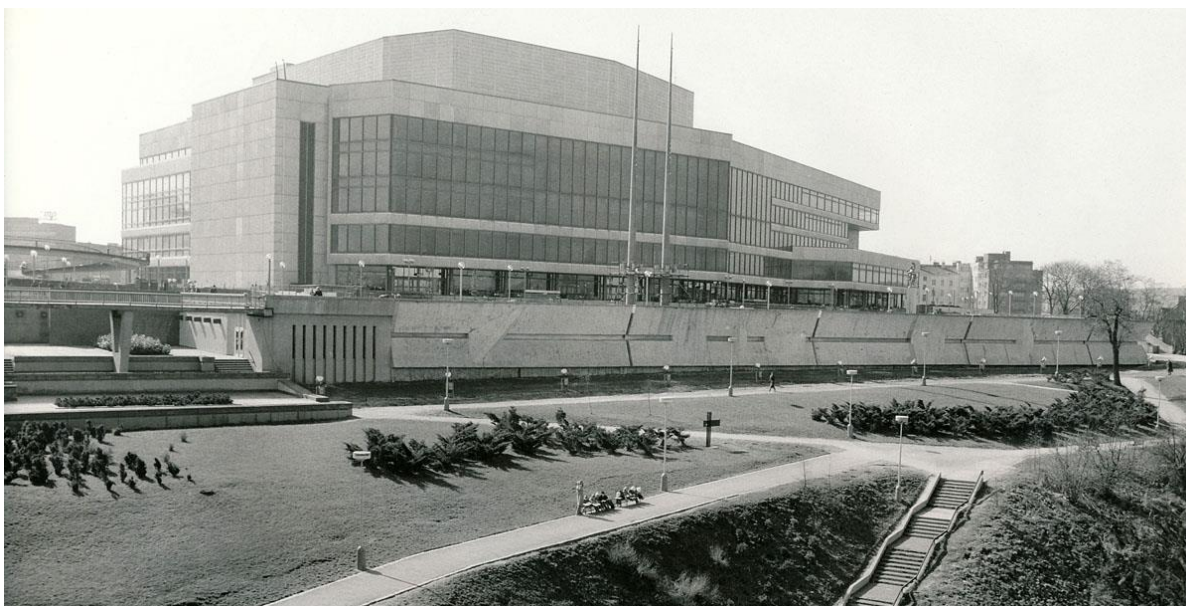
[24] Stanislav Kolíbal: Opěrná stěna Nuselského mostu , 1964-1969, beton, Praha
