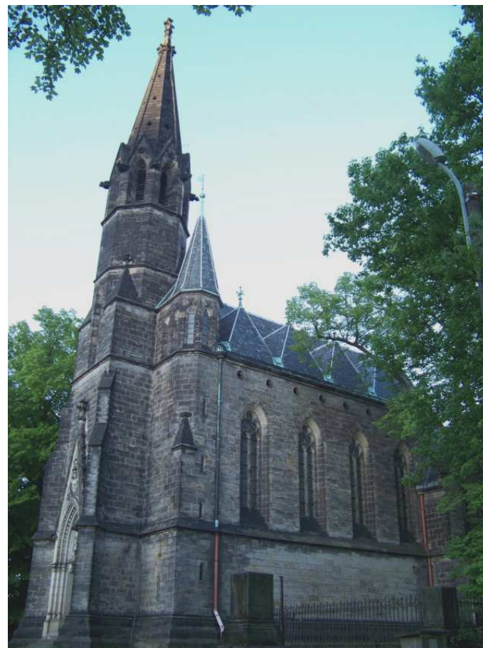
51. Děčín , Friedrich von Schmidt, kostel sv. Jana Nepomuckého, 1868–1872 pohled od jihozápadu.
