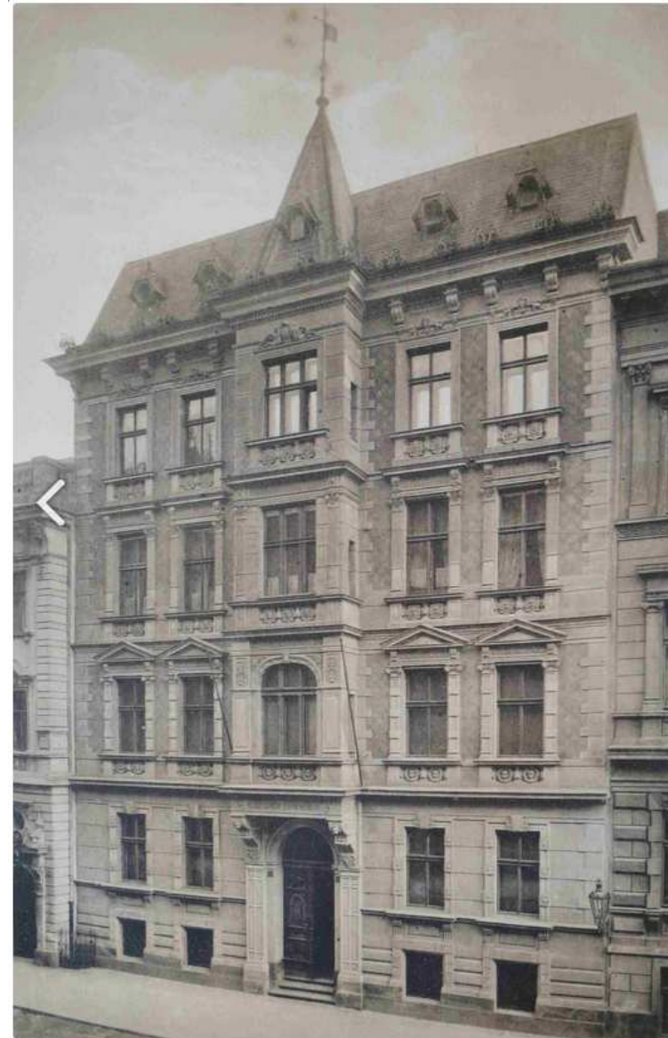
3. Praha, Stephan Tragl, dům č.p. 1606/II, 1881, Opletalova ulice.
