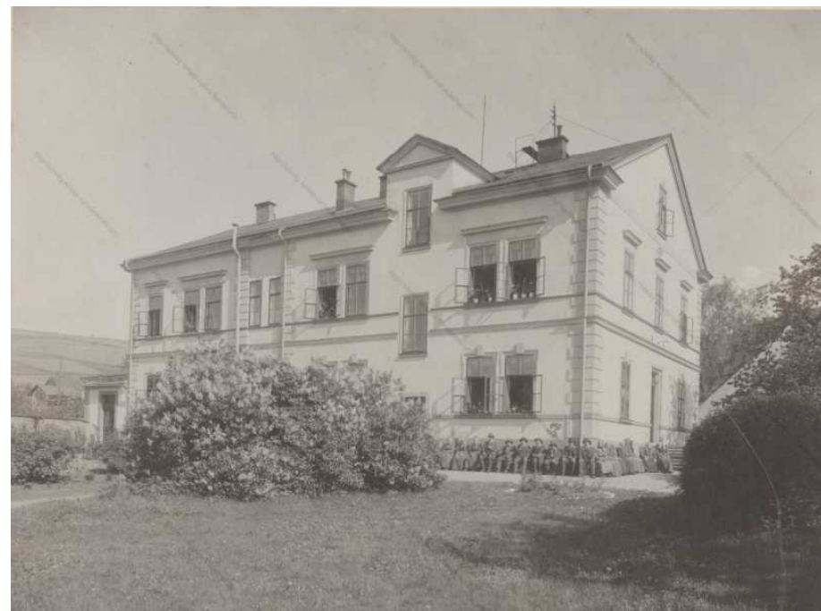
11. Vrchlabí, Stephan Tragl, špitál pro chudé, 1889, pohled na špitál pro chudé ze dvora.
