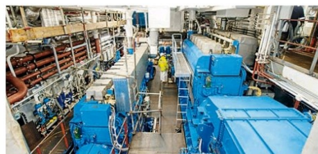
↑ Součástí dieselové lodní elektrárny jsou dva dieselové motory britské značky Rolls-Royce.
