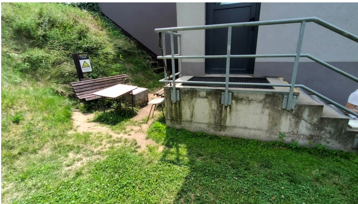
Obrázek 13 Schodiště u zázemí hrochů, lokalita 7C
