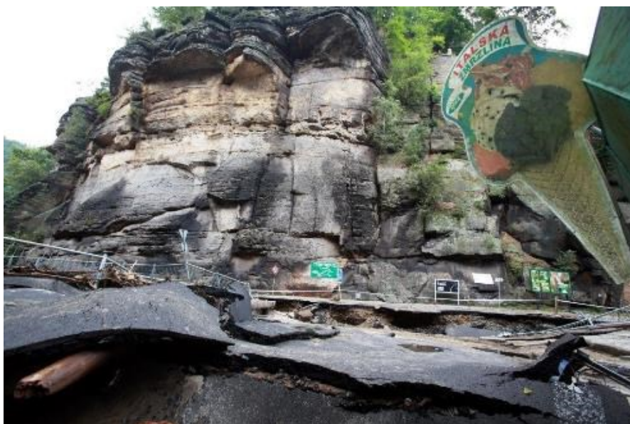
Obrázek 5: Zřícení skalních bloků na silnici z Děčína do Hřenska v roce 2009 a 2010. Zdroj: https://zpravy.aktualne.cz/regiony/ustecky/v-hrensku-zacala-sanace-skaly-prijde-na-32-milionu/r~i:article:756235/
