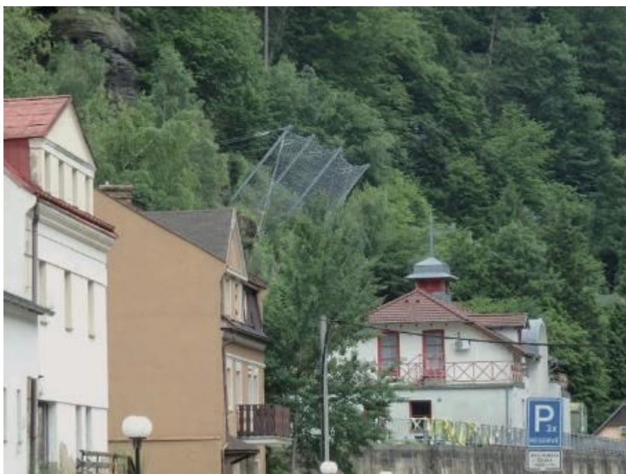
Obrázek 8: Síť pro zachycení padajících kamenů v Hřensku. Zdroj: https://www.academia.cz/uploads/media/preview/0001/04/e822515aacc8ad4fc571613b07ca076358473a9e1.pdf
