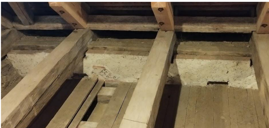
17. Restaurovaný fragment renesanční malby na zámeckých krovech zachovaný díky snižování podhledů druhého patra jižního křídla.
