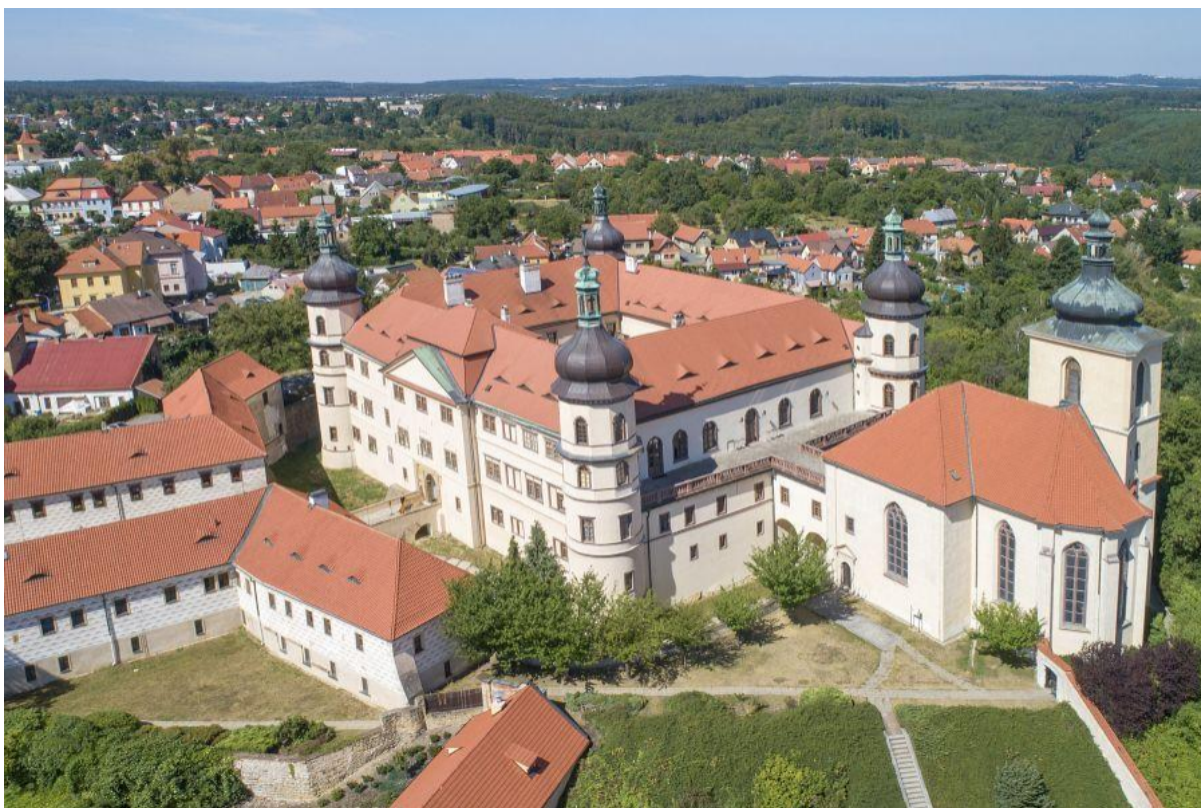
5. Celkový letecký pohled na zámek Kostelec nad Černými lesy.
