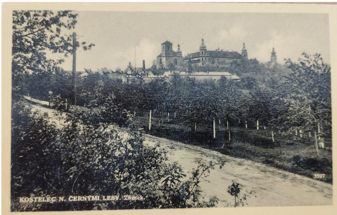
8. Pohled na zámek Kostelec nad Černými lesy, počátek 20. století. Viditelná je stanová střecha kaple a zakrytí propojovacího mostu sedlovou střechou.
