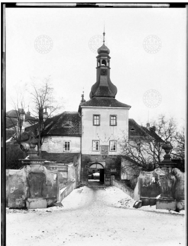
10. Pohled na předzámčí se zdobnými vázami, konec 19. století.
