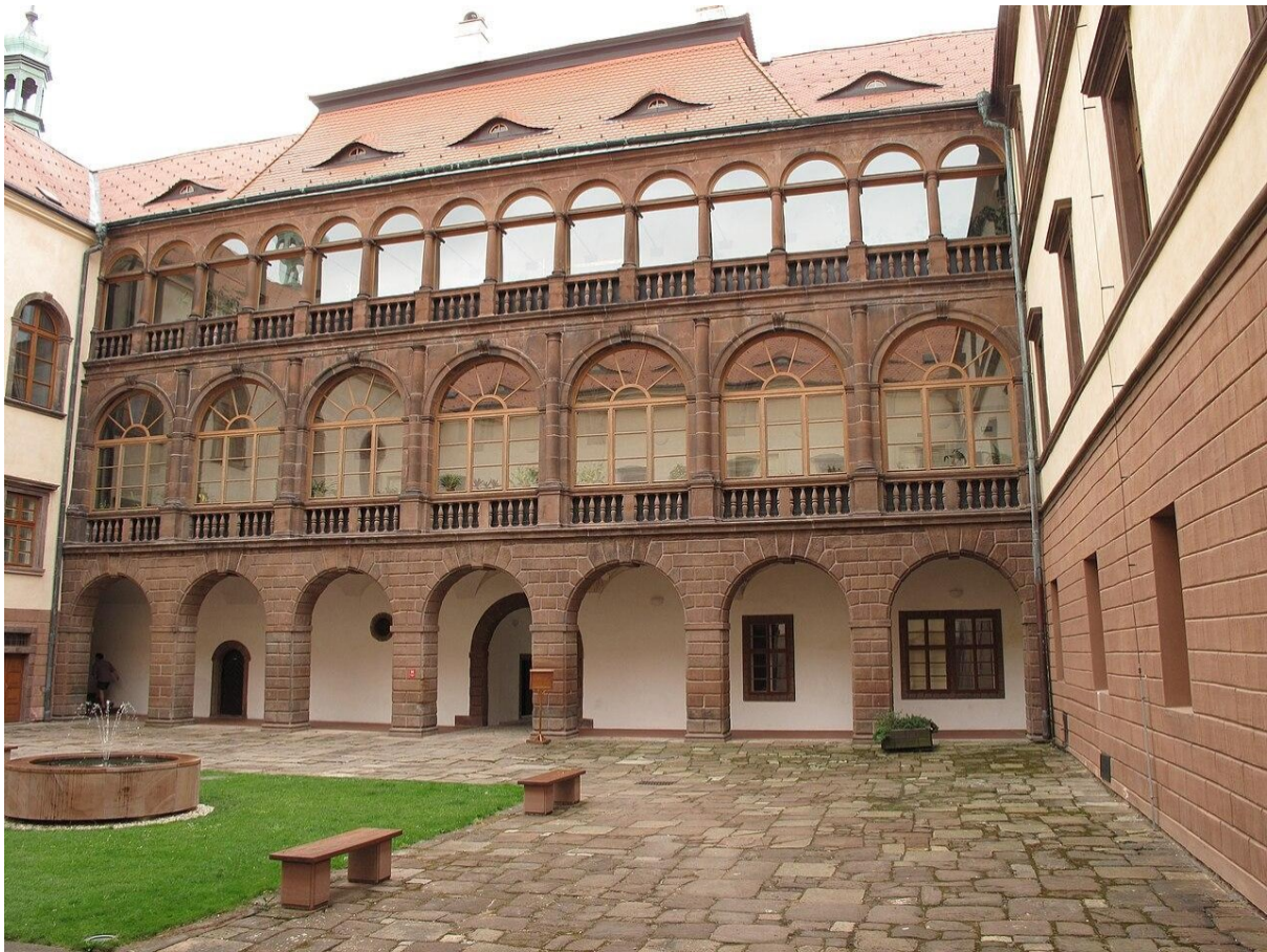
7. Druhé nádvoří zámku Kostelec nad Černými lesy, pohled na arkády jižního křídla ze severu
