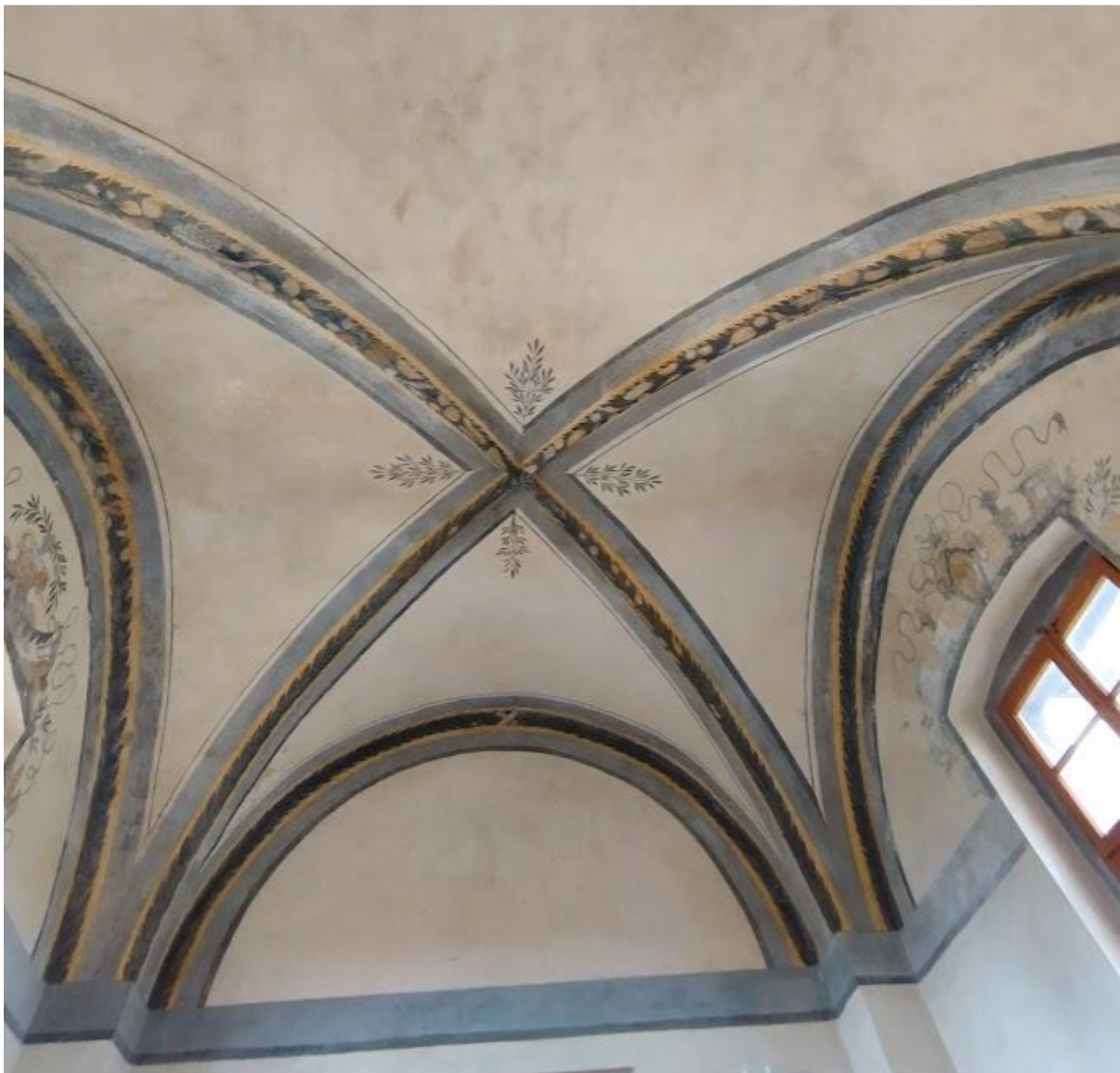
28. Křížová hřebínková klenba s malbami ovoce a vavřínovými větvickami, propojovací most zámku a zámecké kaple sv. Vojtěcha.
