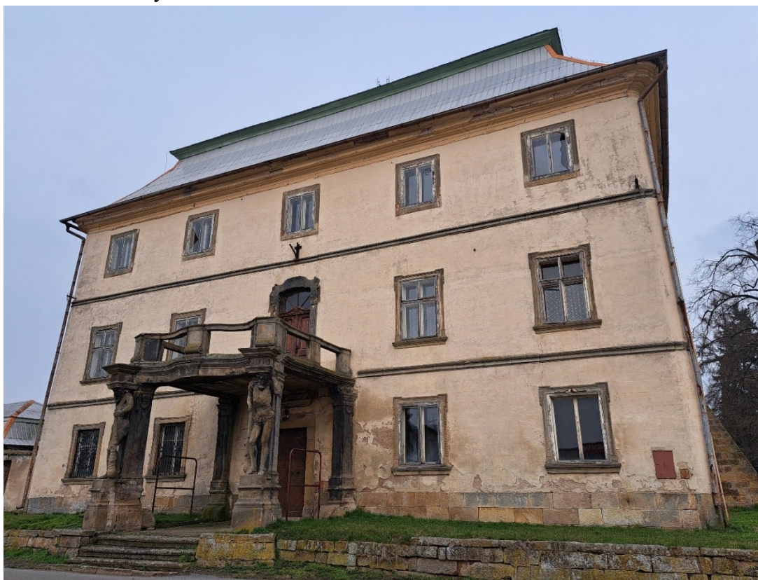
Obr. 44 – Vstupní průčelí s atlanty nesoucí balkon
