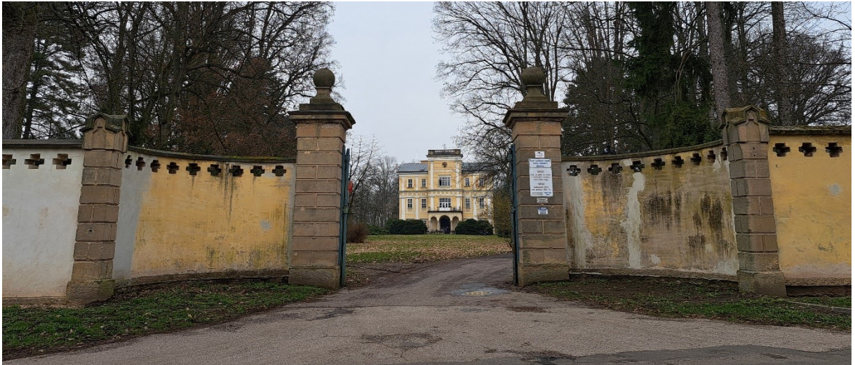
Obr. 24 – Vstup do zámeckého areálu
