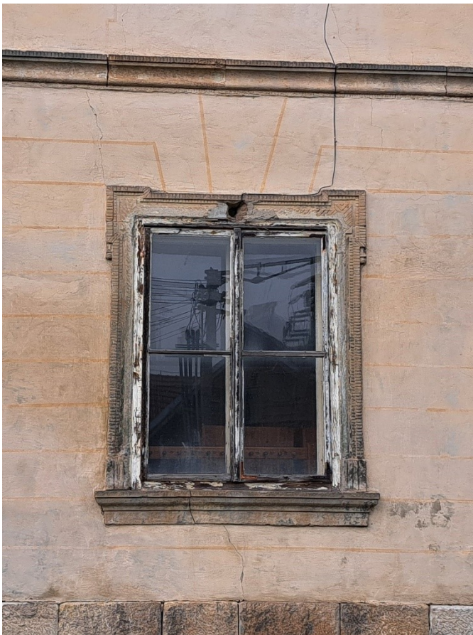
Obr. 46 – Detail okna s malbou
