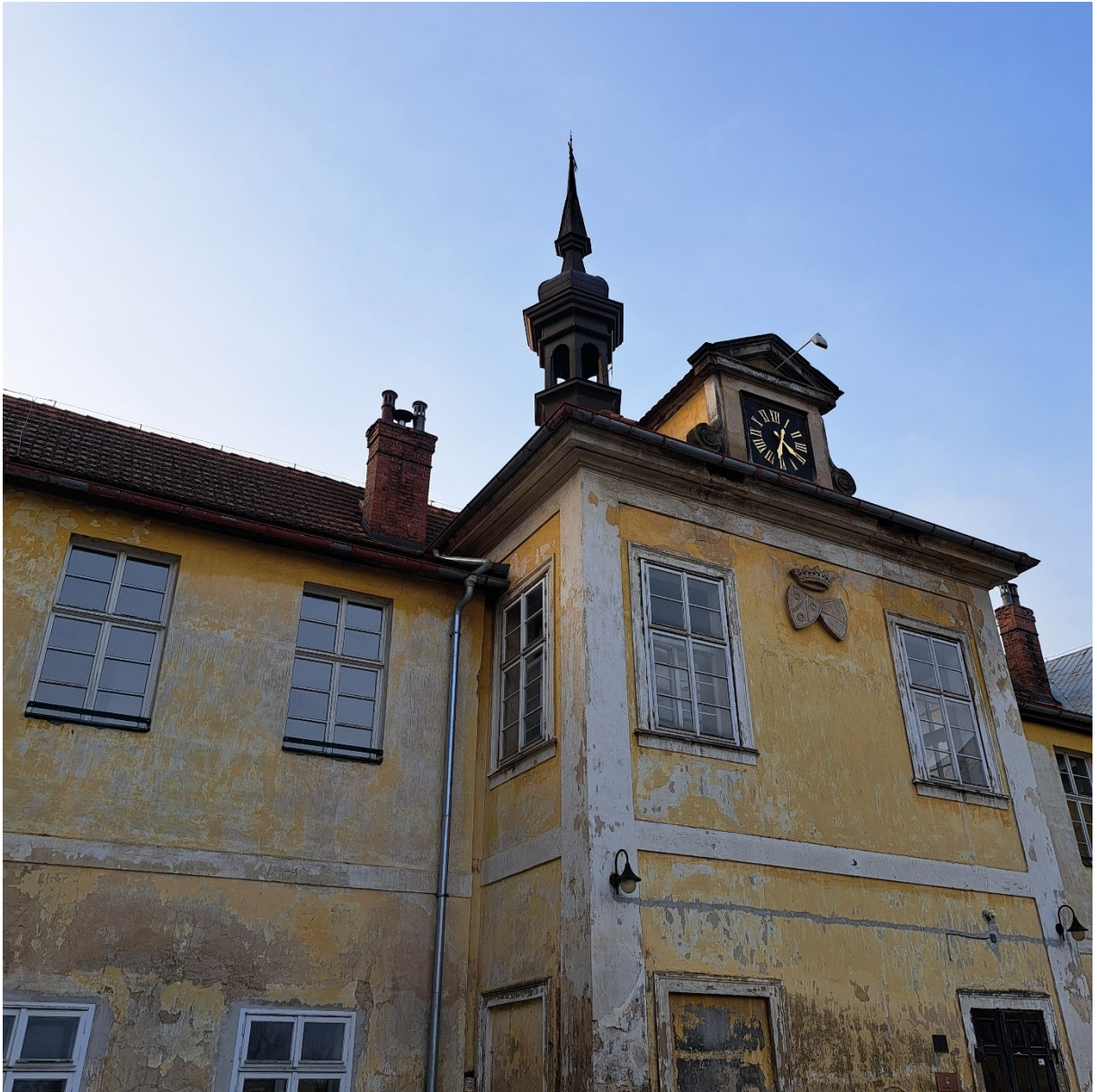
Obr. 38 – Detail vstupního rizalitu s hodinami a věžičkou
