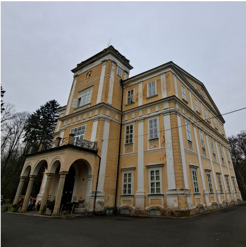
Obr. 25 – Hlavní a východní průčelí
