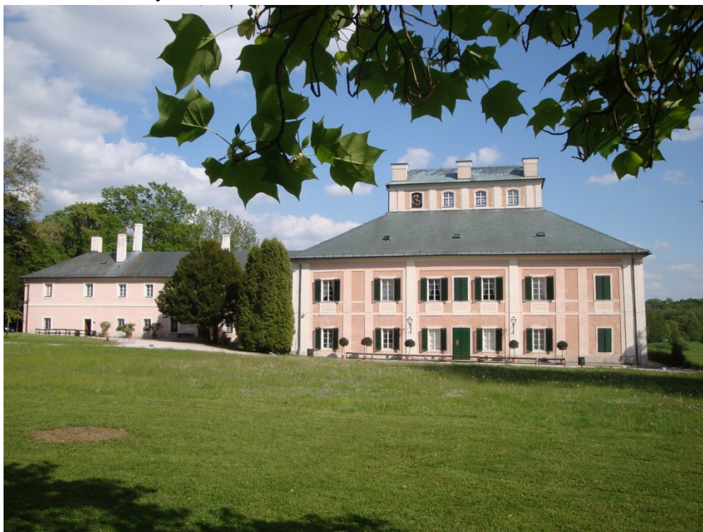
Obr. 28 – Vstupní průčelí se služebnickým křídlem 290
