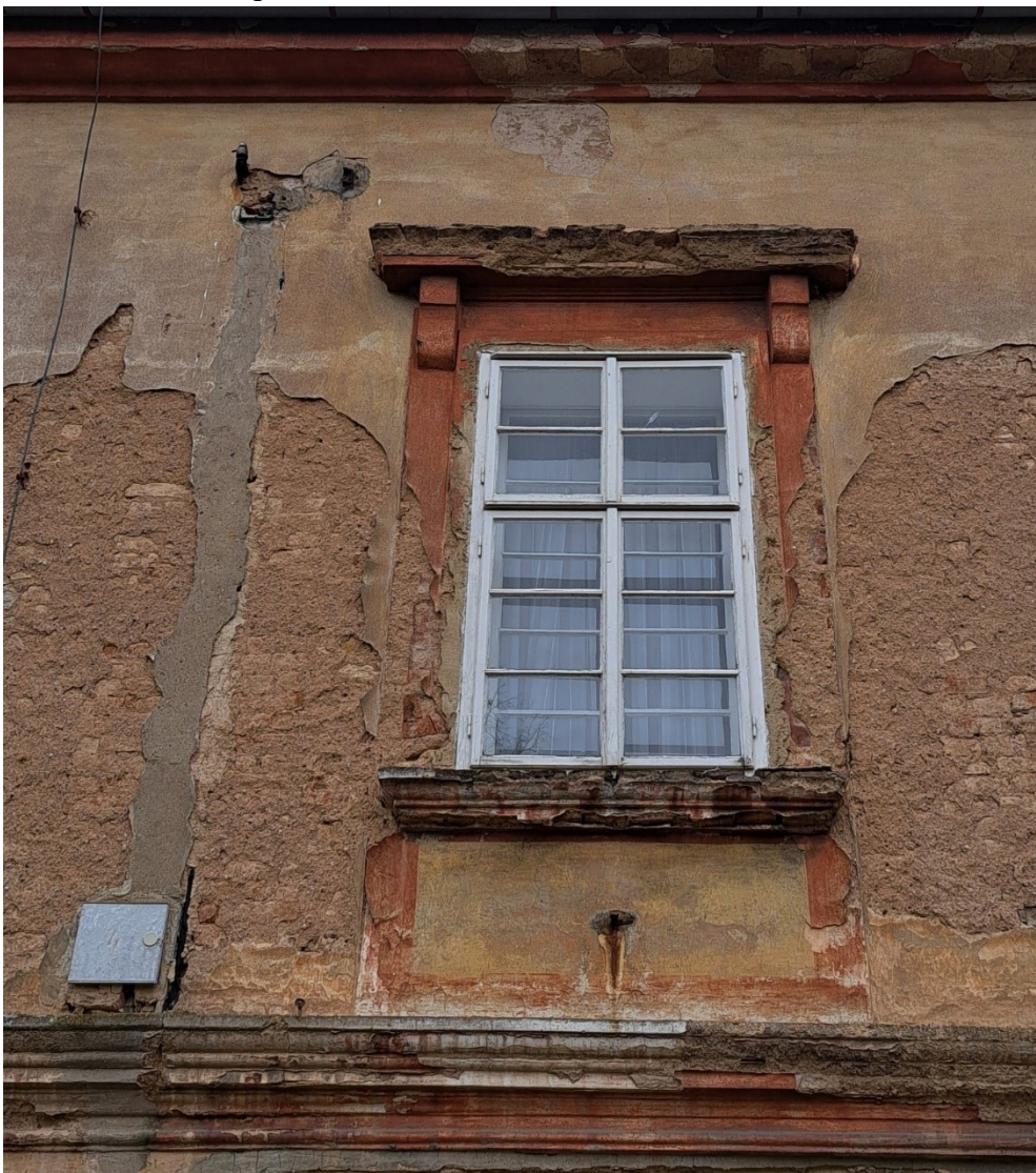
Obr. 34 – Detail okna se zbytky cihlové barvy, vlevo od okna vedení elektrického proudu
