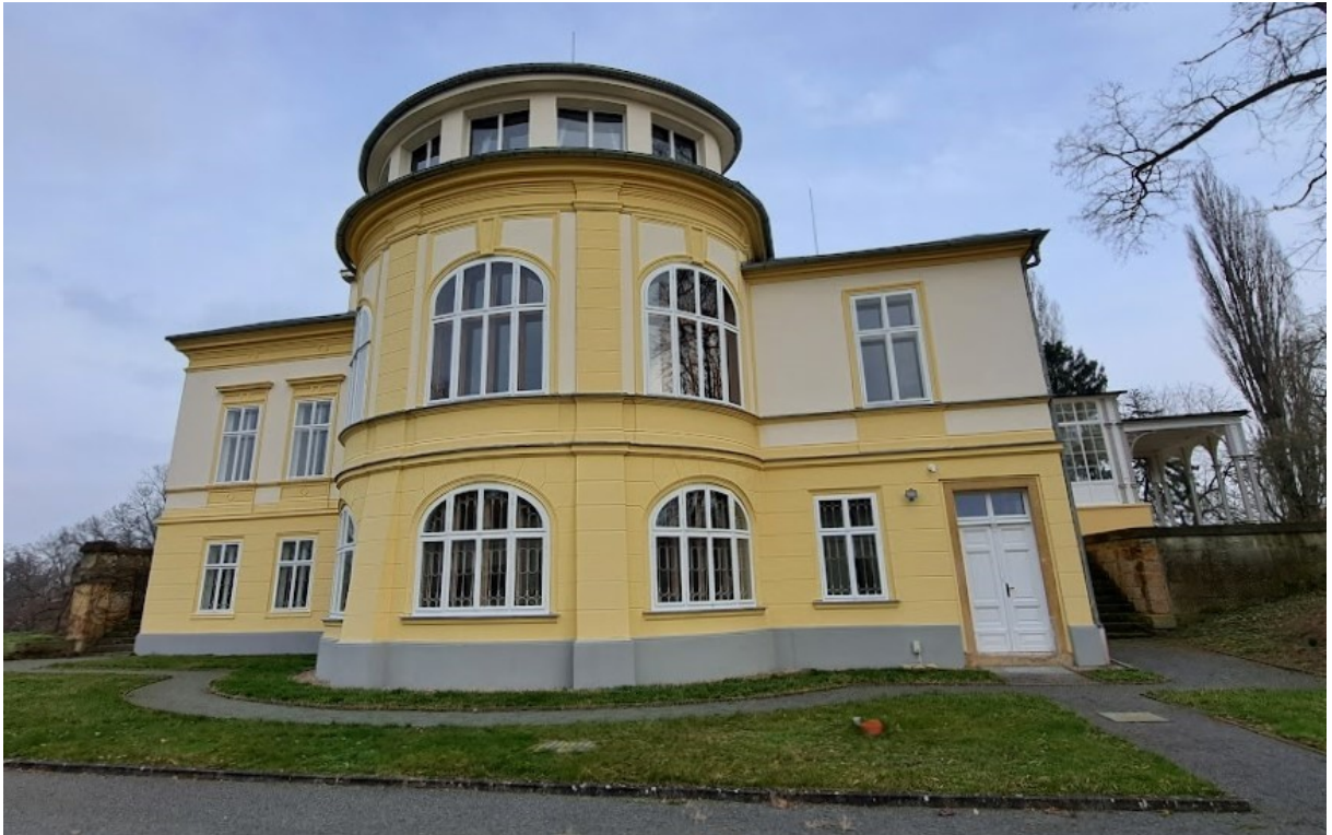
Obr. 8 – Pohled na jižní průčelí s půlkruhovým rizalitem
