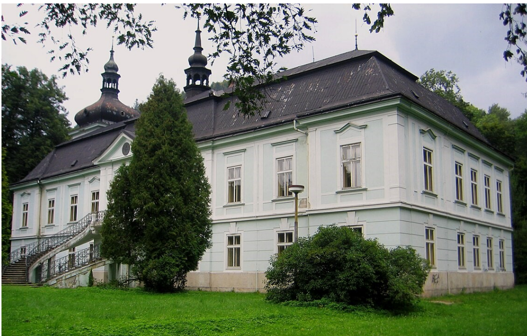
Obr. 12 – Jižní (vstupní) průčelí se schodištěm (stav před požárem) 223
