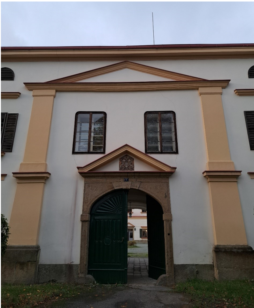
Obr. 19 – Pohled na průjezdová vrata
