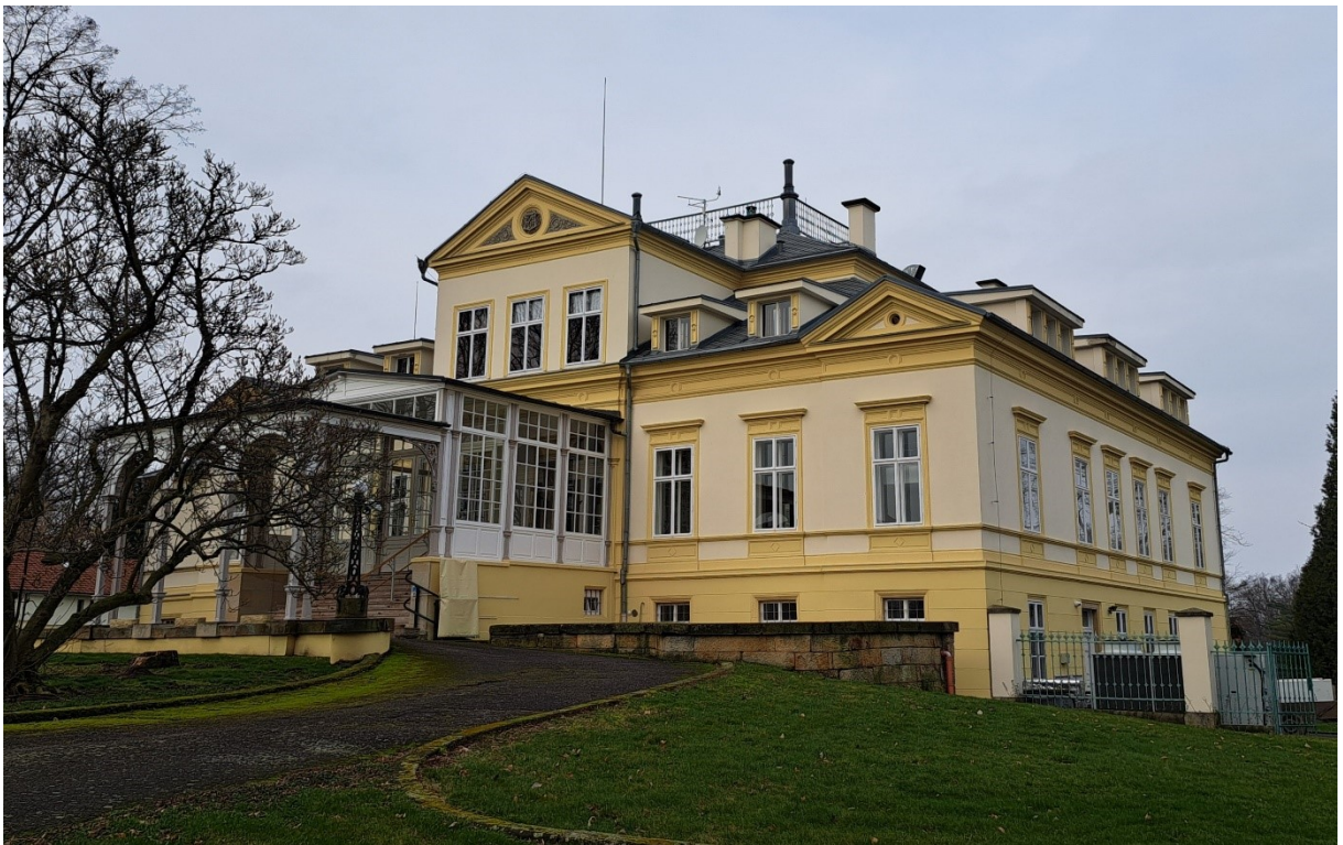
Obr. 7 – Pohled na vstupní (východní) a severní průčelí
