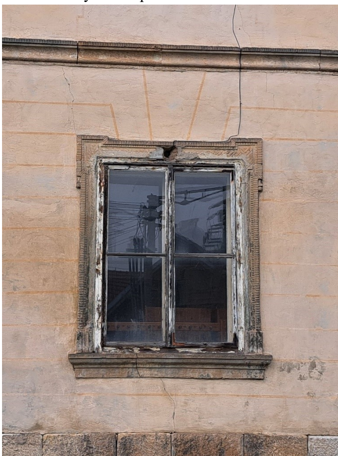
Obr. 46 – Detail okna s malbou
