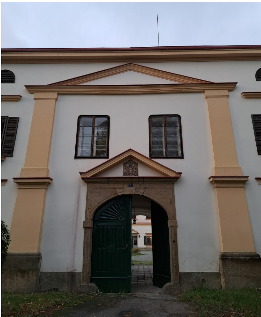
Obr. 19 – Pohled na průjezdová vrata
