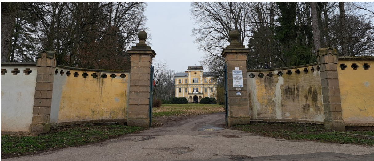
Obr. 24 – Vstup do zámeckého areálu
