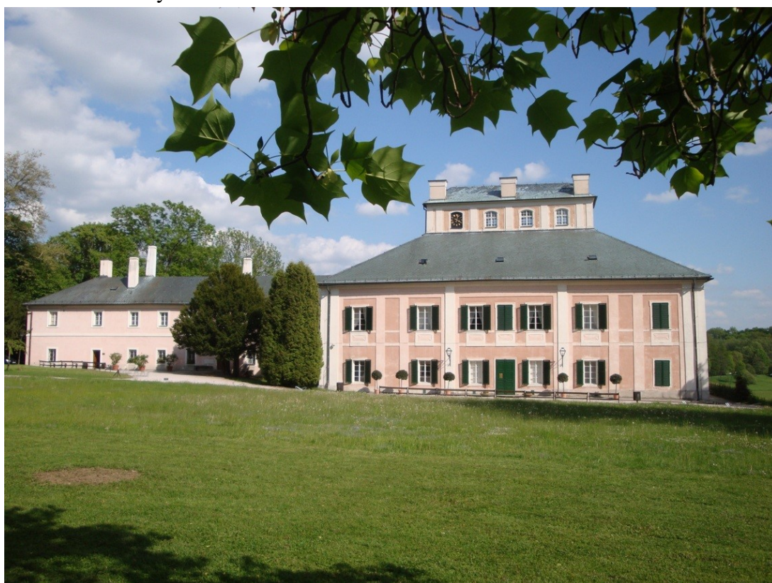
Obr. 28 – Vstupní průčelí se služebnickým křídlem 6
