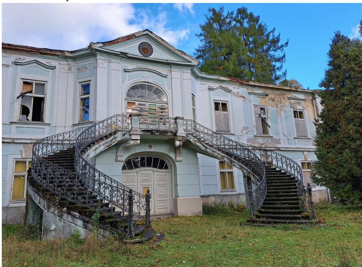
Obr. 11 – Jižní (vstupní) průčelí se schodištěm (stav k podzimu 2023)
