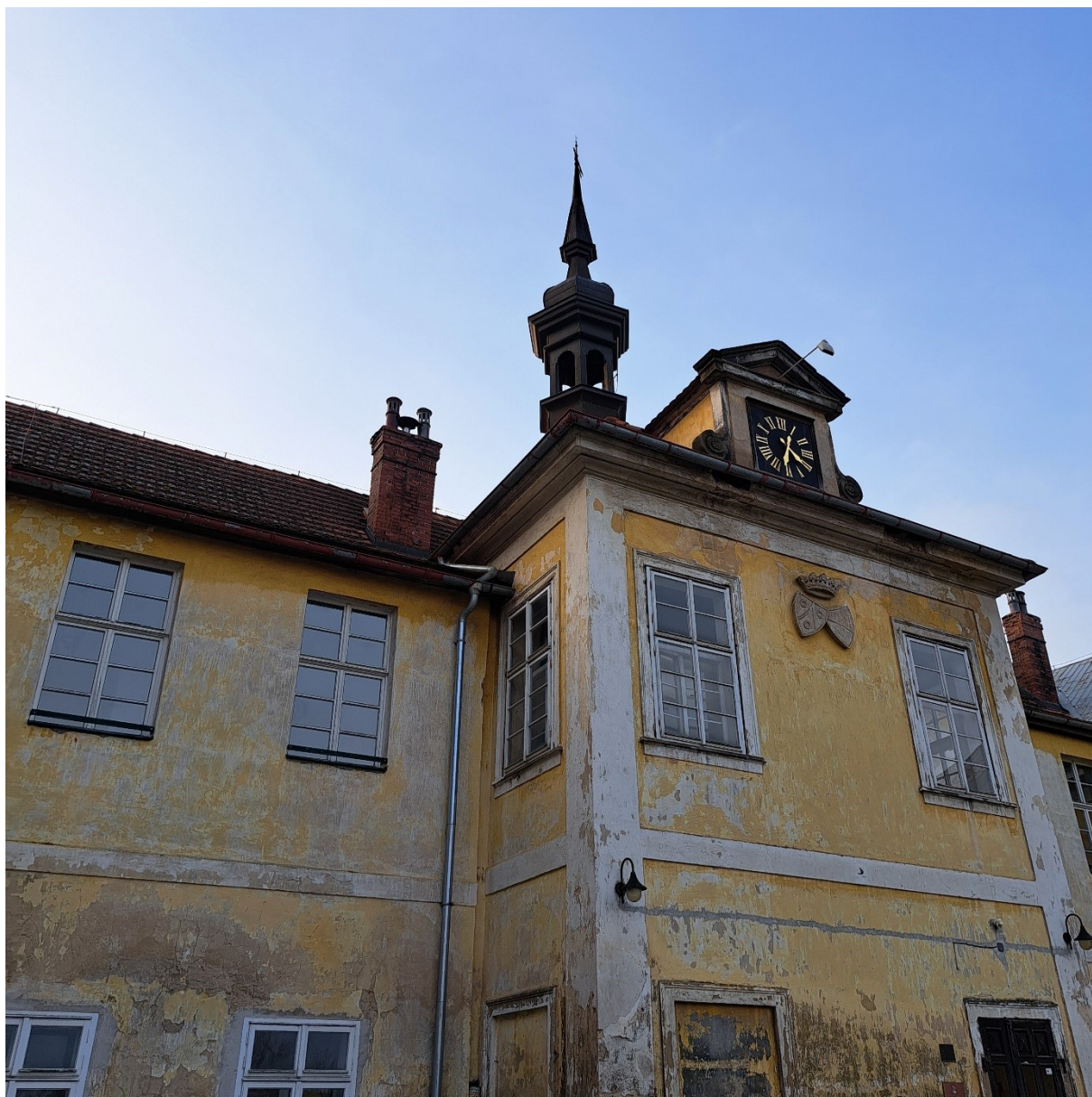
Obr. 38 – Detail vstupního rizalitu s hodinami a věžičkou
