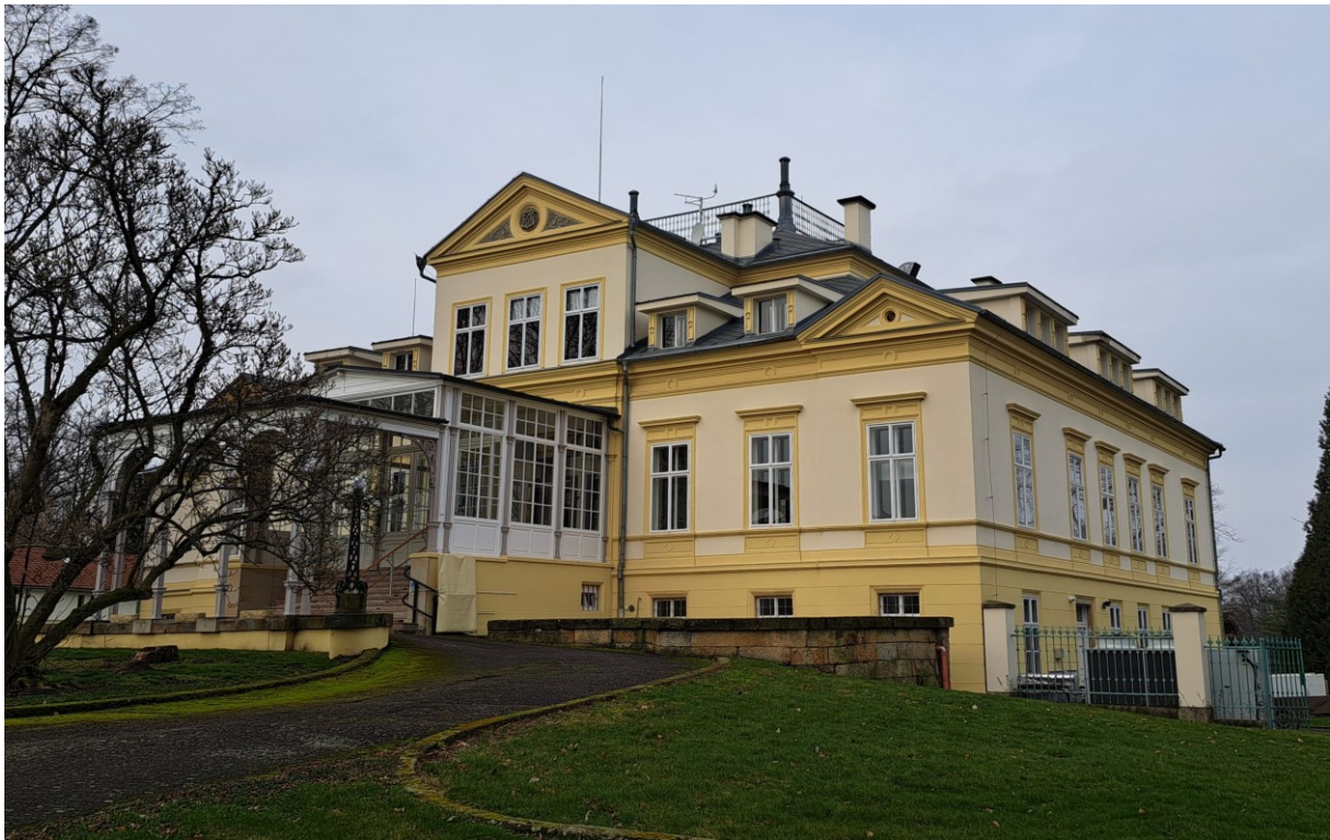
Obr. 7 – Pohled na vstupní (východní) a severní průčelí
