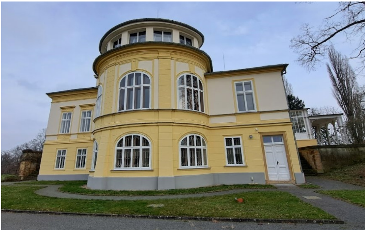
Obr. 8 – Pohled na jižní průčelí s půlkruhovým rizalitem
