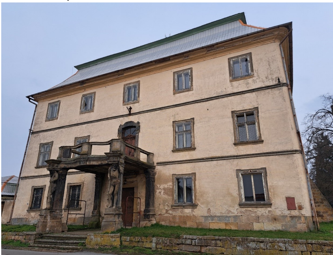
Obr. 44 – Vstupní průčelí s atlanty nesoucí balkon
