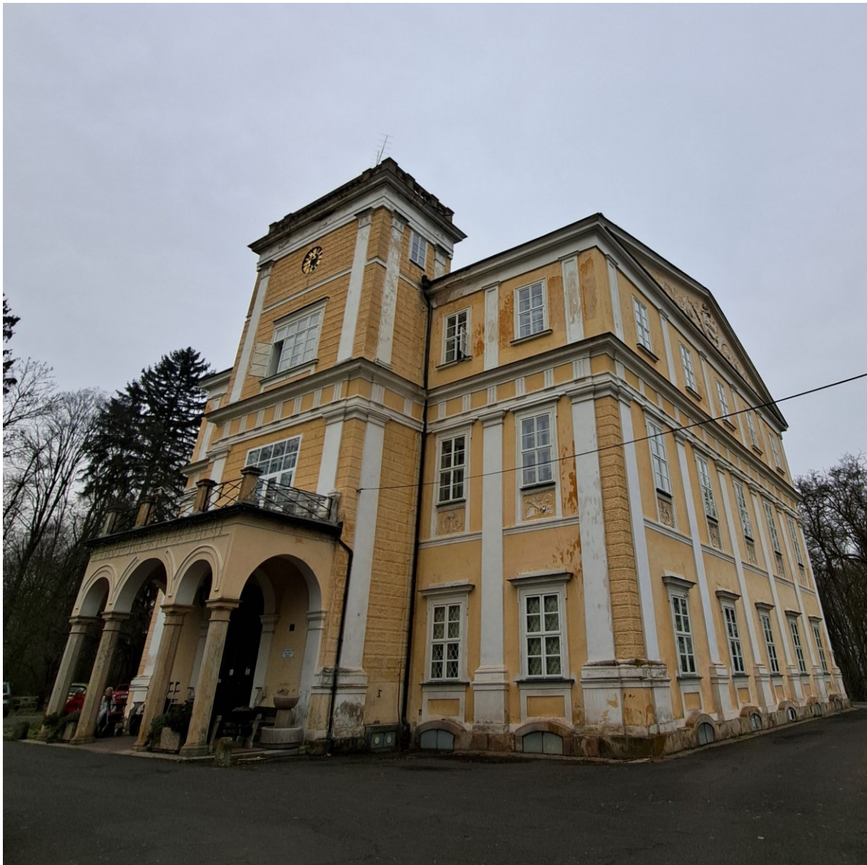
Obr. 25 – Hlavní a východní průčelí
