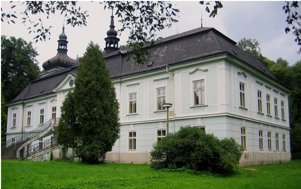
Obr. 12 – Jižní (vstupní) průčelí se schodištěm (stav před požárem) 2
