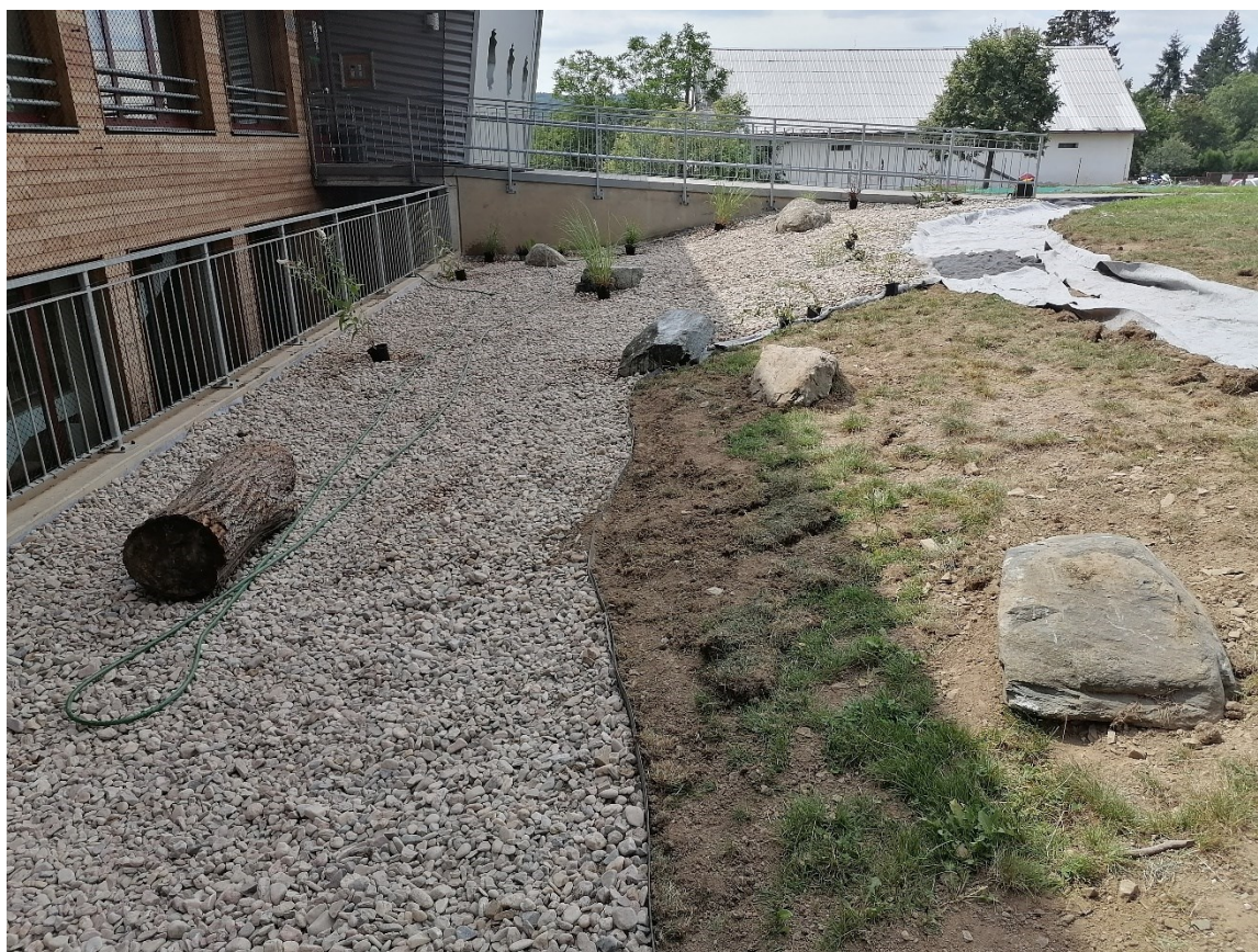
Obrázek č. 7 Průběh práce na budování školní zahrady- 2022
