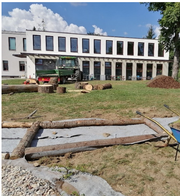
Obrázek č. 6 Průběh práce na budování školní zahrady – 2022 „Bosochodník“
