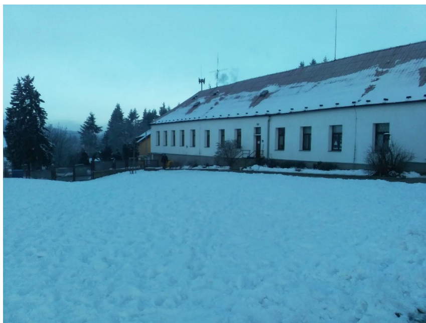
Obrázek č. 1 Část staré původní budovy školy před zahájením první rekonstrukce
