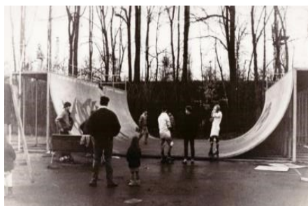
Kovová U-rampa, tvořící dominantu „Fučíkárny“ (foto: Jan Smolík)
