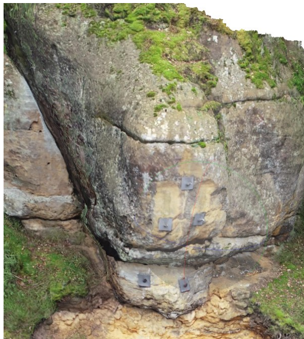
Obrázek 3 ukotvená skalní šupina pomocí hřebů v údolí Svitávky
