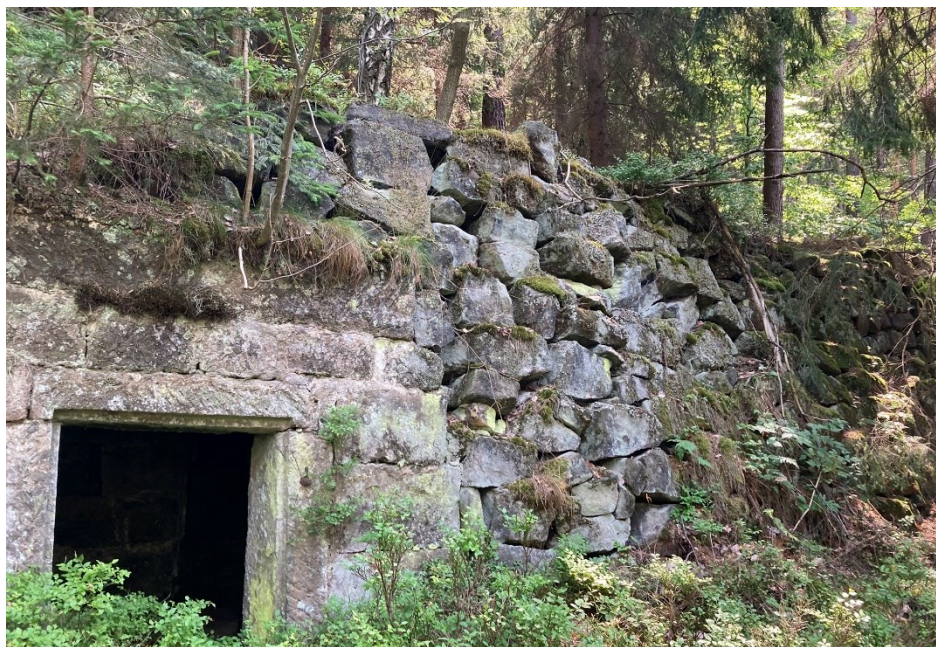
Obr. 8: sklípek na trhaviny v lomu Commite Steinbruch
