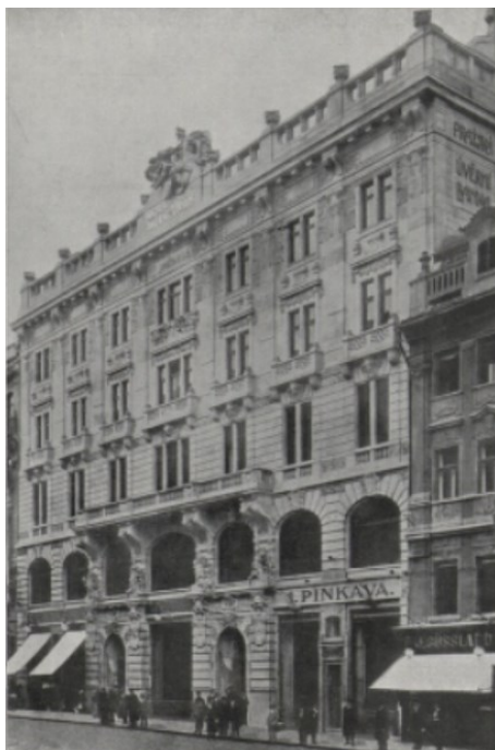
Příloha č. 5: Sídlo Pražské úvěrní banky v Praze Na Příkopech (architekt Matěj Blecha) 401
