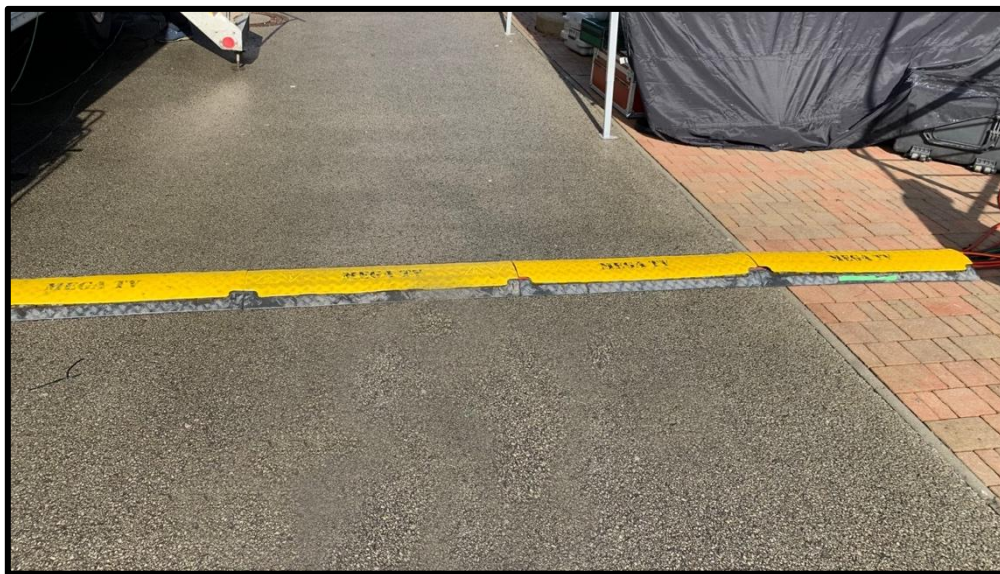
Obrázek 85: Ukázka využití kabelového mostu během zápasu
