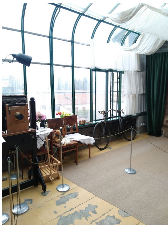
Obrázek 5 – konstrukce oken ve fotografickém ateliéru Seidel v Českém Krumlově pro dostatečný přísun světla (vlastní fotografie)
