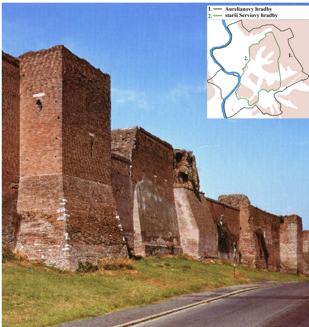
Obr. 54: Jedna z dochovaných částí Aureliánových městských hradeb. Celý pás opevnění měřil na délku 19 km. Zdi byly 6 až 10 metrů vysoké a zesílené o celkem 383 věží. Skrze hradbu se dalo projít pomocí 18 hlavních bran. Svou fortifikační funkci hradby plnily až do 19. století; zdroj: HINTZEN-BOHLEN 2008, 394 (fotografie doplněna o mapku s průběhem Aureliánových hradeb a starší tzv. Serviovy hradby z období republiky).
