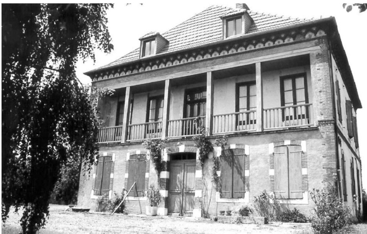
Obrázek 55 - Bývalé děkanství – budova byla zrestaurována v roce 2007. Zdroj: < https://www.pouyastruc.fr/le-village/histoire-patrimoine >
