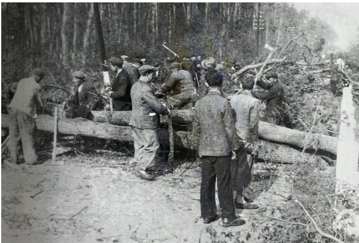
Příloha č. 230: Obyvatelé Třebestovic při stavbě záseků v Kerském lese 1060
