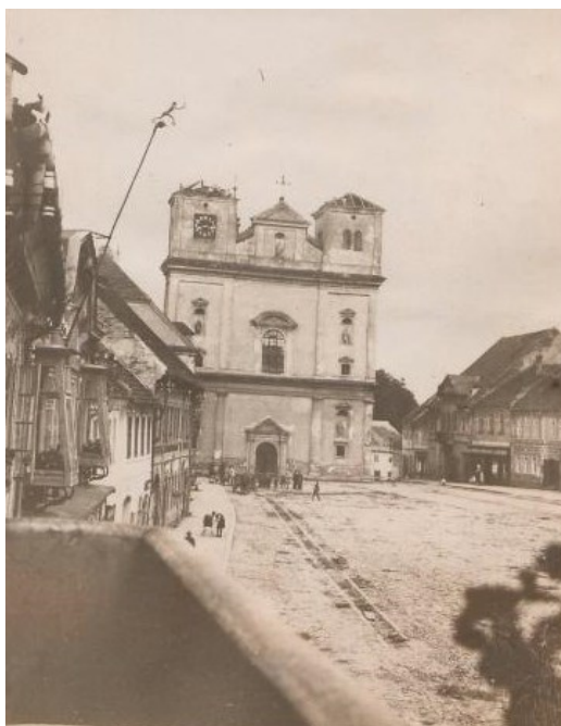
Obr 11 Oprava kostelních věží.
