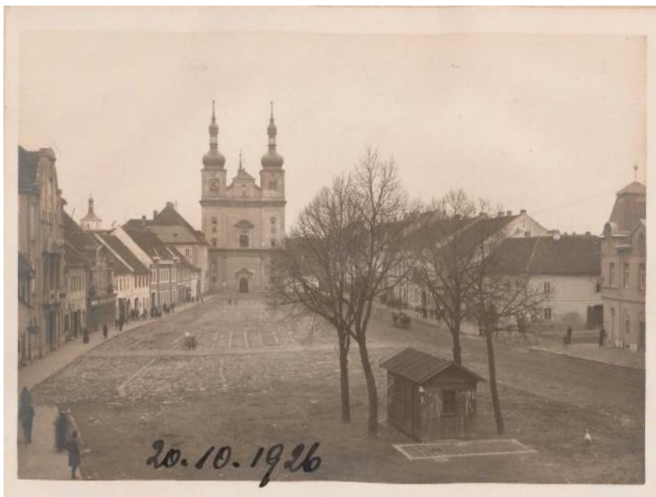
Obr 14 Kostel po opravě věží. Dobová fotografie z Pamětní kniha 1837–1945 , pag. 127.
