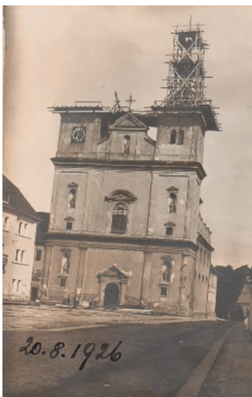
Obr 12 Pokračující opravy na farním kostele.
