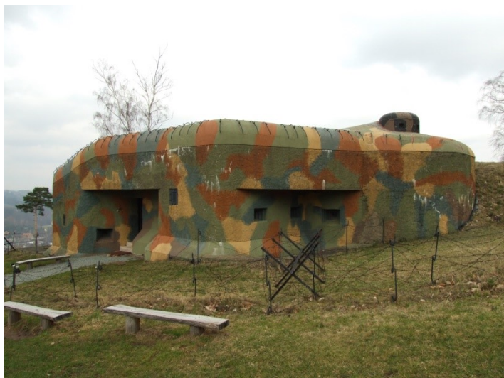
Obr. 16: Opravený pěchotní srub Březinka.
