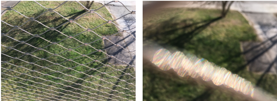
Obrázek 4.38: Odrážející se světlo na balkónovém oplocení
