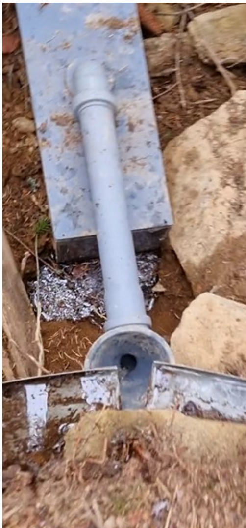
Obr. 6 Trychtýř s odvodňovacími plechy
