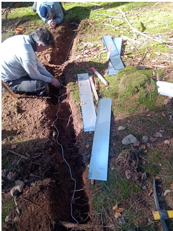
Obr. 4 Zhotovování odvodňovací jámy ve smrkovém lese
