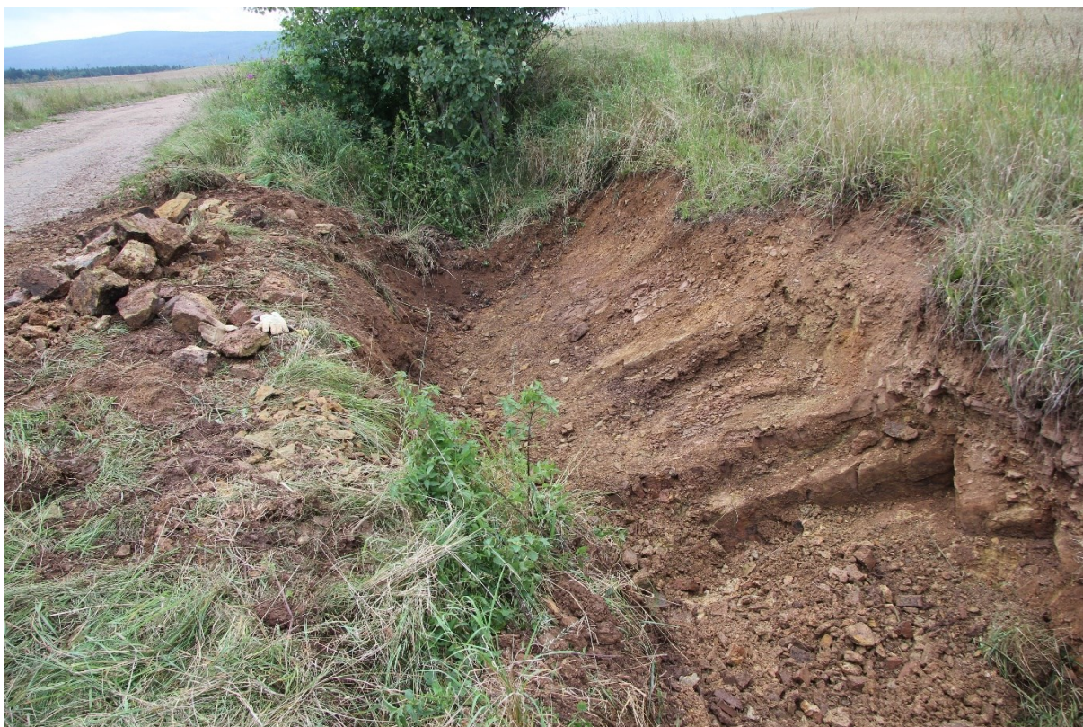
Obrázek 19: Profil Strašice u polní cesty do Těni při pohledu k jihozápadu. Vzhledem ke sklonu vrstev se báze profilu nachází v pravé spodní části snímku a pokračuje doleva nahoru směrem do nadloží. Foto z archivu Petra Krafta.
