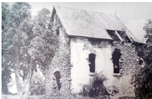
Kaple sv. Kříže v roce 1990 [31] a v roce 2024 [32]
