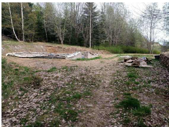
Obr. 46: Základy kaple sv. Šebestiána v roce 2024
