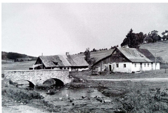
Obr. 18: Můstek v obci přes Zhůřecký potok kolem roku 1937 Zdroj: Horpeniak 2007
